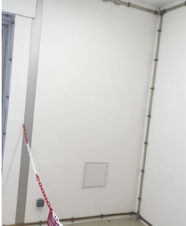
Figure 9 : Photo intérieur local Transfo – mur coupe-feu et ceinturage périphérique
