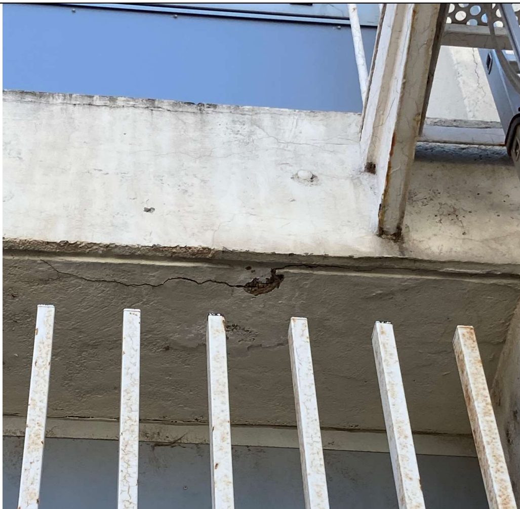
Figure 4 : Exemple de photos de repérage pour lesquelles des reprises de maçonnerie doivent être réalisées
