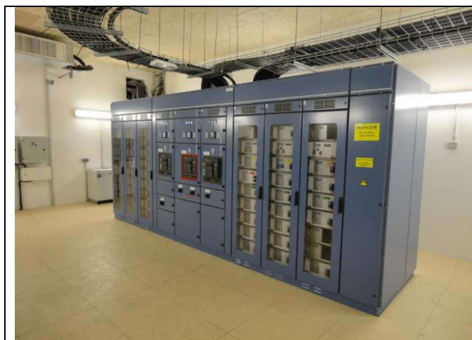
TGBT se trouvant au PRC (IS 233)
