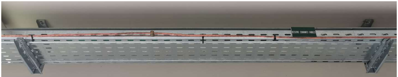
Figure 9 - Chemin de câbles à la terre et étiqueté
