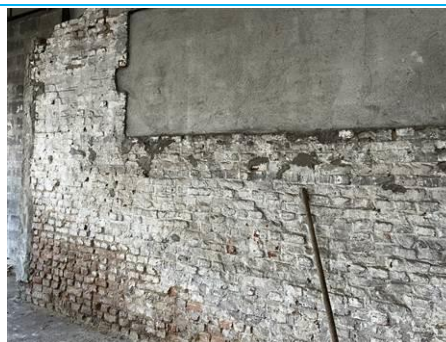
Matériaux : ZPSO-017 Prélèvement : P021; P022 Description : Enduit béton Localisation : Pièce 4 Résultat : Absence d'amiante
