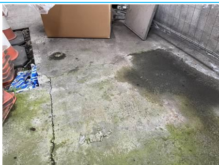
Matériaux : ZPSO-008 Prélèvement : P009; P010 Description : Ragrage Localisation : Pièce 4; Pièce 3; Pièce 2 Résultat : Absence d'amiante
