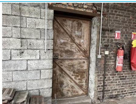
Matériaux : ZPSO-003 Prélèvement : P005 Description : Enduit béton Localisation : Pièce 1 Résultat : Absence d'amiante
