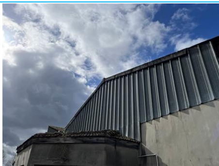
Matériaux : ZPSO-022 Prélèvement : Description : Panneaux Localisation : Parties extérieures Résultat : Absence d'amiante
