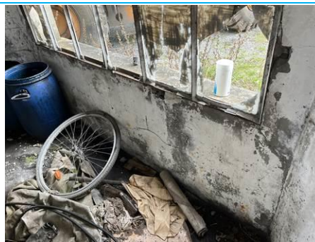
Matériaux : ZPSO-019 Prélèvement : P024; P025 Description : Enduit béton Localisation : Pièce 5; Pièce 6 Résultat : Absence d'amiante
