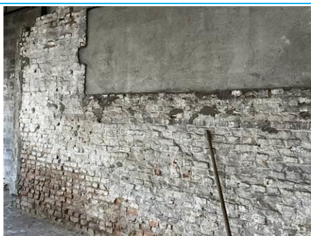
Matériaux : ZPSO-014 Prélèvement : P017 Description : Joint d'assemblage (Brique) Localisation : Pièce 4 Résultat : Absence d'amiante
