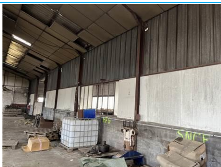
Ouvrage : 2 - Parois verticales extérieures et Façades - Façades légères, murs rideaux, bardages, panneaux sandwich Partie : Panneaux Description : Panneaux Localisation : Rdc - Pièce 3
