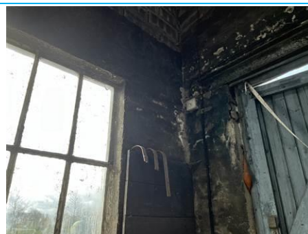
Matériaux : ZPSO-009 Prélèvement : P011; P012 Description : Enduit béton Localisation : Pièce 2 Résultat : Absence d'amiante
