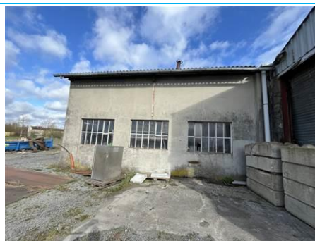
Matériaux : ZPSO-005 Prélèvement : P007; P008 Description : Joint de mastic de vitrage Localisation : Pièce 1 Résultat : Absence d'amiante
