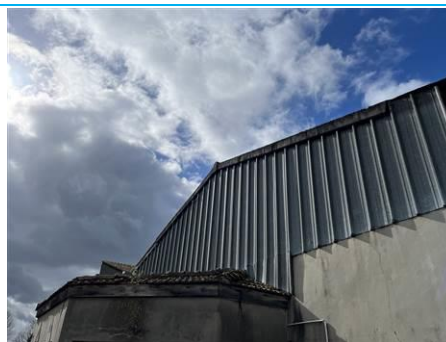
Matériaux : ZPSO-027 Prélèvement : Description : Plaques metal Localisation : Parties extérieures Résultat : Absence d'amiante
