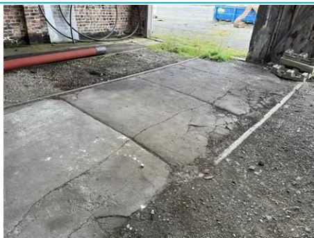
Matériaux : ZPSO-001 Prélèvement : P001; P002 Description : Ragréage Localisation : Pièce 1 Résultat : Absence d'amiante
