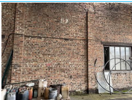
Matériaux : ZPSO-002 Prélèvement : P003; P004 Description : Joint d'assemblage (Brique) Localisation : Pièce 1; Pièce 2 Résultat : Absence d'amiante
