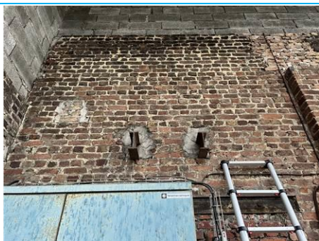
Matériaux : ZPSO-004 Prélèvement : P006 Description : Enduit lissage Localisation : Pièce 1 Résultat : Absence d'amiante
