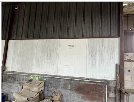
Matériaux : ZPSO-012 Prélèvement : Description : Panneaux de cloisons métal Localisation : Pièce 4 Résultat : Absence d'amiante
