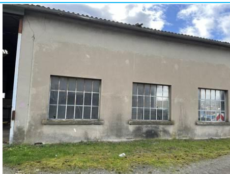
Matériaux : ZPSO-026 Prélèvement : P033; P034 Description : Enduit béton Localisation : Parties extérieures Résultat : Absence d'amiante
