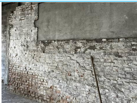
Matériaux : ZPSO-018 Prélèvement : P023 Description : Enduit béton Localisation : Pièce 3 Résultat : Absence d'amiante
