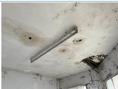
Matériaux : ZPSO-020 Prélèvement : P026; P027 Description : Enduit béton Localisation : Pièce 5; Pièce 6 Résultat : Absence d'amiante
