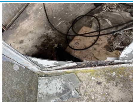
Matériaux : ZPSO-021 Prélèvement : P028; P029 Description : Joint de mastic de vitrage Localisation : Pièce 5; Pièce 6 Résultat : Absence d'amiante
