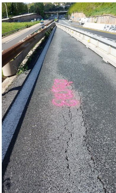
Illustration 5 : Fissures voie supérieure au droit des plots 16 et 17
