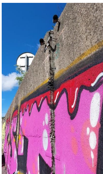
Illustration 7 : Basculement en tête plot 16 Est
