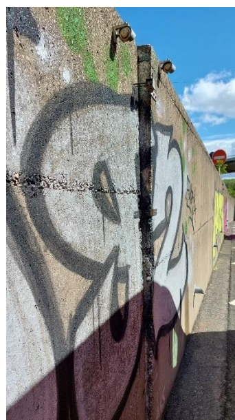
Illustration 8 : Basculement plot 17 Ouest
