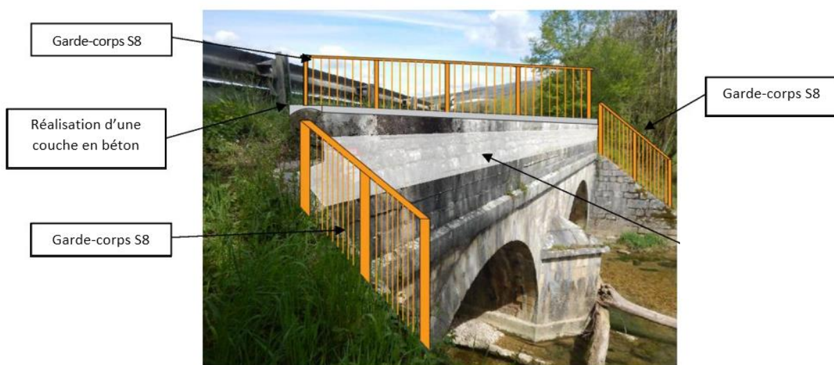
Figure 5 - Schéma de principe -garde-corps amont
