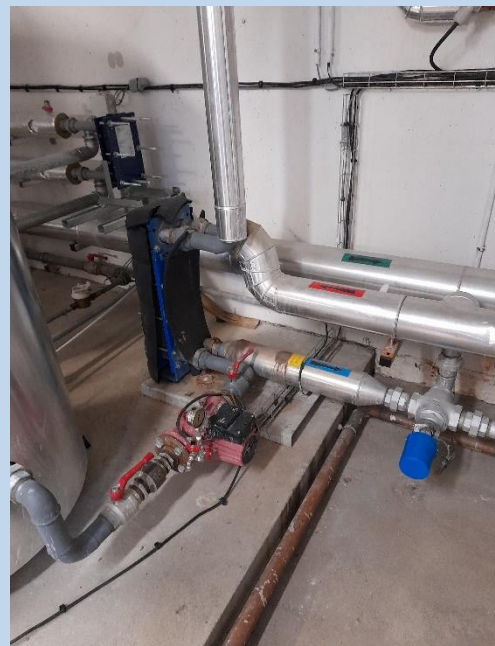
Échangeur, pompe et vanne 3 voies
