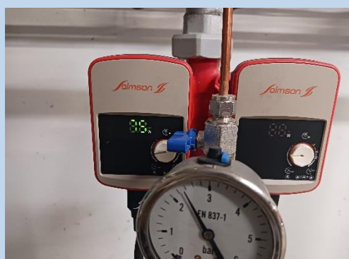
Pompe double circuit chauffage cuisines
