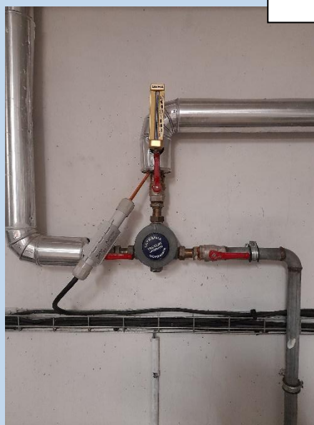
Mitigeur thermostatique et cordon chauffant
