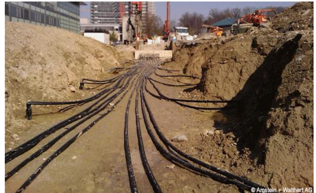
Figure 3 : Photographie d'un réseau de sondes géothermiques
