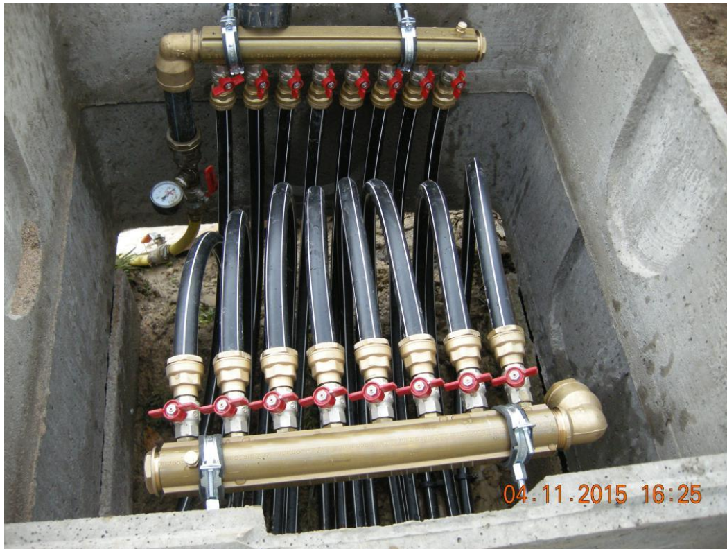
Figure 4 : Photographie d'un collecteur enterré
