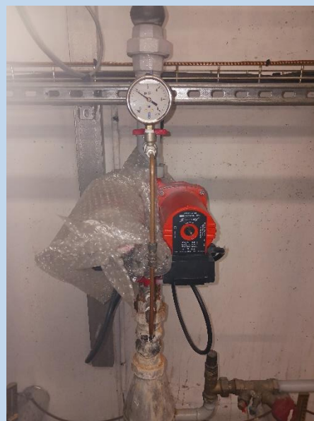
Pompe double circuit chauffage SAM
