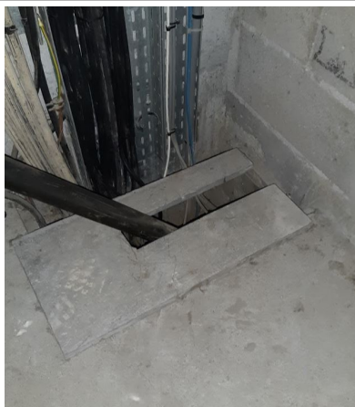
Déclaré - : R-1 / TGBT - Plaque - EP- (Présence d'amiante)
