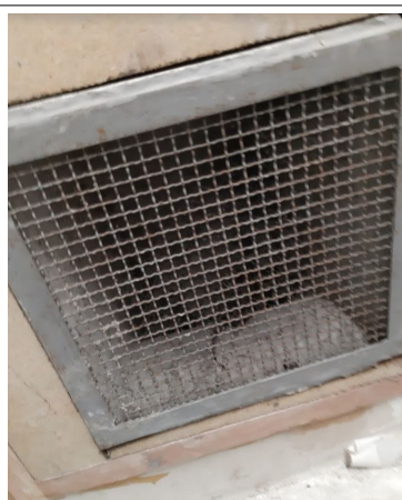
Déclaré - : RDC / Local technique ascenseur - Conduit - EP- (Présence d'amiante)
