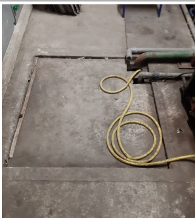
Déclaré - : R-1 / Local CTA - Plaque - AC1- (Présence d'amiante)
