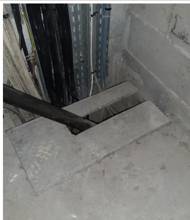
Déclaré - : R-1 / TGBT - Plaque - EP- (Présence d'amiante)
