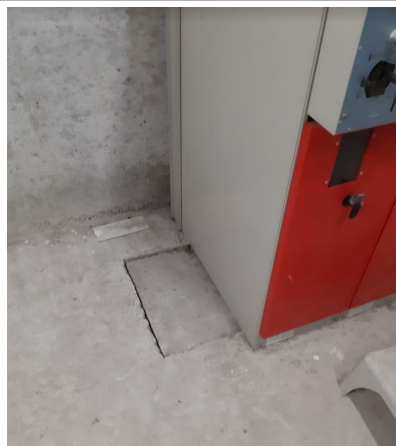
Déclaré - : R-1 / TGBT - Plaque - EP- (Présence d'amiante)
