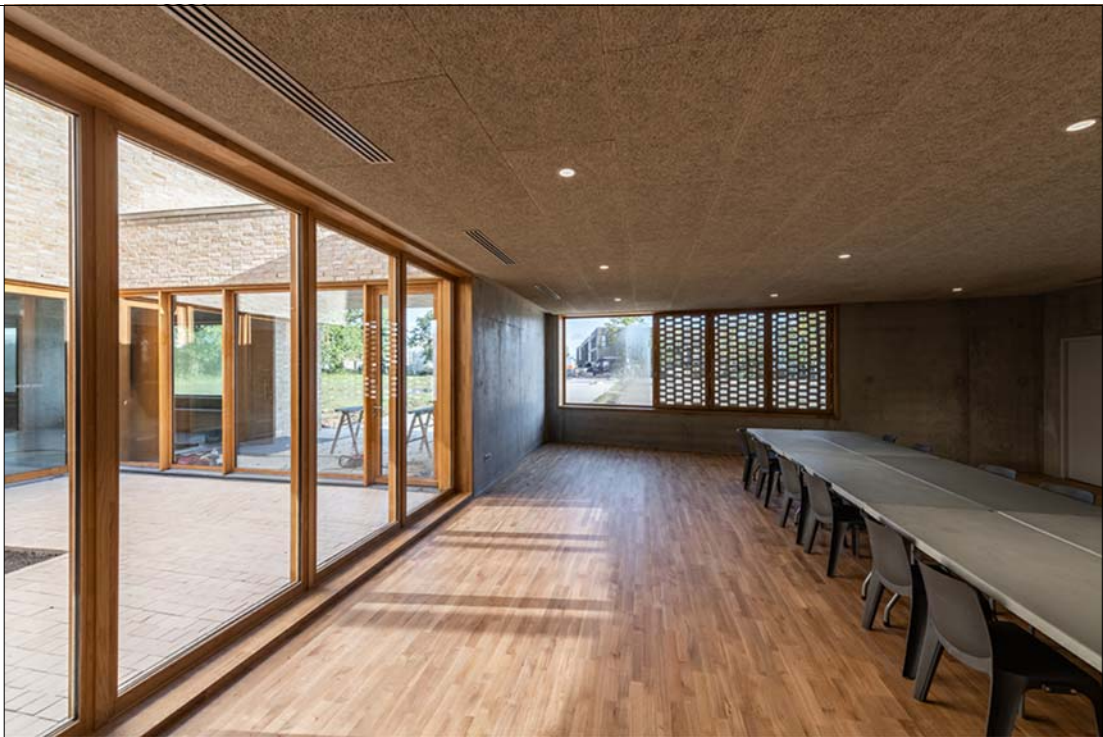
Faux plafond acoustique en fibres de bois teinte naturelle
