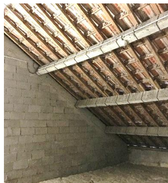
Figure 25-26 : Vues intérieures de la charpente béton du bâti 14
