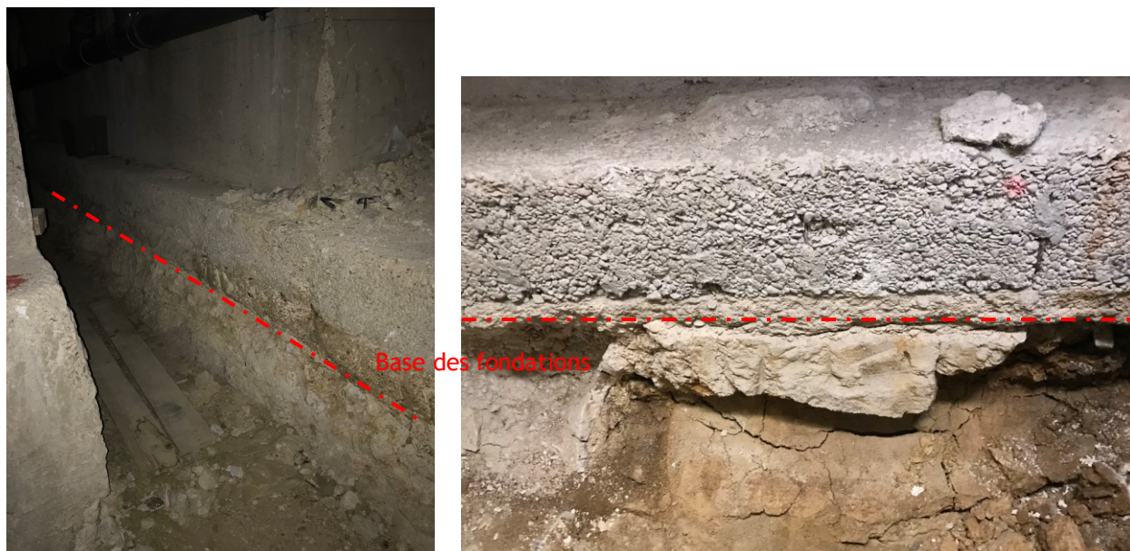
Figure 17 : photos des semelles déchaussées (bâtiments 13/14).
