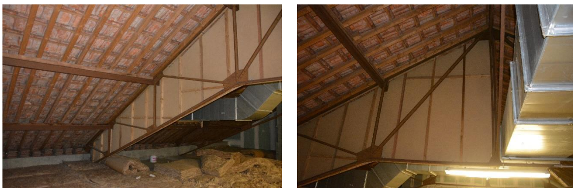
Figure 9-10 : Vues intérieures de la charpente métallique du bâti 3
