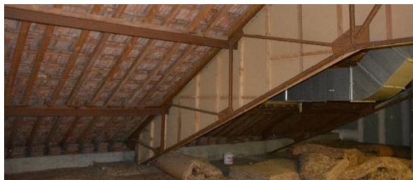
Figure 5 : Vue sur charpente métallique du bâti n°3
