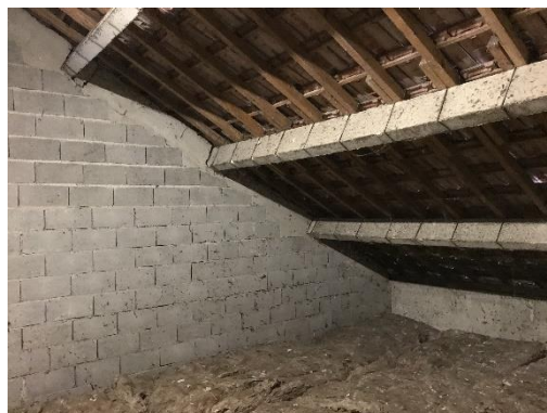
Figure 13-14 : Vues intérieures de la charpente béton du bâti 6
