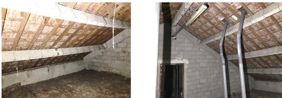
Figure 17-18 : Vues intérieures de la charpente béton du bâti 7
