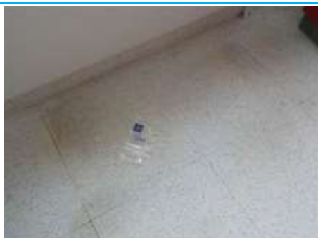
Matériaux : ZPSO-047 Prélèvement : P047 Description : Lé plastique + colle + ragréage Localisation : Rez de chaussée - Office Résultat : Absence d'amiante
