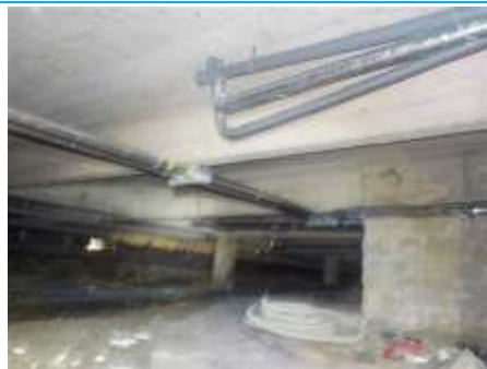
Matériaux : ZPSO-090 Prélèvement : Description : Conduites EU PVC Localisation : Vide-sanitaire - Vide sanitaire Résultat : Absence d'amiante
