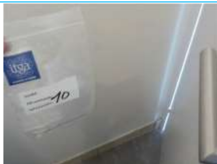
Matériaux : ZPSO-010 Prélèvement : P010 Description : Enduit murs Localisation : Sous-Sol - Wc 1 Résultat : Absence d'amiante
