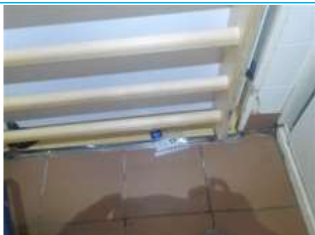
Matériaux : ZPSO-057 Prélèvement : P057 Description : Lé plastique + colle Localisation : Rez de chaussée - Salle de bains Résultat : Absence d'amiante
