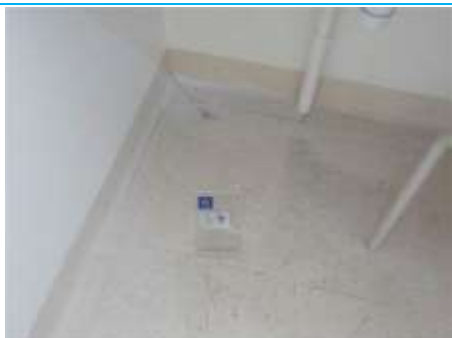
Matériaux : ZPSO-039 Prélèvement : P039 Description : Lé plastique + colle + ragréage Localisation : Rez de chaussée - SdB Ch. 10 Résultat : Absence d'amiante
