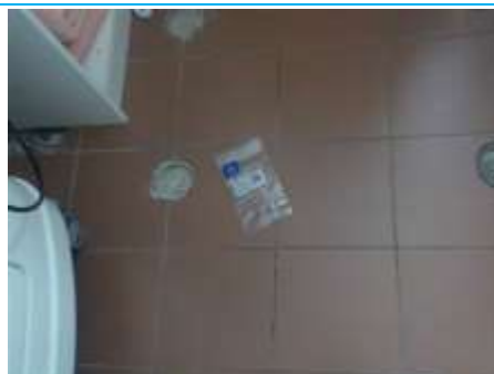
Matériaux : ZPSO-054 Prélèvement : P054 Description : Colle de carrelage Localisation : Rez de chaussée - Salle de bains Résultat : Absence d'amiante
