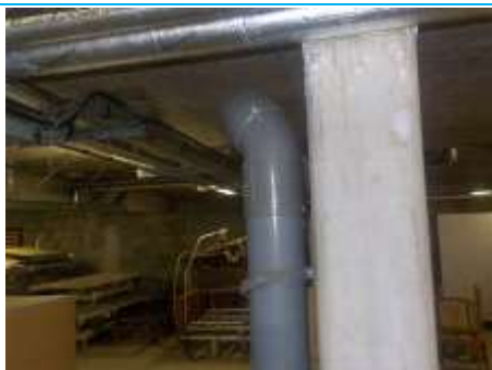
Matériaux : ZPSO-087 Prélèvement : Description : Conduites EP PVC Localisation : Sous-Sol - Garage Résultat : Absence d'amiante
