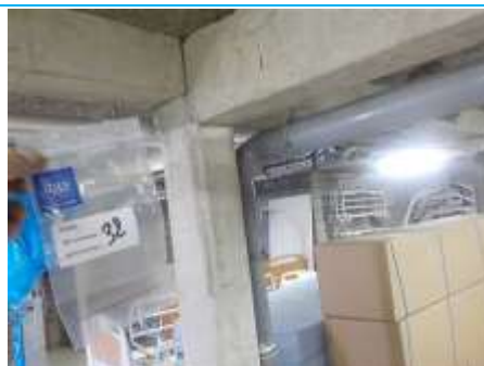
Matériaux : ZPSO-032 Prélèvement : P032 Description : Entourage de poteau fibrociment Localisation : Sous-Sol - Garage Résultat : Présence d'amiante
