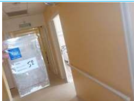
Matériaux : ZPSO-052 Prélèvement : P052 Description : Enduit murs Localisation : Rez de chaussée - Dégagement 1 Résultat : Absence d'amiante
