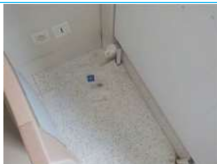
Matériaux : ZPSO-050 Prélèvement : P050 Description : Lé plastique + colle + ragréage Localisation : Rez de chaussée - Séjour Résultat : Absence d'amiante
