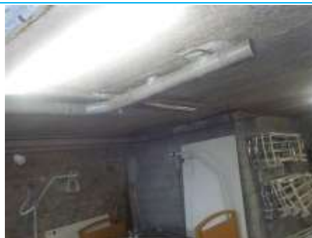
Matériaux : ZPSO-088 Prélèvement : Description : Conduites EU PVC Localisation : Sous-Sol - Garage Résultat : Absence d'amiante
