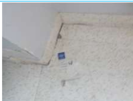
Matériaux : ZPSO-048 Prélèvement : P048 Description : Ragréage + colle Localisation : Rez de chaussée - Office Résultat : Absence d'amiante
