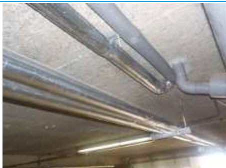
Matériaux : ZPSO-091 Prélèvement : Description : Calorifuge LV + couche alu Localisation : Vide-sanitaire - Vide sanitaire Résultat : Absence d'amiante
