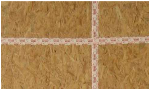
Figure 3 : Etanchéité frein vapeur- OSB (à droite) et entre les panneaux OSB (à gauche)
