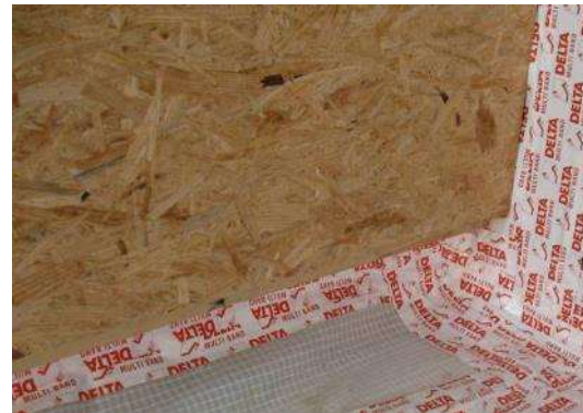
Figure 3 : Etanchéité frein vapeur- OSB (à droite) et entre les panneaux OSB (à gauche)
