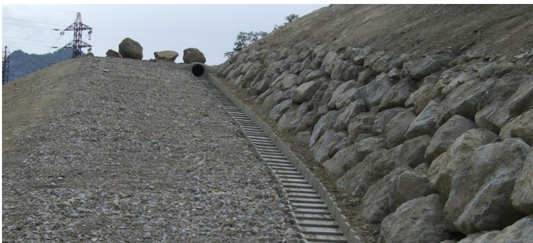
Illustration 24 : Exemple de descente béton, crédit EODD
