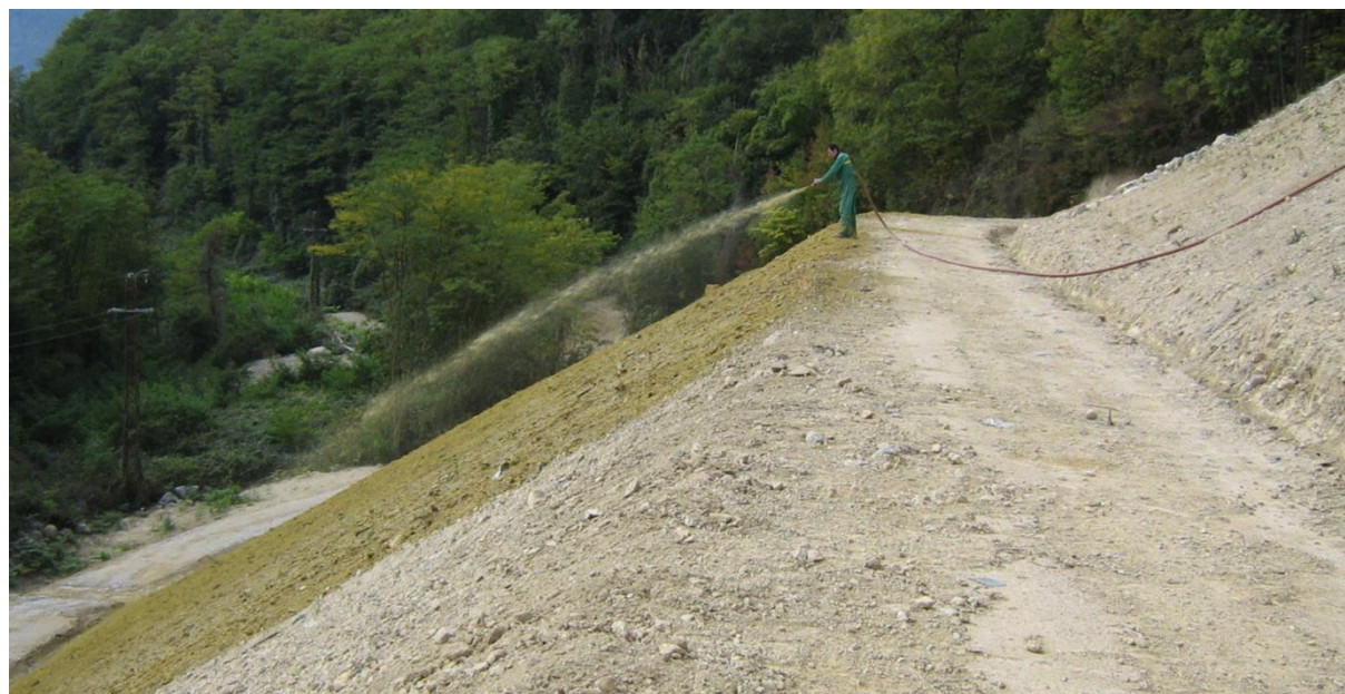
Illustration 25 : Exemple d'hydroseeding par lance de projection, crédit EODD
