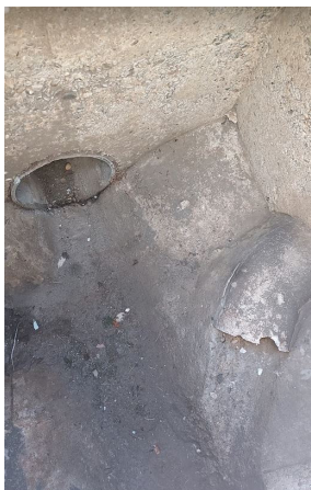
Prélèvement - P3 : RDC / Ancienne unité Trélat - Conduit- (Présence d'amiante)
