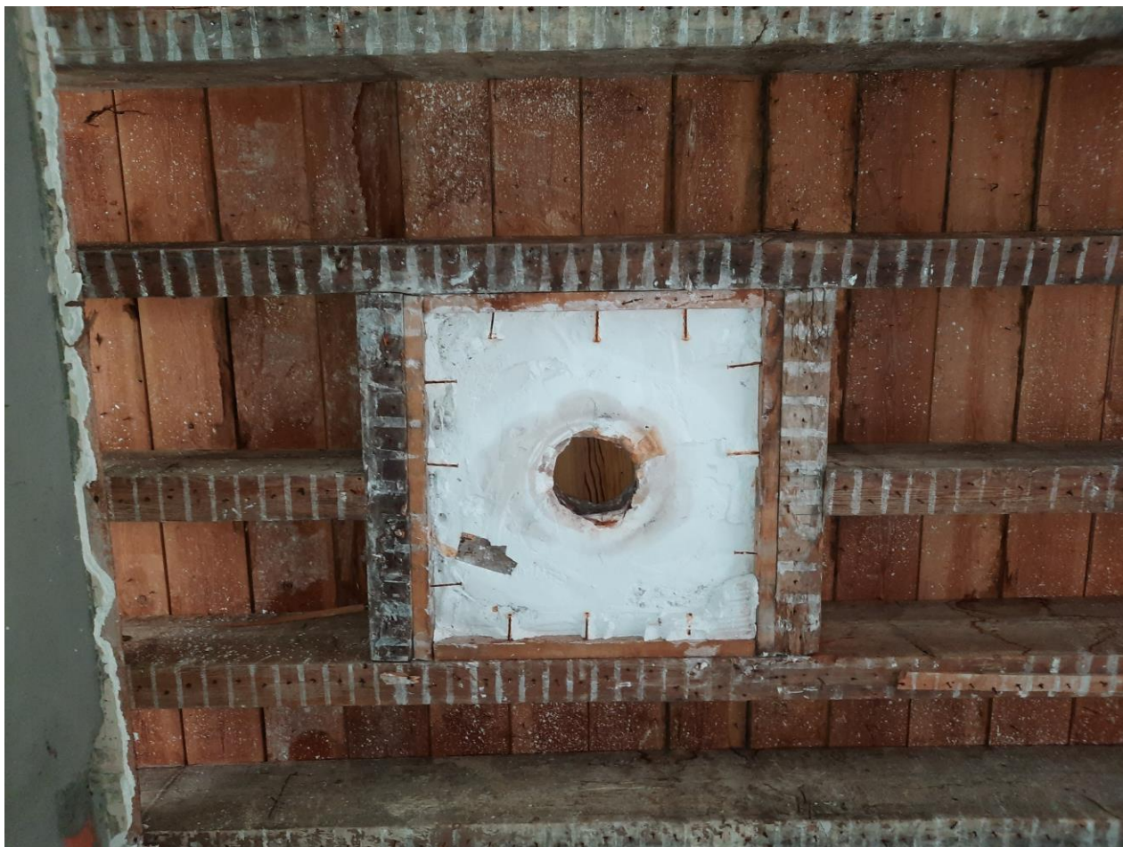
Photographie 4 : Vue depuis la sous-face de l'ancienne trémie (5)
