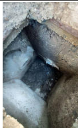
Prélèvement - P5 : RDC / Ancienne unité Trélat - Conduit- (Présence d'amiante)
