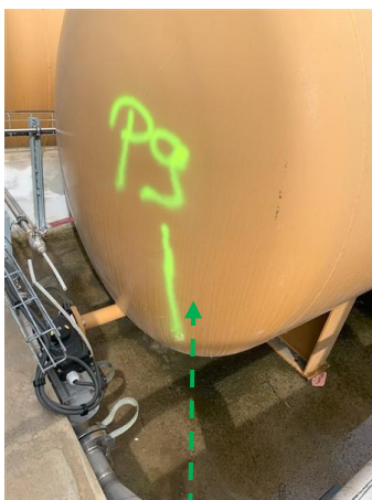
P9 : Site INNOVEOX / Abords extérieur Matériau isolant de type laine minérale Photo n° 5 - Conclusion : Absence d'amiante
