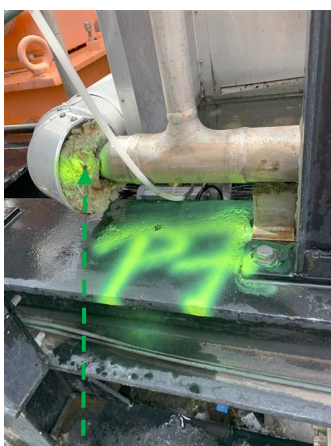
P7 : Site INNOVEOX / Abords extérieur Matériau isolant de type laine minérale Photo n° 3 - Conclusion : Absence d'amiante
