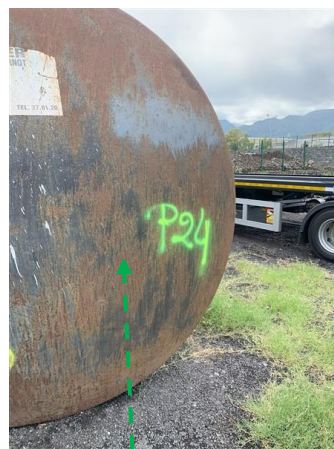
P24 : Site INNOVEOX / Abords extérieur Peinture sur cuve Photo n° 20 - Conclusion : Absence d'amiante
