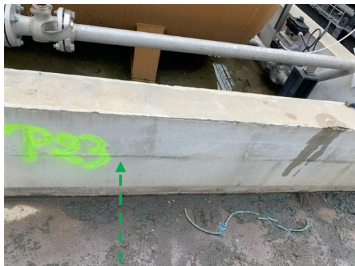
P23 : Site INNOVEOX / Abords extérieur Enduit mural Photo n° 19 - Conclusion : Absence d'amiante
