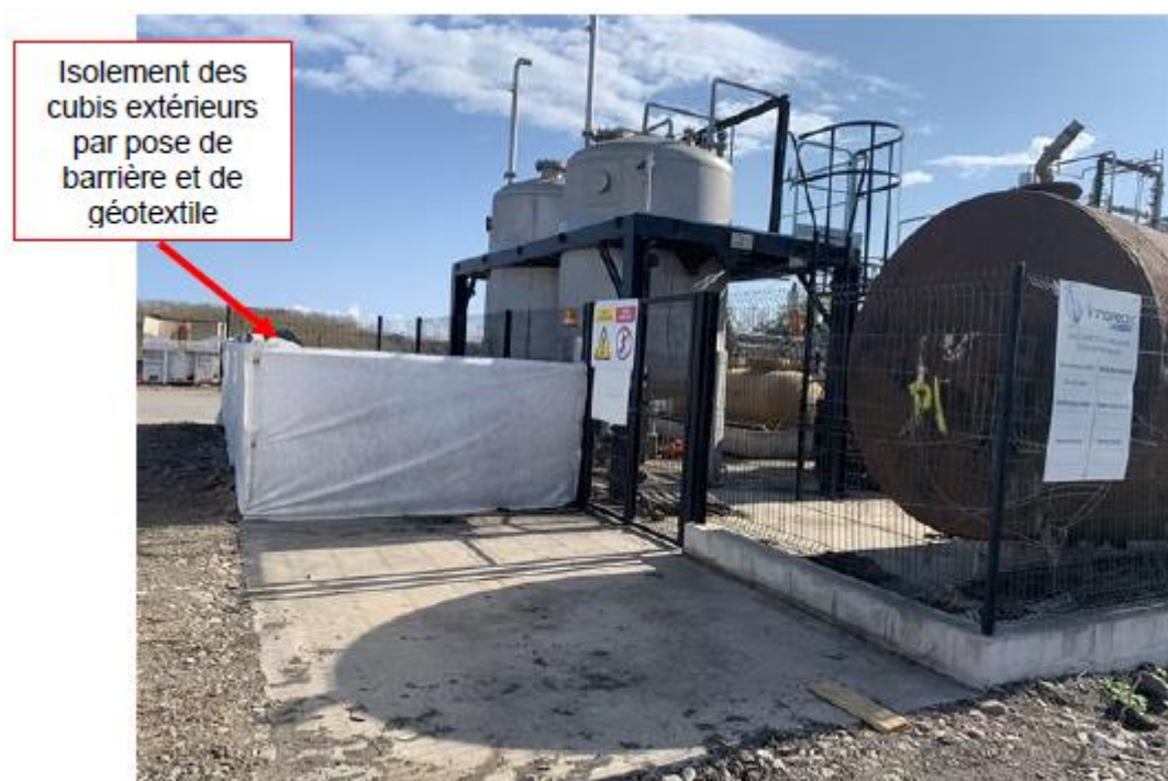
Figure 12 - Isolement des GVR stockés à l'extérieur du site par la société HCE
