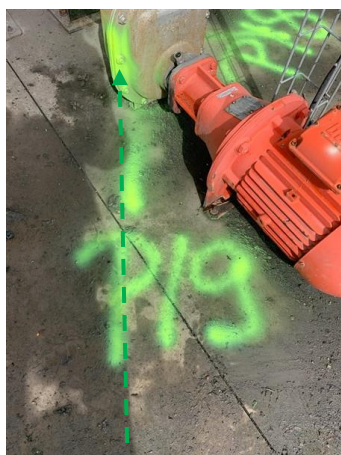
P19 : Site INNOVEOX / Abords extérieur Joint de bride sur équipement Photo n° 15 - Conclusion : Absence d'amiante
