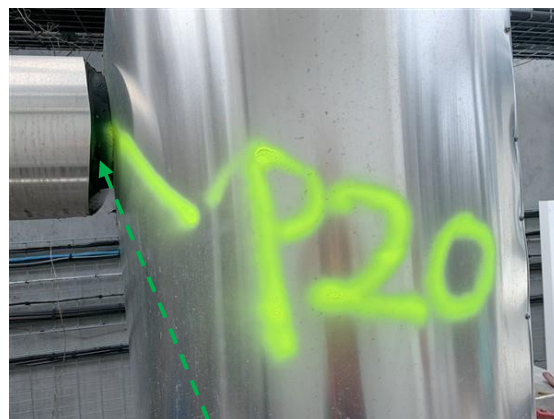
P20 : Site INNOVEOX / Abords extérieur Joint sur équipement Photo n° 16 - Conclusion : Absence d'amiante
