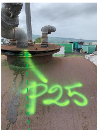
P25 : Site INNOVEOX / Abords extérieur Joint de bride sur cuve Photo n° 21 - Conclusion : Absence d'amiante
