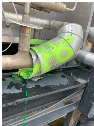
P6 : Site INNOVEOX / Abords extérieur Matériau isolant de type laine minérale Photo n° 2 - Conclusion : Absence d'amiante
