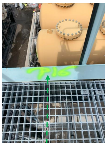
P16 : Site INNOVEOX / Abords extérieur Peinture sur garde-corps Photo n° 12 - Conclusion : Absence d'amiante
