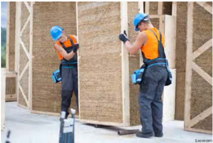
Mur préfabriqué structure bois-isolation paille.
