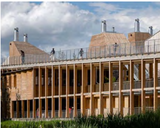
Cheminées de ventilation naturelle assistée contrôlée (VNAC) Pôle culturel - Atelier Philippe Madec, Coloco, Cornebarrieu (fr)
