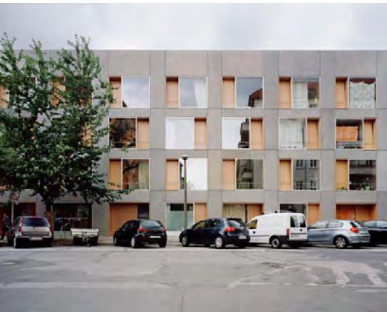
Modules qui se déclinent en façades : panneaux béton,vitrages fixes et menuiseries en bois, ZE05 - Zanderroth, Berlin (de)
