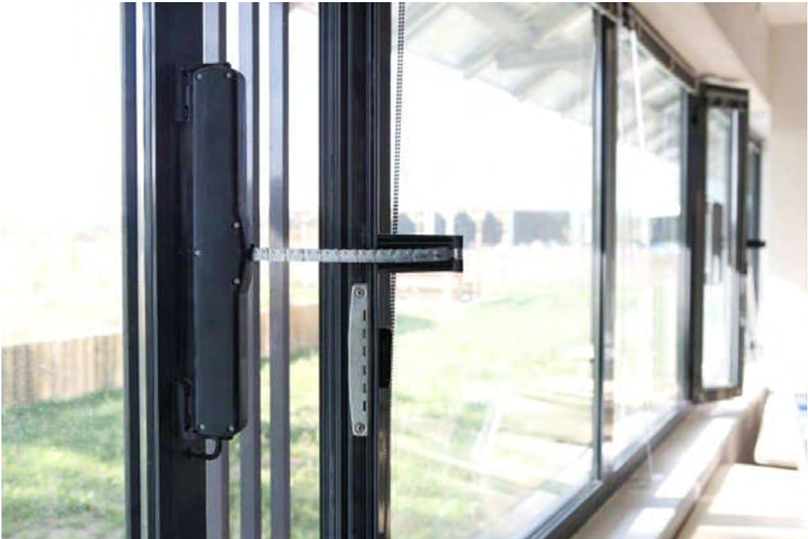
Ouvrant motorisé permettant de ventiler naturellement – Salle de réunion, bureaux Gamba (Toulouse, Haute-Garonne).
