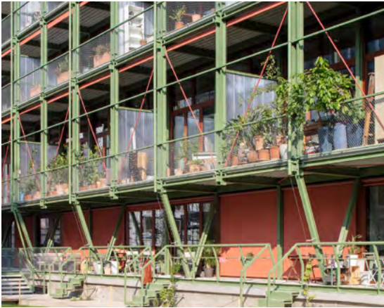
Structure en métal apparente Réhabilitation d'une cantine en logements - Esch Sintzel Architekten, Bâle (ch)
