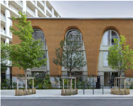
Immeuble en pisé avec débord de toiture et soubassements Bureaux, Clément Vergély, Lyon (fr) - Diener & Diener, Bâle (ch)
