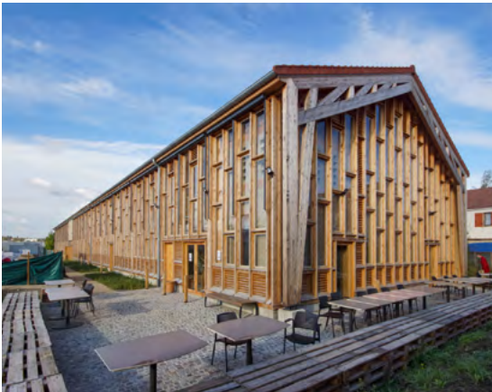
Réemploi des menuiseries et matériaux peu carbonés - La Ferme des Possibles - Archipel Zéro - Frédéric Denise (architecte), Belastock (expert réemploi), photo Revue Topophile, Stains (fr)
