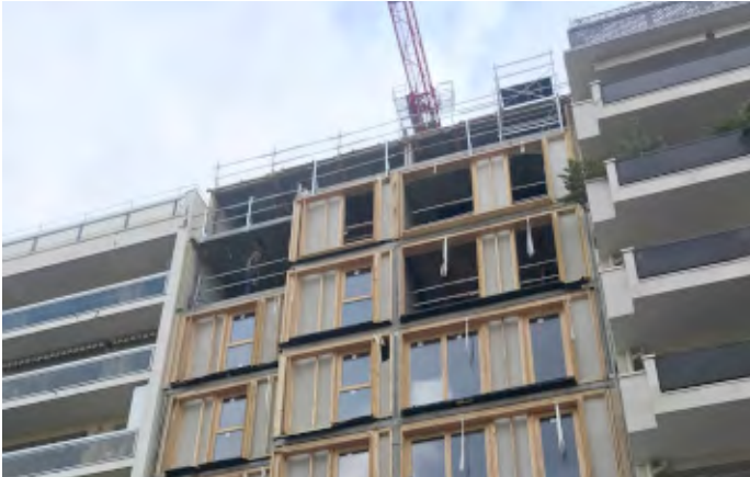
FOB et remplissage en béton de chanvre Logements - North by Northwest Architects - Boulogne-Billancourt (fr)
