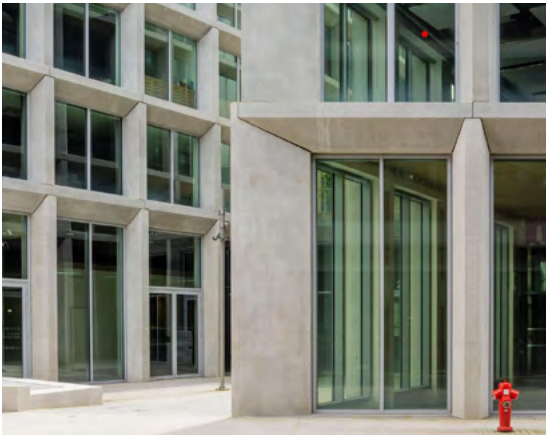
Valoriser la matière, structure apparente en béton préfabriqué Logements - Atelier Kempe Thill et Atelier 56s, Rennes (fr)
