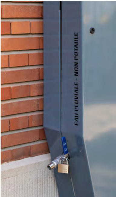
Système de récupération d'eau pluviale en façade – Faire Paris (Paris), Faltazi Design.
