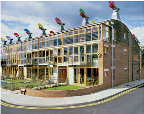
Cheminées de ventilation passive avec récupération de chaleur 82 Logements, BedZED - Bill Dunster, Londres (gb)
