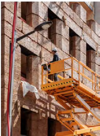
Construction en blocs de pisé préfab. Logements sociaux - Déchelette Architecture, Boulogne-Billancourt (fr)
