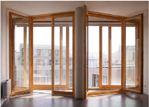
Double fenêtre avec effet mur capteur - Logements sociaux Bioclimatiques Babled-Nouvet-Reynaud, Paris (fr)
