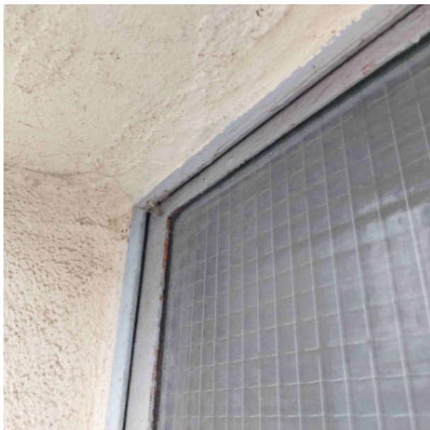
a Bâtiment A / Façade Nord / Mastic noir souple [ Prélèvement n°7]
