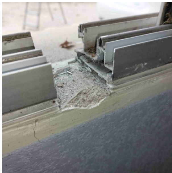
N Bâtiment B / RDC / Atelier Plongeurs / Enduit lisse sous dormant de menuiserie [ Prélèvement n°19]
