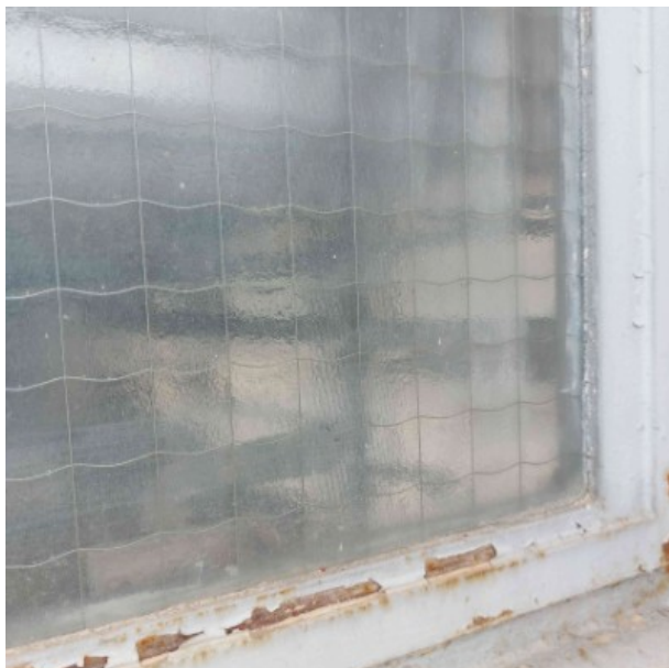
a Bâtiment A / R+1 / Garage / Mastic [ Prélèvement n°30]
