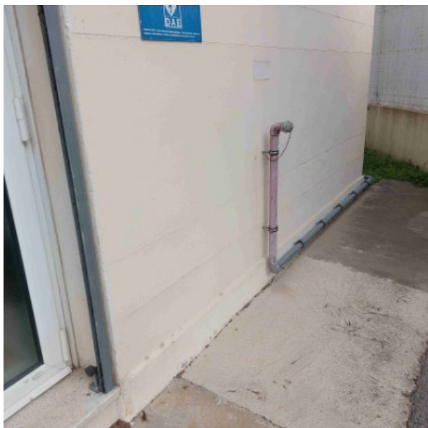
Bâtiment A / Façade Est / Zone A / Canalisation colonne sèche (M017 M018) :
