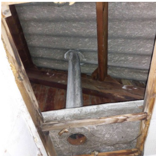
A RDC / Pièce 2 / Conduit en amiante ciment
