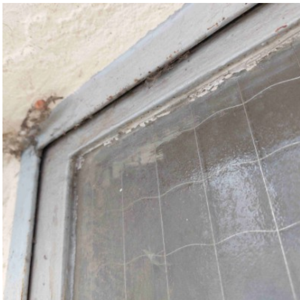
a Bâtiment A / Façade Nord / Mastic blanc dur [ Prélèvement n°8]
