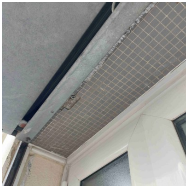
a Bâtiment A / Façade Est / Colle de faïence petits carreaux gris [ Prélèvement n°6]
