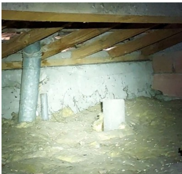
Bâtiment B / Combles / Conduit en amiante ciment
