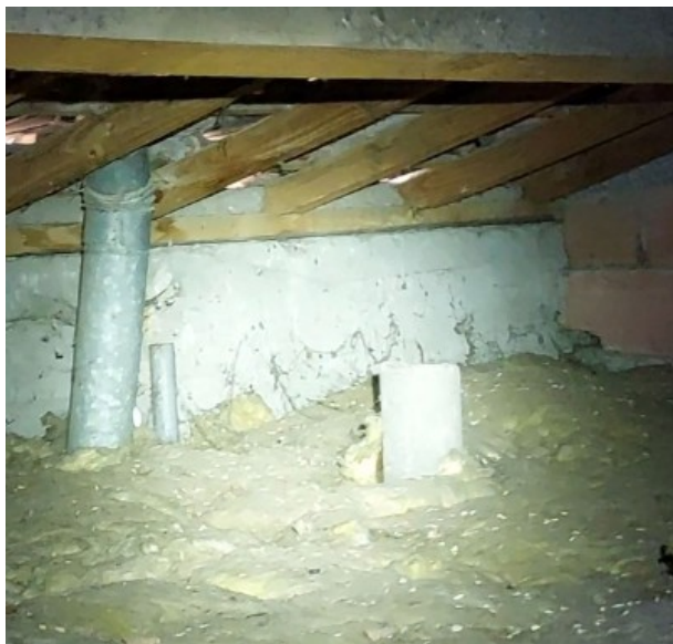
A Bâtiment B / Combles / Conduit en amiante ciment
