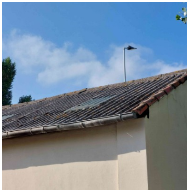
A Toiture / Plaque en fibres-ciment
