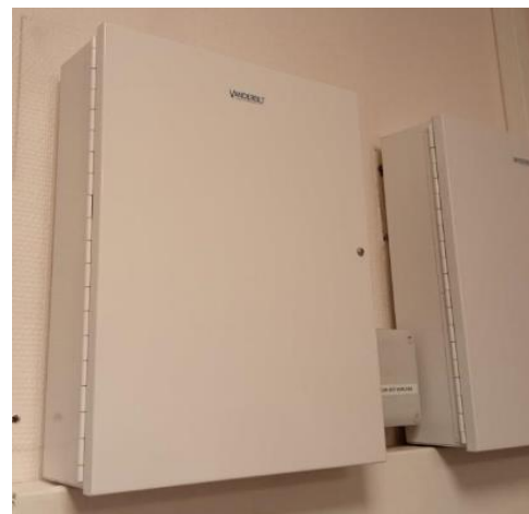
PHOTO INT 01 - Boitier de gestion anti intrusion
