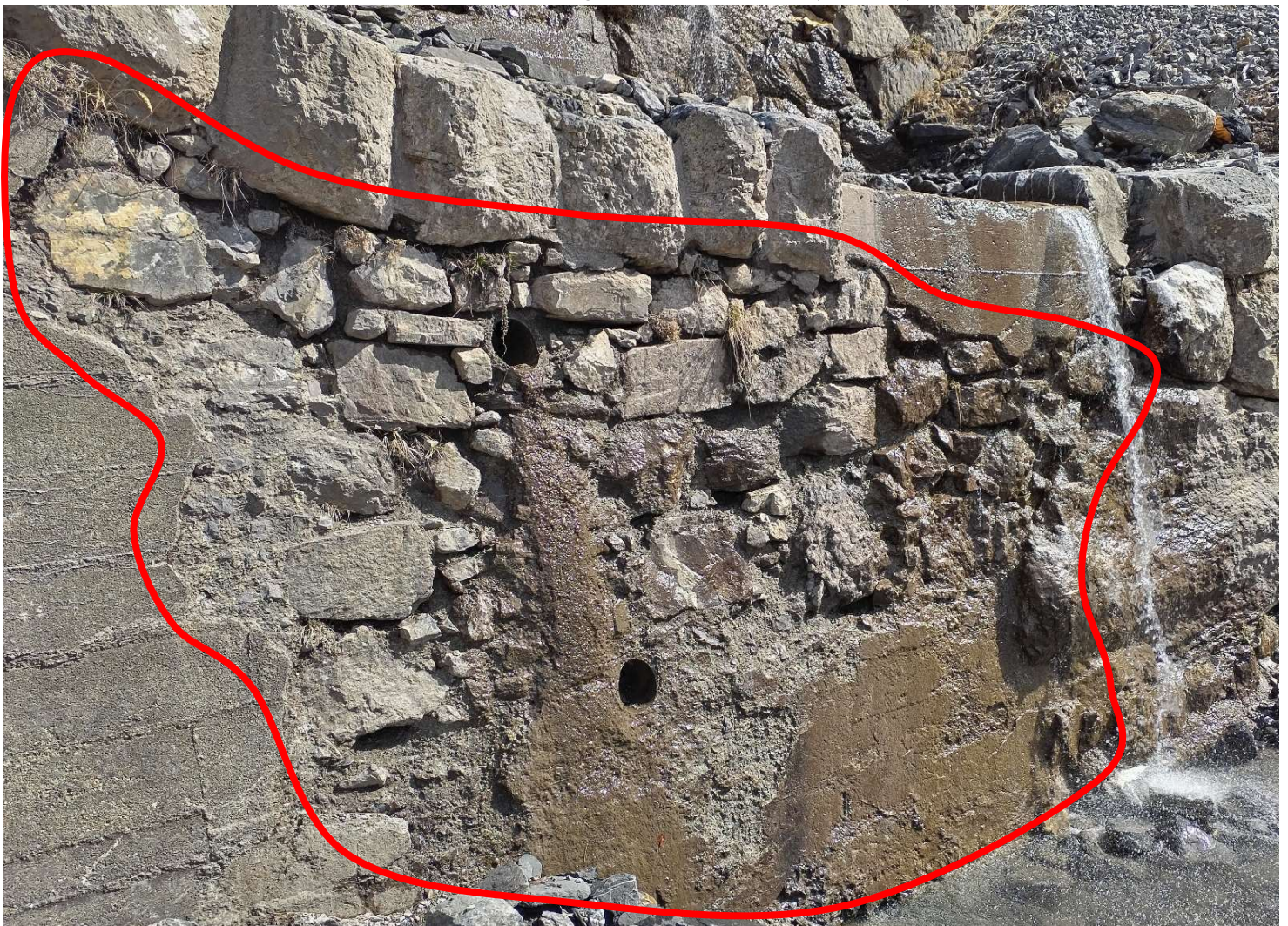
Parement fortement dégradé sous le déversoir, (photo 50)
