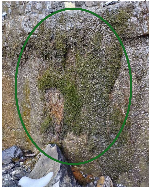
Présence de mousse sur l'aile RG, (photo 14)
