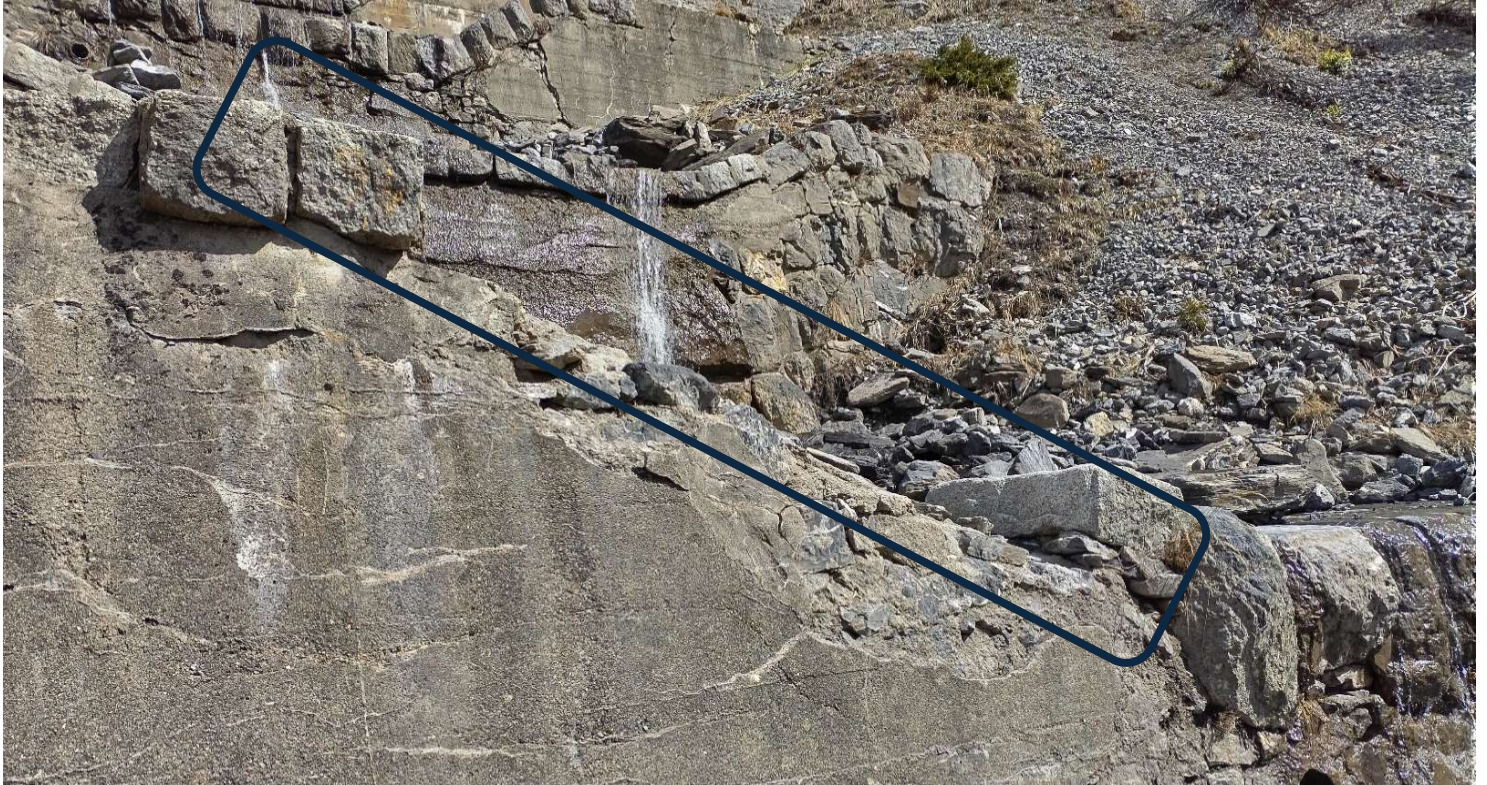
Parement sous le déversoir et l'aile RG endommagé, pins en amont de l'aile RG, (photo 56)
