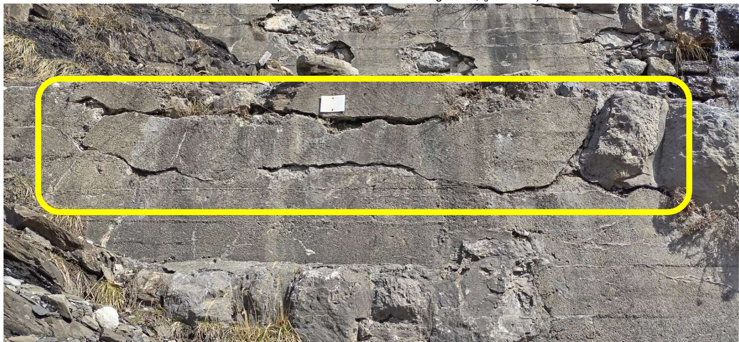
Fissures du parement béton sur l'aile rive gauche, (photo 52)
