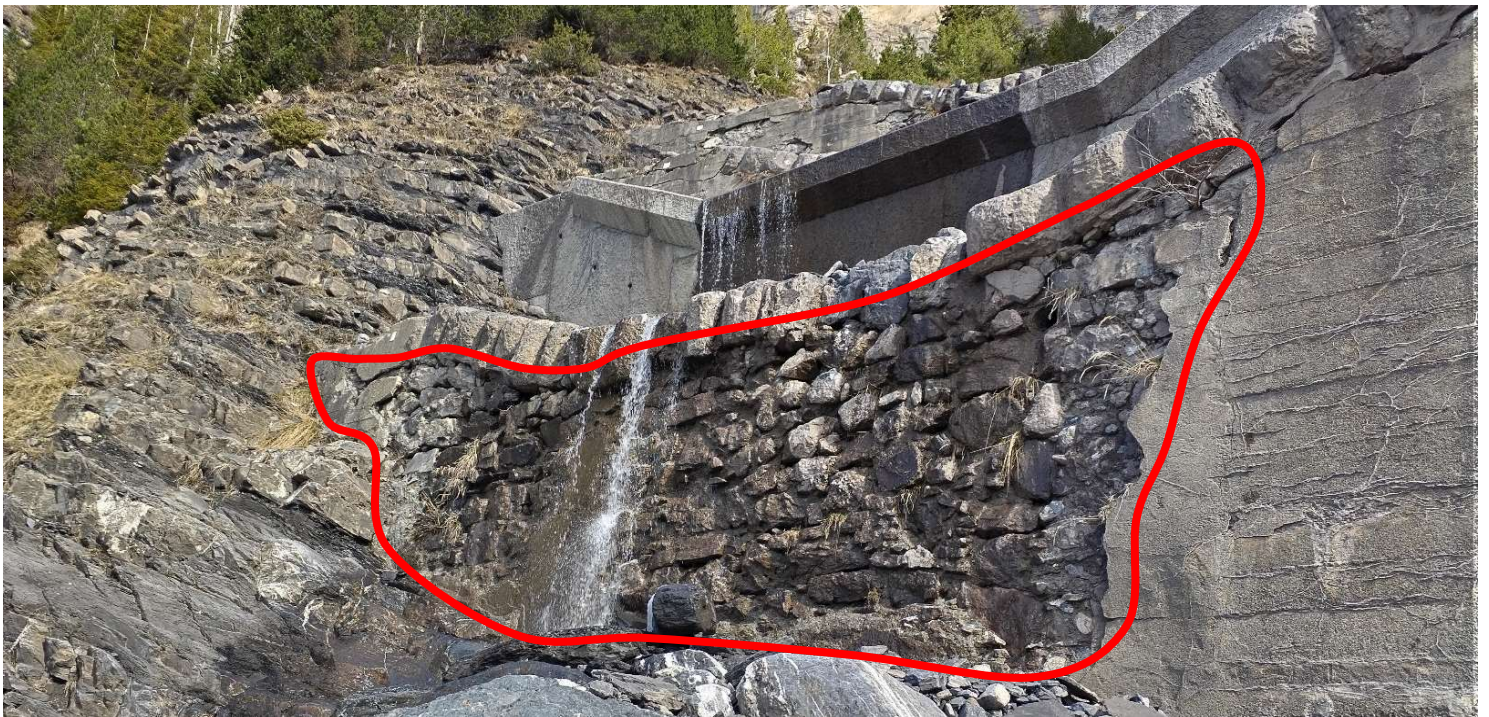
Parement à reprendre (40 m²) sous aile RD, (photo 45)
