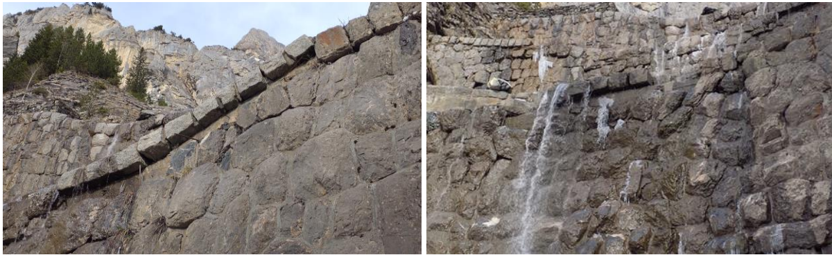
Figure 12 : Absence des pierres maçonnées des barrages 6 (à gauche) et 8 (à droite), prise de vue de 2024.
