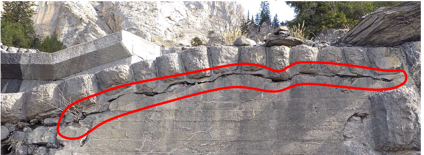
Fissure sous le couronnement RG environ 10 ml, (photo 46)
