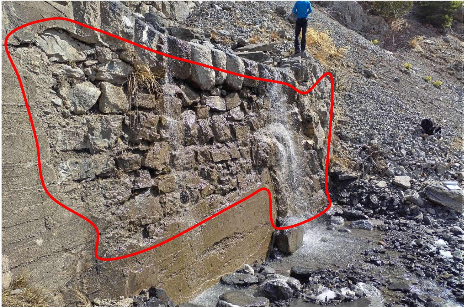
Parement à reprendre sous le déversoir et aile RG, (photo 53)
