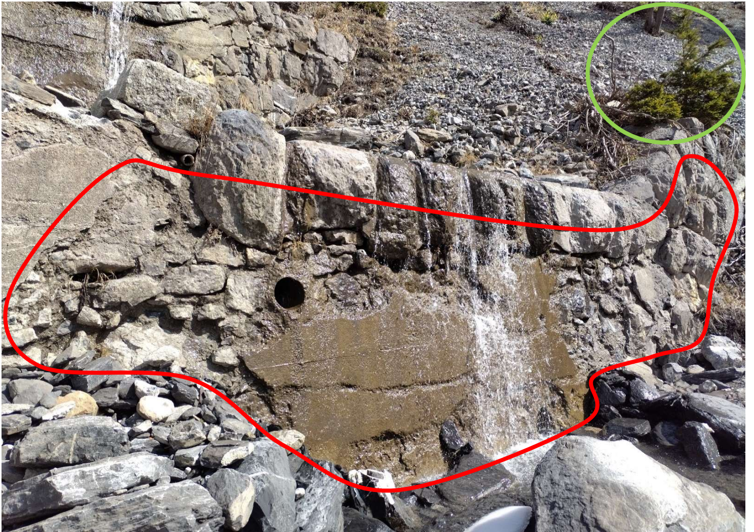
Parement sous le déversoir et l'aile RG endommagé, pins en amont de l'aile RG, (photo 56)
