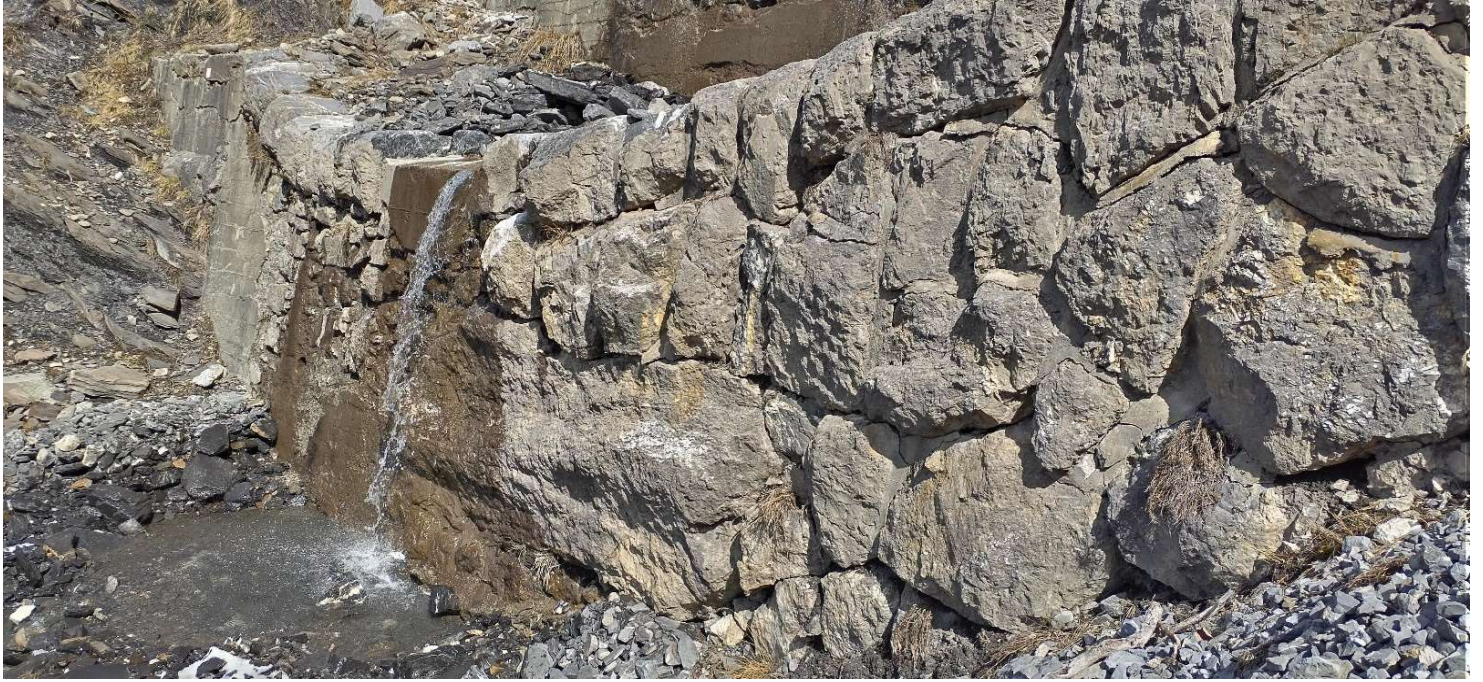
Altération des joints RG, (photo 49)
