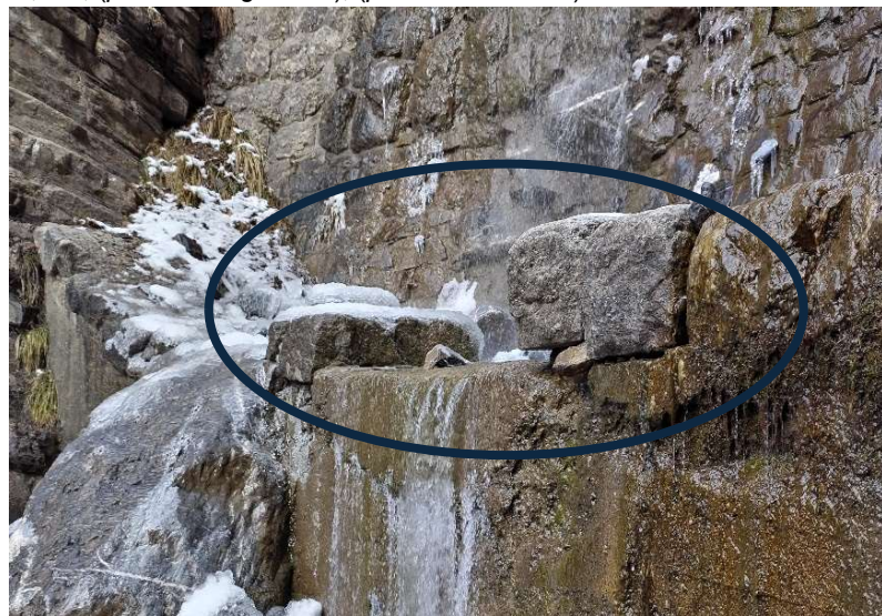
Déversoir détruit sur 1,8 m, (photo 10 à gauche), (photo 11 à droite)
