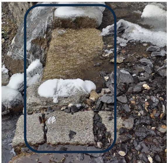
Déversoir détruit sur 1,8 m, (photo 10 à gauche), (photo 11 à droite)
