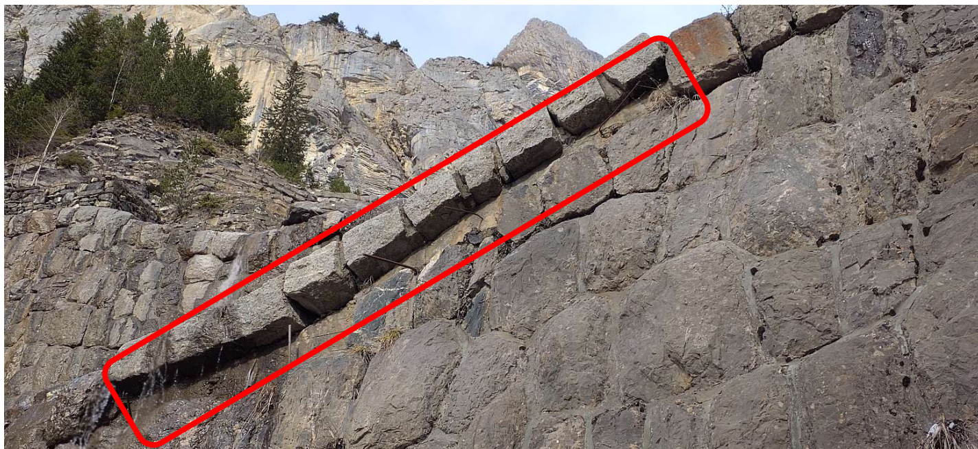
Les pierres sous le couronnement rive droite sont arrachées, (photo 35)
