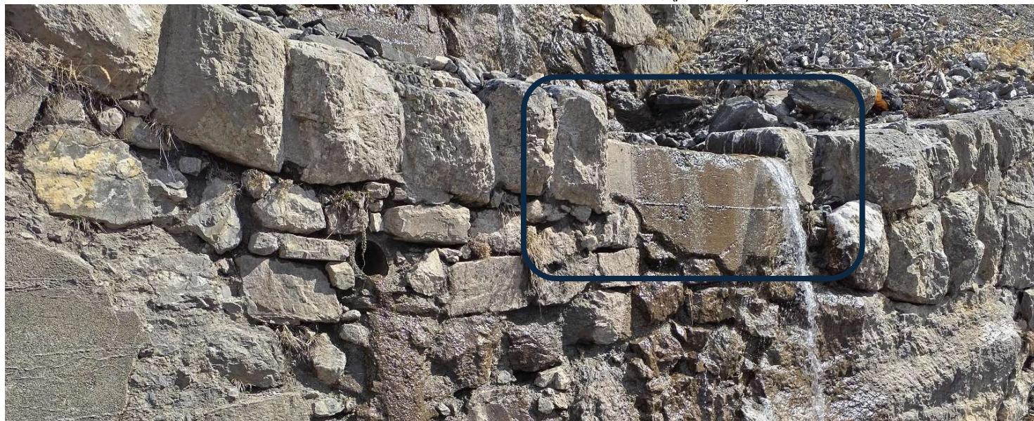
Cuvette détruite sur 2 ml au niveau du déversoir, (photo 51)
