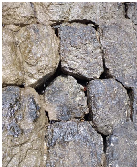
Figure 11 : Photo de l'état des joints fortement dégradés sur le barrage N°8.
