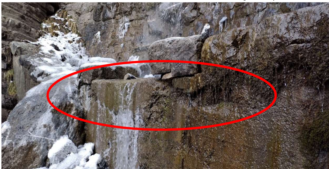
Parement béton altéré sous le couronnement du déversoir, (photo 12)
