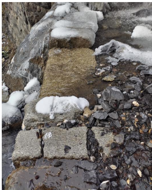
Figure 16 : Couronnement granit du barrage 3 partiellement détruit, prise de vue de 2024.
