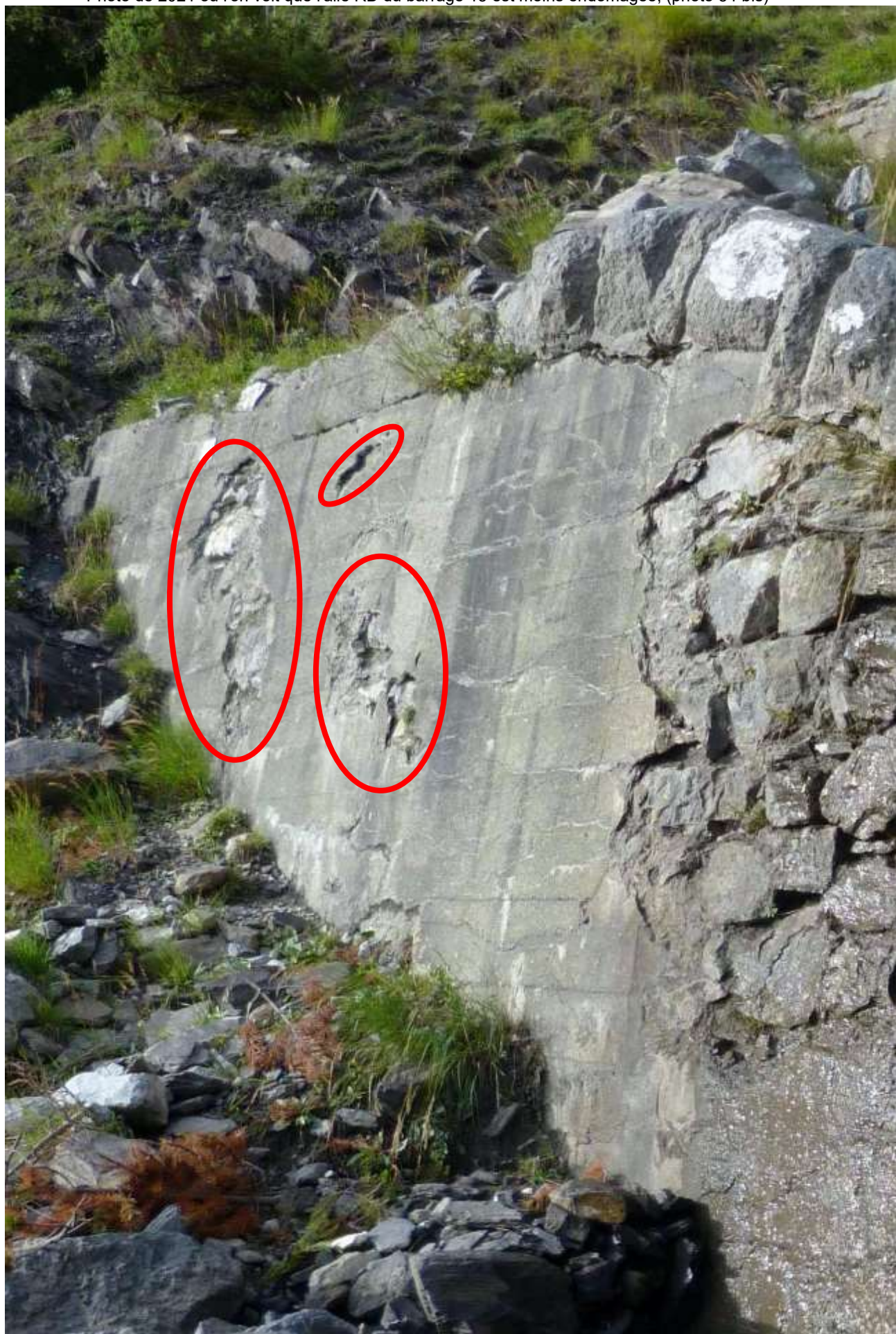
Photo de 2021 où l'on voit que l'aile RD du barrage 15 est moins endommagée, (photo 54 bis)
