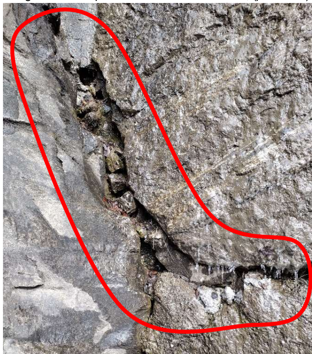
Dégradation du parement béton sur l'aile RD, (photo 13)
