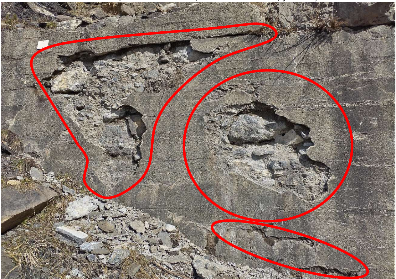
Parement à reprendre sous l'aile RD profondeur max = 15 cm, (photo 54)
