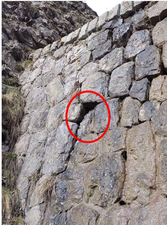
Profondeur des joints manquant environ 20 cm et pierres manquantes, (photo 33 à gauche et 34 à droite)
