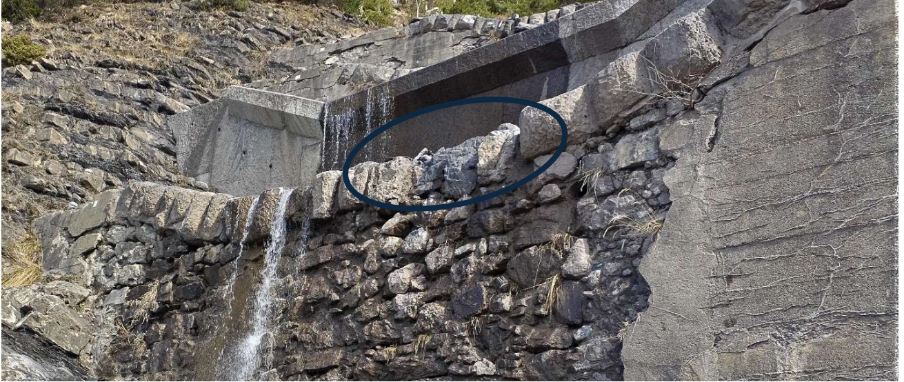
Parement à reprendre (40 m²) sous aile RD, (photo 45)
