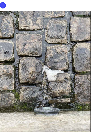
Descente EP - Évacuation de l'eau vers la cour par un jet d'eau en plomb
