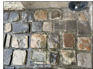
Regard avec remplissage de pavés quasiment invisible
