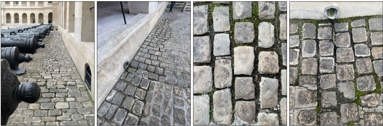
Déjointoiement sur le pourtour de la cour Déjointoiement sur le pourtour de la cour Déjointoiement généralisé Déjointoiement des fils d'eau
