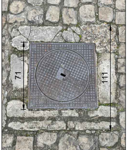
Tampon 2 - Encadrement en pierre cassé et tampon en fonte
