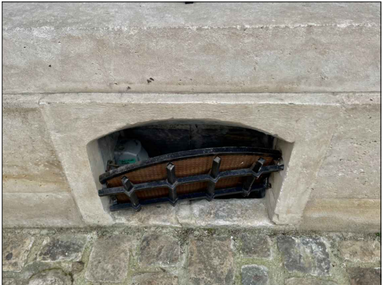
Grille ouvrante - Instable, fixation disparues
