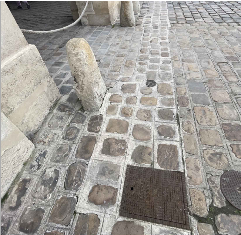
Variation des types et natures de joints
