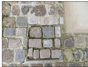
Regard avec remplissage de pavés cassés et déjointoyés
