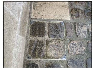
Regard avec remplissage de pavés
