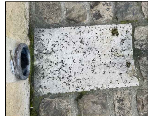
Pierre 3 - Pierre posée de biais, dans l'alignement du fil d'eau
