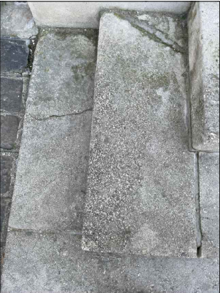
Perron O - Dégradé Joint ciment disgracieux Casse
