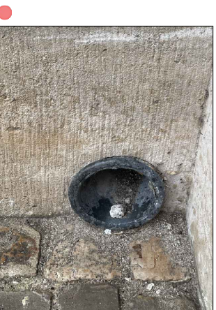
Descente galerie - Aucune circulation d'eau pendant une pluie modérée
