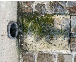
Pierre 1 - Pierre posée de biais selon le tracé du fil d'eau Colonisation biologique
