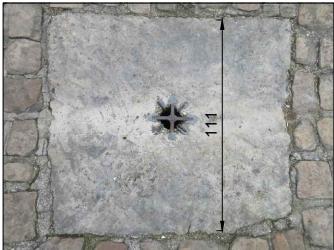
Avaloir 1 : Croix en fonte avec soudure au plomb, pierre de sol Dispositions d'origine à vérifier
