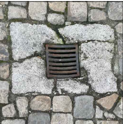
Avaloir 3 : Grille en fonte courbe à section carrée, encadrement en pierre cassé
