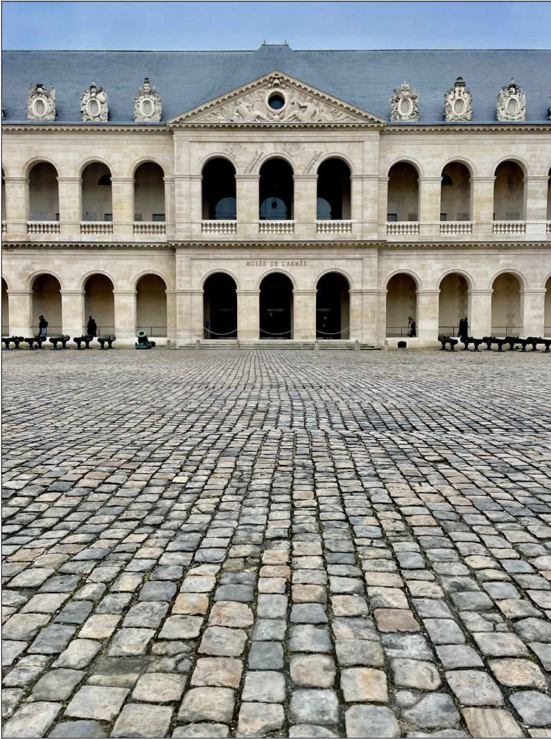
Déformation du pavage et des alignements
