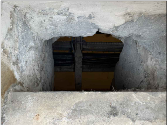
Grille ouvrante - Ouverture dangereuse, risque de chute d'environ 3m de hauteur
