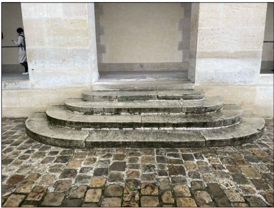
Perron NO - Dégradé Encrassement Ragréages disgracieux en partie basse des contre-marches Épaufrures des arêtes
