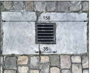
Avaloir 4 : Grille en fonte courbe à section carrée, encadrement en pierre allongé cassé
