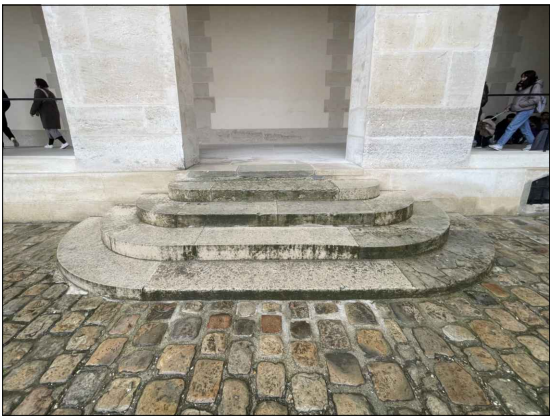
Perron NE - Dégradé Encrassement Colonisation biologique Épaufrures des arêtes et casse Jointoiment disgracieux
