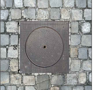
Tampon 4 - Tampon en fonte, aucun encadrement
