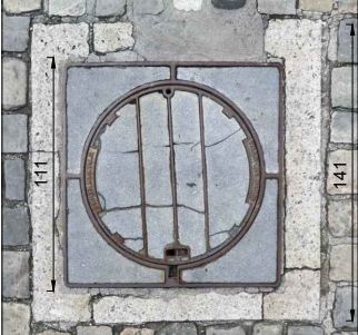
Tampon 3 - Encadrement en pierre comblé au ciment et tampon en fonte avec remplissage
