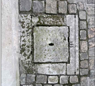
Tampon 1 - Tampon en pierre Dispositions d'origine à vérifier
