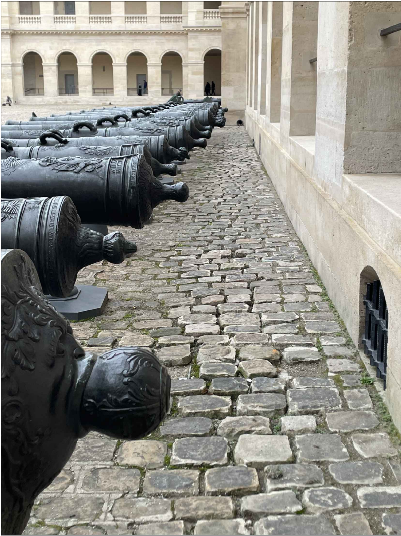
Déjointoiement des pavés
