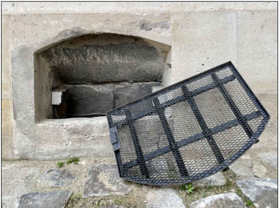
Grille ouvrante - Instable, fixation disparues
