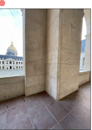
Galerie supérieure - Joints ouvert au dessus du caniveau
