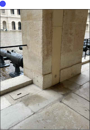
Descente EP - Traces d'humidité sur le dallage en pierre de la galerie, au dessus de la circulation des eaux de toiture
