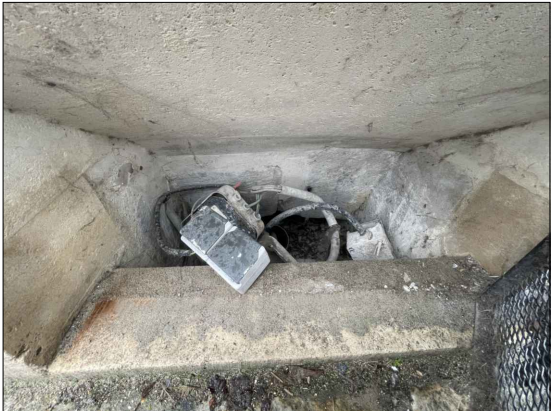
Grille ouvrante - Présence de réseaux électriques Deux prises standard et une prise de puissance sopirail bouché
