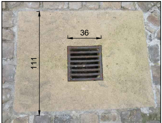
Avaloir 2 : Grille en fonte courbe à section carrée, pierre de sol neuve
