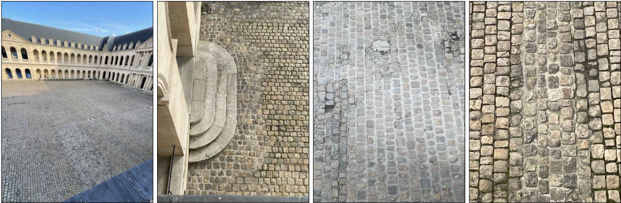
Jointoiement disparate de la cour Présence de joints ciment sur le pourtour de la cour Joints ciment Joints ciment
