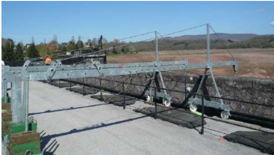
Figure 27 : Installation d'une nacelle suspendue sur la crête du barrage de Champagney pour travailler sur le parement aval lors des travaux de 2017
