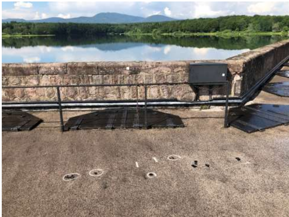
Figure 26 : Vue des trappes de protection du sommet des puits.
