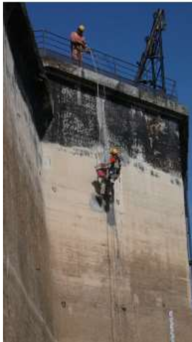
Figure 28 : Interventions sur le parement amont du barrage de Champagney depuis la crête par cordiste L'accès à la crête du barrage peut se faire depuis la rive gauche de l'ouvrage en empruntant un escalier.
