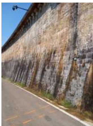
Figure 9 : Suintements sur le parement aval de l'arc 4 - VTA 2023
