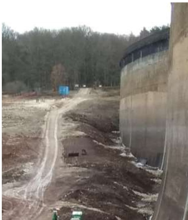
Figure 22 : Arc 4 du barrage et piste d'accès par le merlon en rive gauche lors des travaux de 2017
