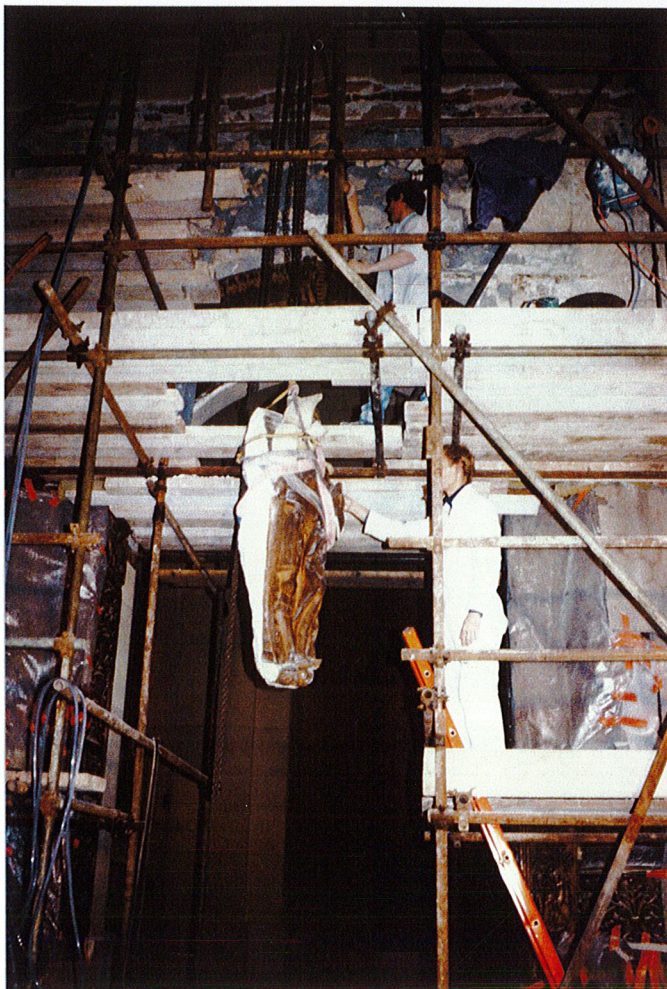
Dépose de l'atlante sénestre ( Persée), puis de l'écoinçon voisin.
