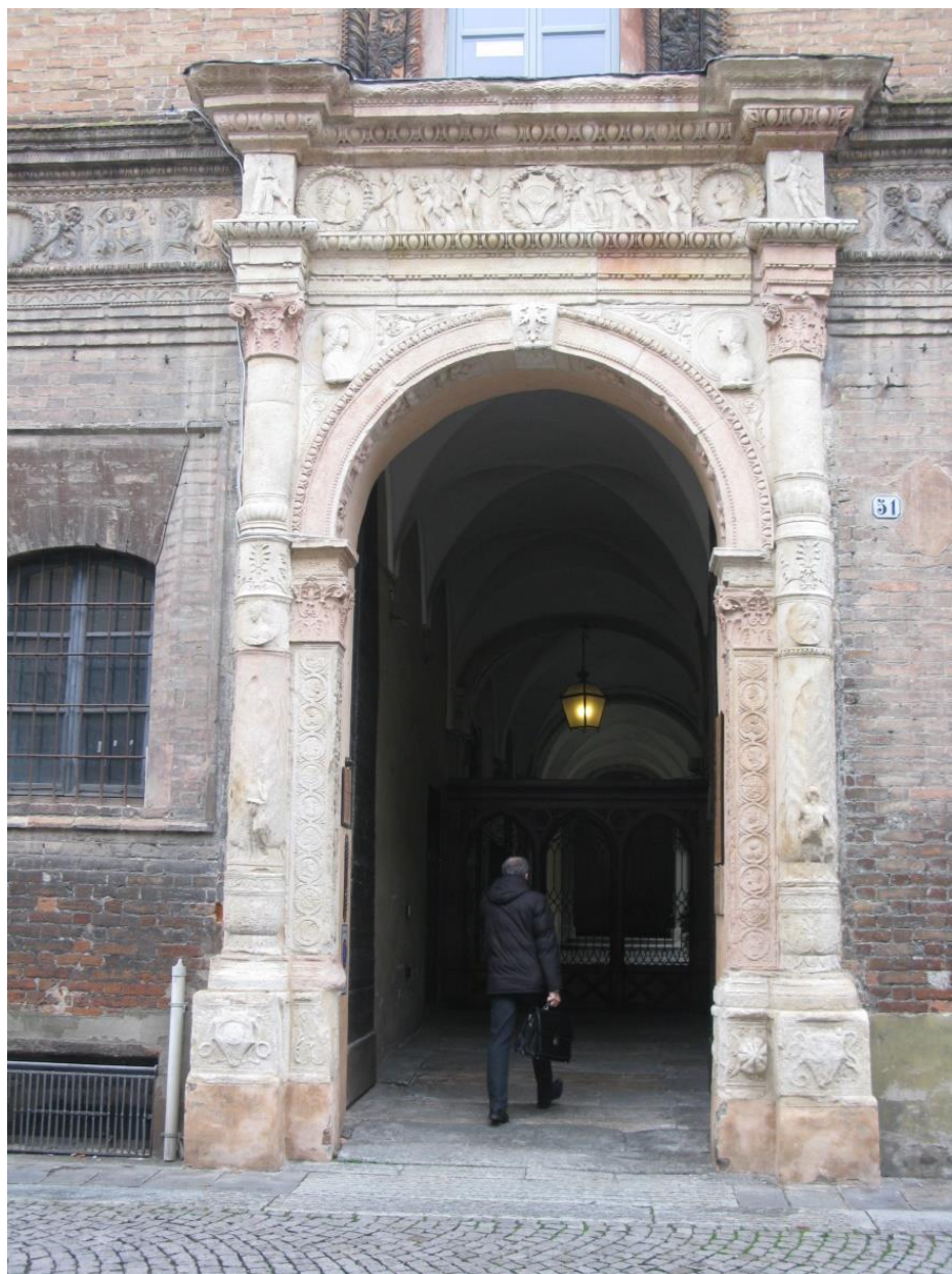
Fig. 8 Élément comparatif : porche de palais en marbre après nettoyage. Cette œuvre proche au niveau stylistique de la porte du palais Stanga conserve ici, les élévations originales l'encadrant. On constate la poursuite de l'attique et des moulurations hautes qui se continuent au moins sur la façade du bâtiment. Seul le porche est en marbre, la suite des reliefs et des élévations est en terre cuite. Toutefois un bandeau en pierre dure prend la place des premières assises (correspondant à la hauteur du dèl inférieur du porche), limitant les remontées capillaires et le rejaillissement dans le mur. Le musée de Crémone conserve en réserve des centaines de bandeaux en terre cuite qui bien souvent ont été déposés lors de réfections de façades comme probablement au palais Stanga lors de la modernisation en style baroque de la façade.
