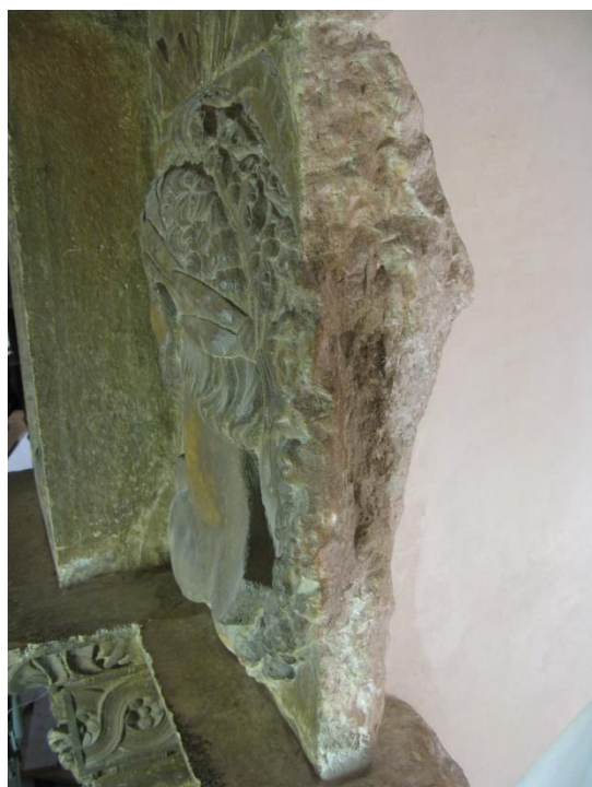
Figure 50 ( \alpha 11) Présence de patine sur le plan de joint vertical
