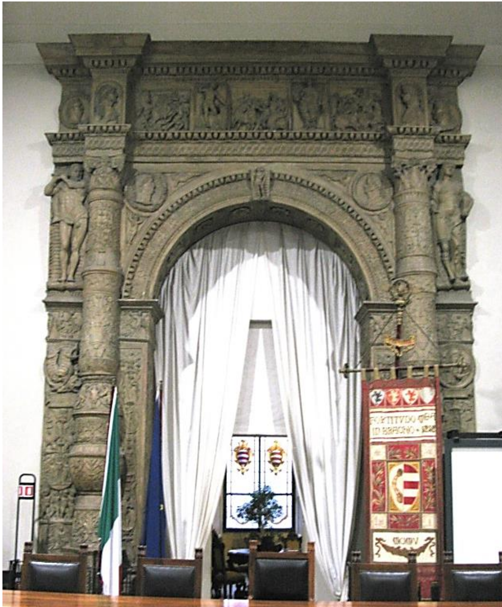
Fig.3 Tirage en plâtre et ciment hydraulique (d'après les archives) conservé dans la salle du conseil de Crémone. L'accès aux seules parties basses nous a limité dans la comparaison des parties modifiées sur l'original : corniche complétée, traces dues au moulage (coutures), parties fracturées. Le tirage a été patiné en ocre sans tenir compte du jeu de polychromie des matériaux originaux.
