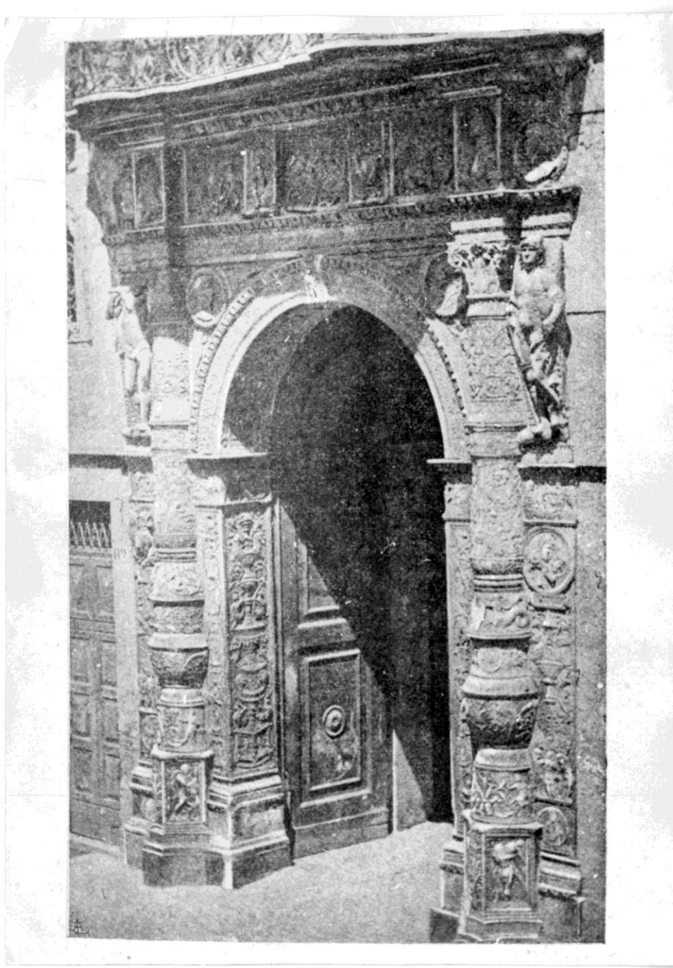
Fig. 15 Cette photo conservée au département des sculptures du Louvre montre l'affleurement des enduits sur le porche monumental coté senestre. L'enduit est légèrement en retrait du parement (1 à 2 cm). Si l'œuvre reçoit une couche de peinture ou badigeon en place, cette couche ne recouvrira le chant à l'extrême senestre que d'un centimètre ou deux.
