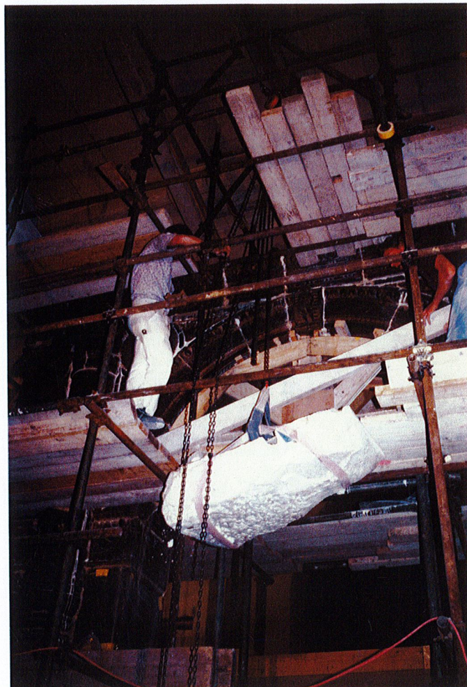
Le hissage au palan du plus gros bloc de la frise ( \alpha 7, environ 850 kilos)
