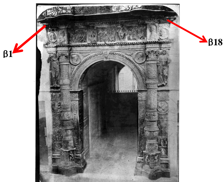
Fig. 21 Lors de la dépose, après étaieement du balcon et mise sur cintre de l'arc, les corniches hautes dextre et senestre sont retirées en tiroir. Le peu d'espace sous la dalle du balcon et la moindre résistance des marbres à cet endroit (les plus soumis à l'eau) peuvent être à l'origine des fractures et des manques que nous retrouvons à dextre et senestre dans la corniche. Une fois les deux reliefs de l'attique à dextre et senestre retirés, il devenait plus facile d'atteindre les reliefs moins épais de l'attique.
