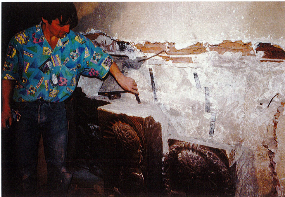
La dépose de la frise, agrafée au laiton
