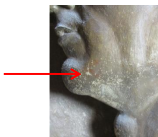
Fig. 21 Lors de la dépose, après étaieement du balcon et mise sur cintre de l'arc, les corniches hautes dextre et senestre sont retirées en tiroir. Le peu d'espace sous la dalle du balcon et la moindre résistance des marbres à cet endroit (les plus soumis à l'eau) peuvent être à l'origine des fractures et des manques que nous retrouvons à dextre et senestre dans la corniche. Une fois les deux reliefs de l'attique à dextre et senestre retirés, il devenait plus facile d'atteindre les reliefs moins épais de l'attique.
