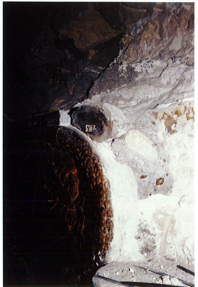
Dépose de l'atlante sénestre ( Persée), puis de l'écoinçon voisin.
