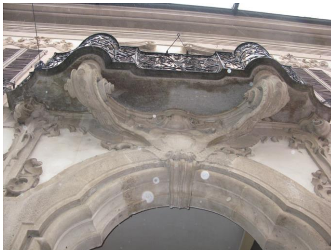
Fig. 5 Porche actuel remplaçant la porte après sa dépose. Par temps de pluie, l'eau retourne partiellement sous la dalle du balcon et descend le long du mur pour percoler à travers les joints hauts de l'arc polylobé, une situation qui devait être assez semblable lors que le porche ancien était encore en place sous cet élément. Nous en retrouvons les traces sur les joints des claveaux
