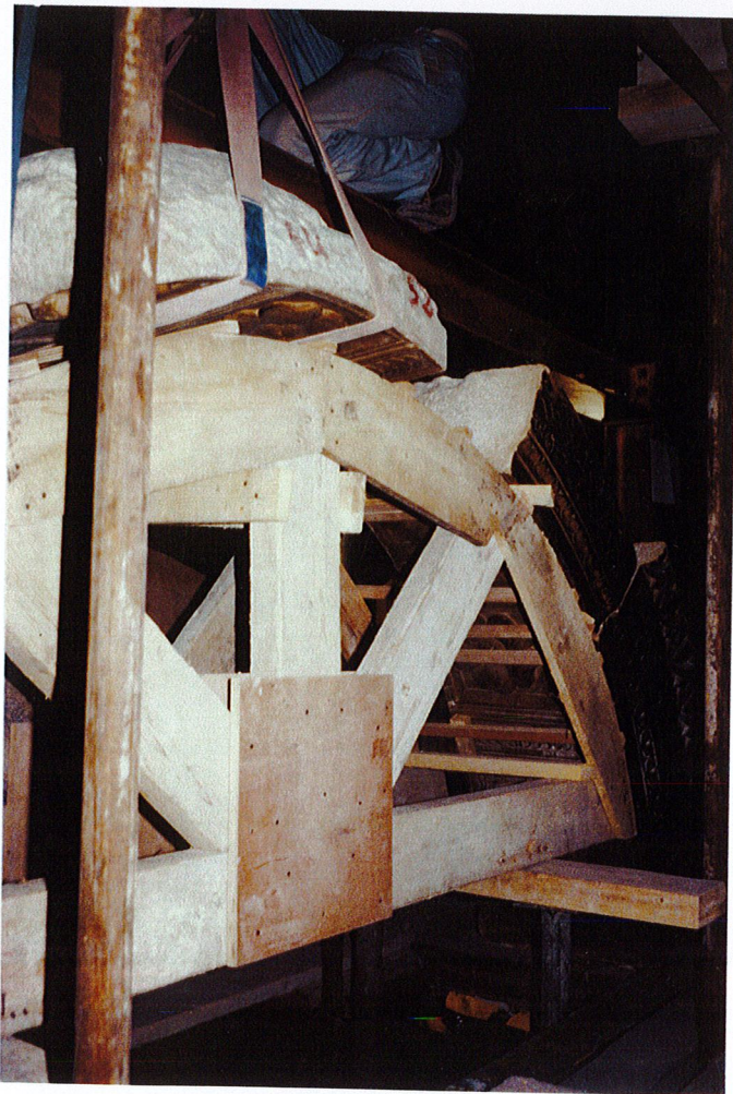
Pose des voussoirs, de l'archivolte et de la clé
