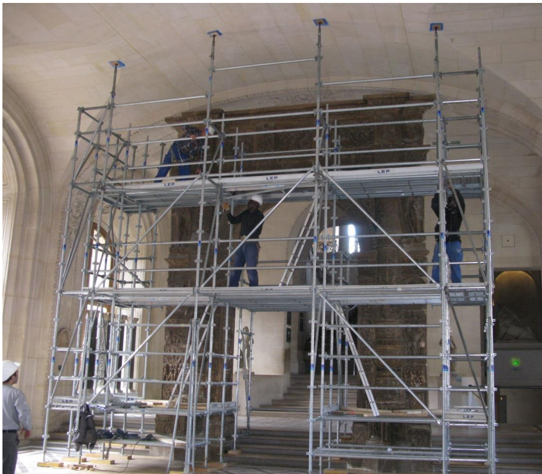
Fig. 12 Echafaudage en cours de montage.
