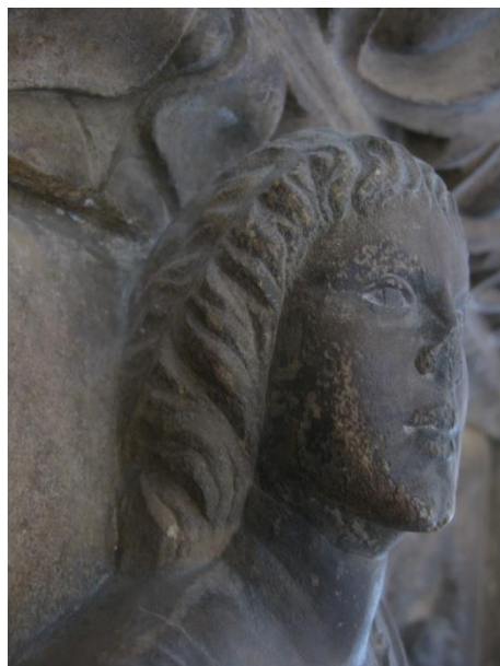
Fig. 37 et 38 (assise de l'attique \alpha 8) Les micro-soulèvements rongent petit à petit le contour du visage .
