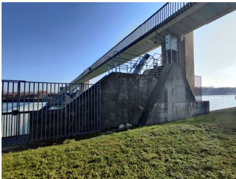
Photo 10 : Pile du barrage accolée au bajoyer
