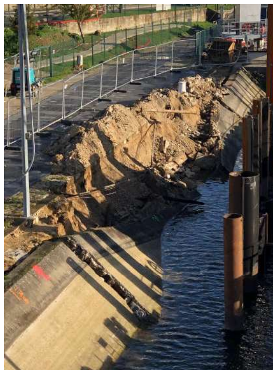
Photo 15 : Perré partiellement effondré lors des travaux de 2021-2022
