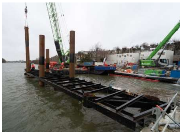
Photo 5 : Estacade en cours de réalisation (travaux 2021-2022)
