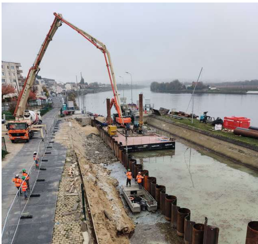
Photo 6 : Mise en place d'un rideau mixte en rive gauche (travaux 2021-2022)
