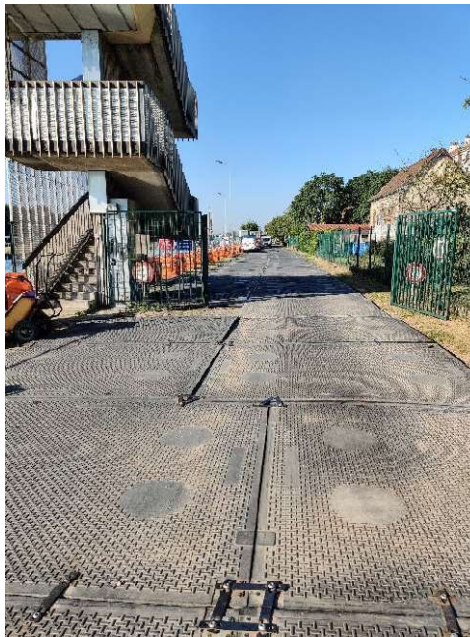
Photo 14 : illustration de la protection des accès terrestres (Photo Chantier 2021-2022)
