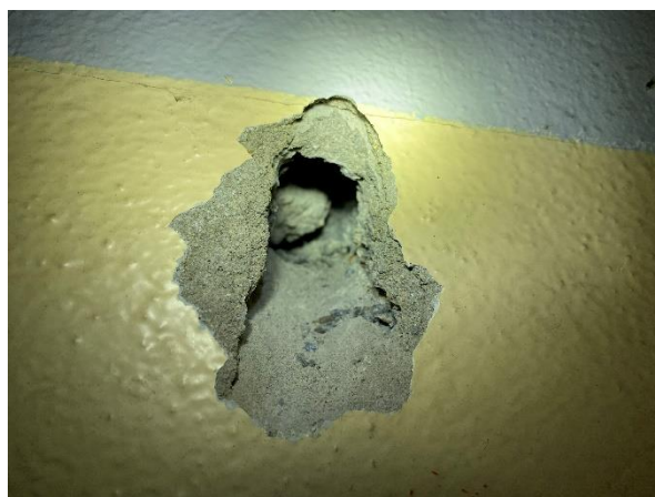
Photographie du sondage sur les murs latéraux de l'escalier (orange)
