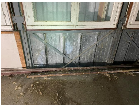
Photographie du poteau IPE140 et de la structure en façade
