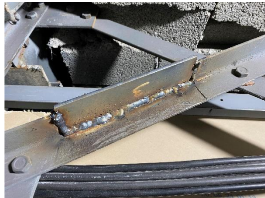
Photographie du prélèvement et du rebouchage d'acier sur la poutre treillis longitudinale
