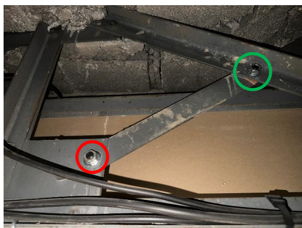
Photographies de la zone de prélèvement après remplacement de la boulonnerie
