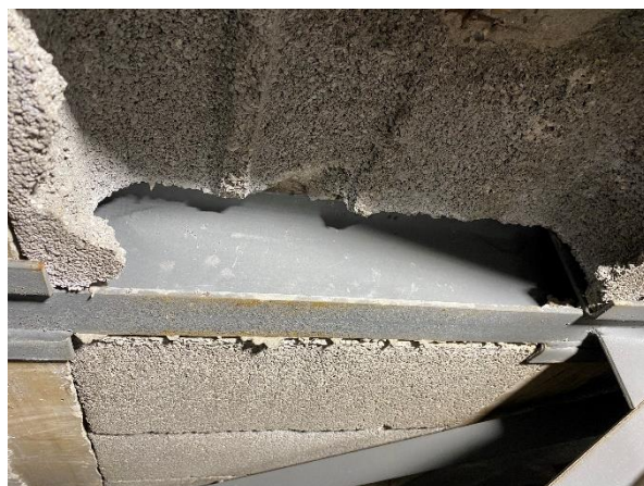
Photographie des IPE 220 noyés dans le plancher hourdis
