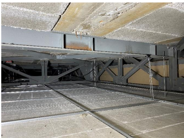
Photographie des IPE 220 noyés dans le plancher hourdis
