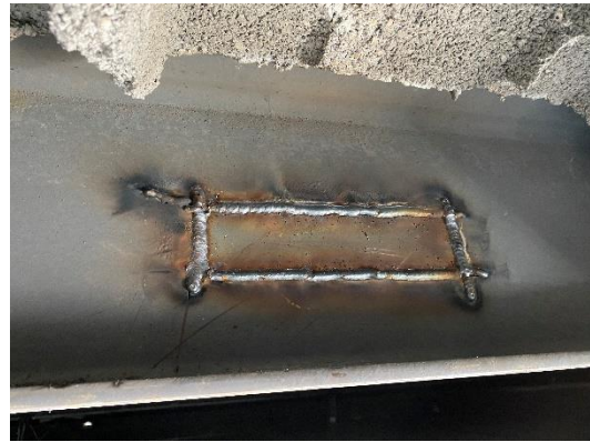
Photographie du prélèvement et du rebouchage d'acier sur la poutre secondaire
