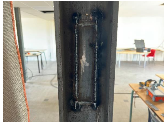
Photographie du prélèvement et du rebouchage d'acier sur le poteau
