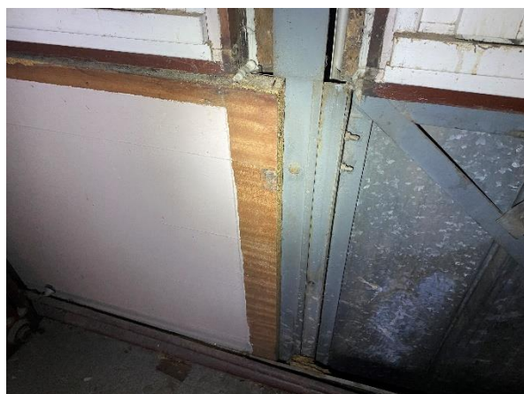
Photographie du poteau IPE140 et de la structure en façade
