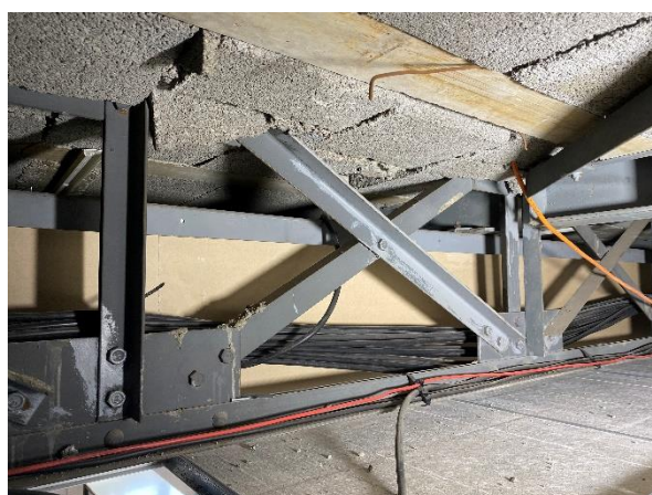
Photographie de la poutre treillis longitudinale AA
