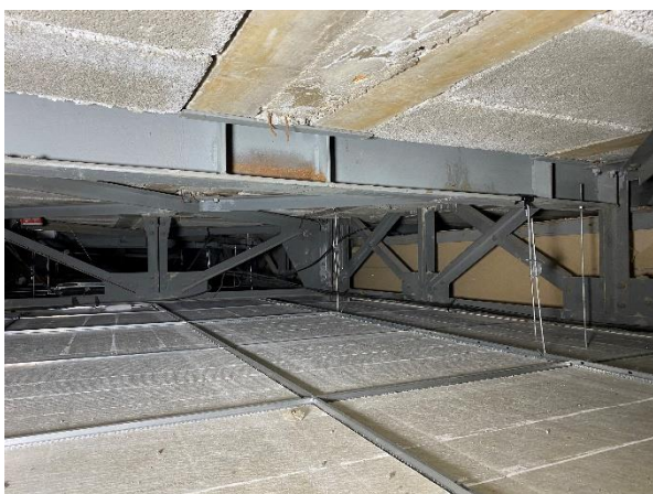
Photographie de la poutre treillis longitudinale AA
