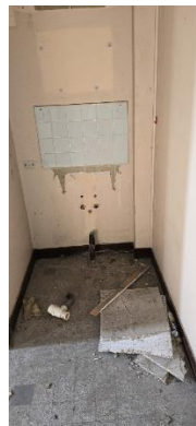
Sanitaires déposés réseaux à curer
