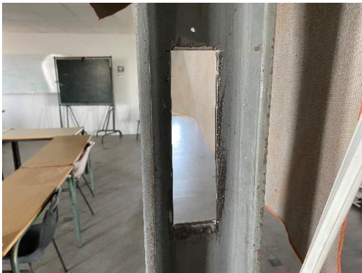
Photographie du prélèvement et du rebouchage d'acier sur le poteau
