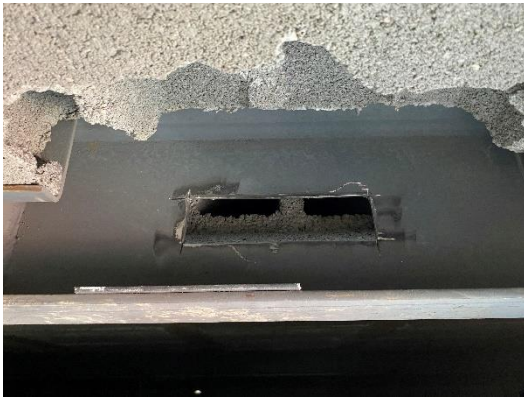
Photographie du prélèvement et du rebouchage d'acier sur la poutre secondaire
