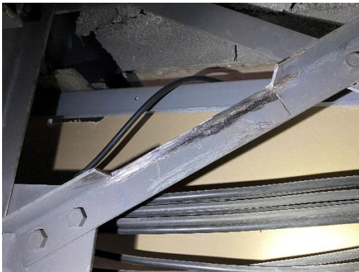
Photographie du prélèvement et du rebouchage d'acier sur la poutre treillis longitudinale
