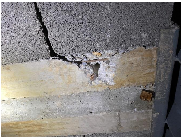
Photographie du sondage de la poutrelle dans le couloir
