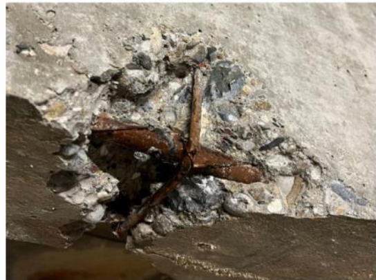
Sondage SP-2 – Sous-face poutre
