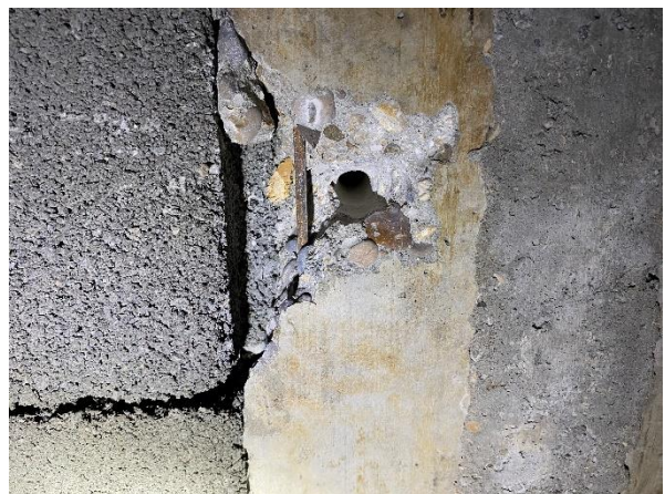
Photographie du sondage de la poutrelle dans le couloir
