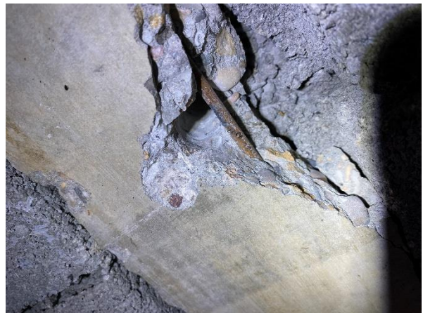
Photographie du sondage d'une poutrelle
