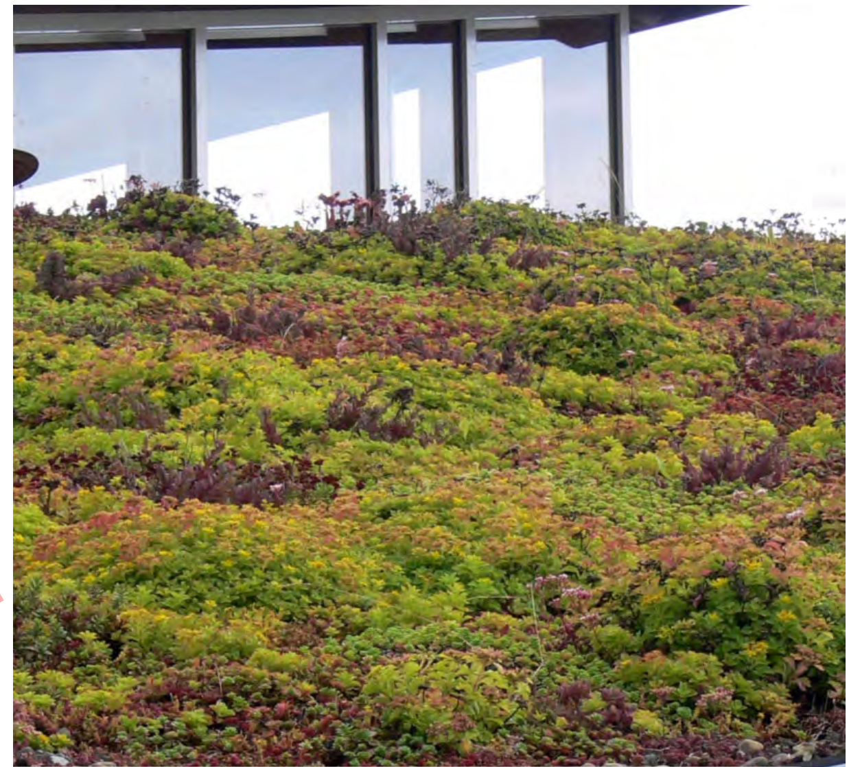
Toiture végétalisée extensive (performances thermiques améliorées et risques de fuite minorés)
