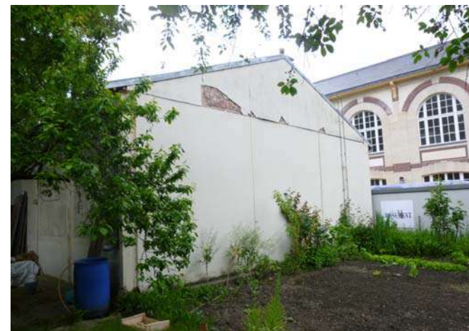
7. Vue de la façade Ouest. On note l'absence de modénature sur ce pignon destiné à être démoli en cas d'agrandissement du bâtiment.
