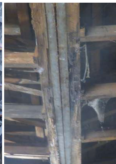
25. Détail des structures supportant les chéneaux
