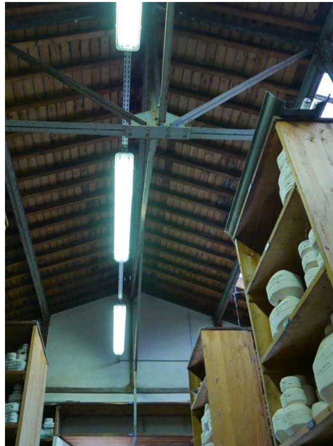
4. Charpente métallique de la réserve apparente
