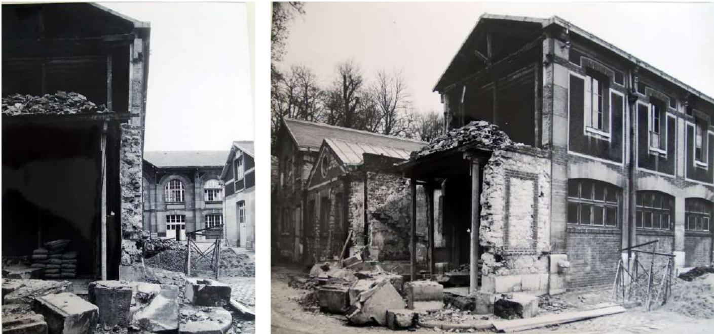
3-4. Photographies du bâtiment 13 suite aux bombardements de 1944. On remarque la charpente en bois traditionnelle du corps de bâti Sud.
