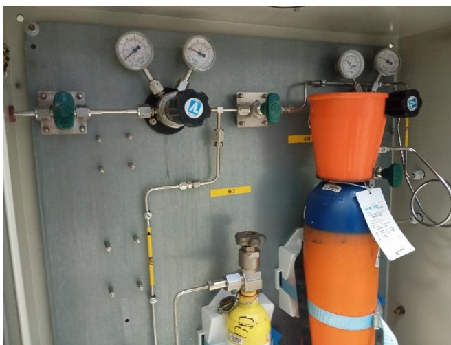
Figure 1 armoire ventilée de départ des lignes de gaz (A1), les débitmètres entourés en rouge seront démontés pour laisser des raccord VCR à joint argent. Armoire A2 qui verra partir les lignes de \text{N}_2\text{O} et \text{NH}_3
