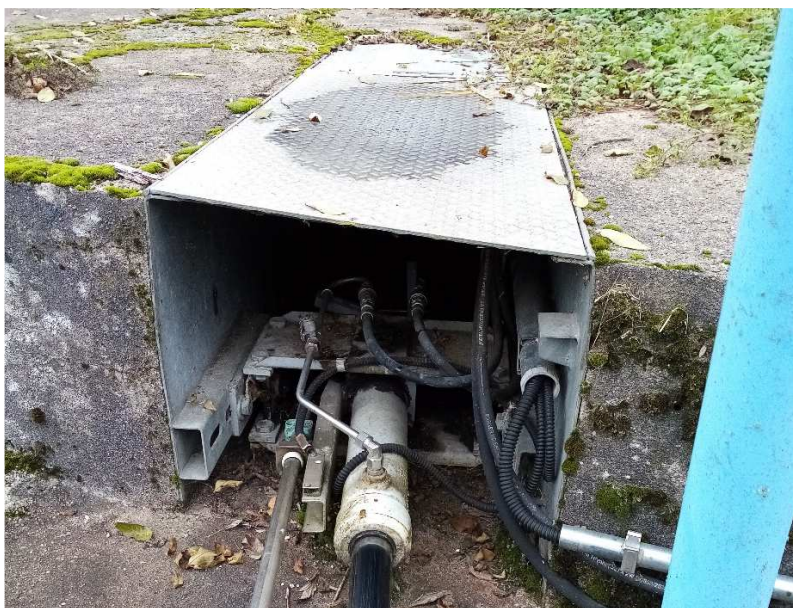
Exemple à l'écluse 16. La borne est située à l'arrière du vérin
