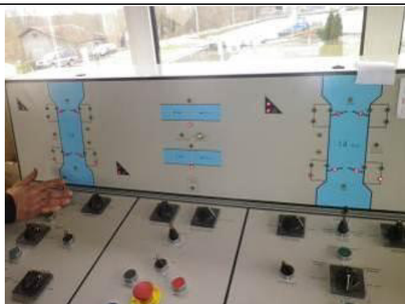
Figure 5 : Tableau synoptique de commande dans cabine orienté vers bief amont :
