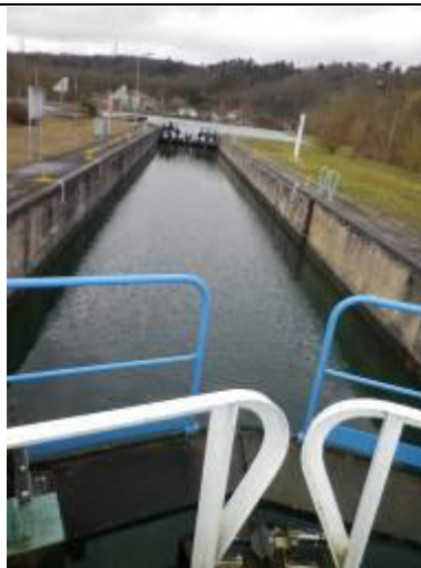
Figure 4 : Ecluse 14 bis avec bajoyers. Au fond, le bief amont.
