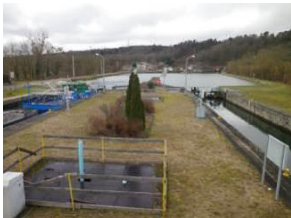
Figure 3 : Au fond, bief amont. Au premier plan, fosse de vannage d'épargne d'eau aval.
