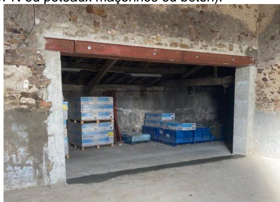
Exemple de renfort pour poutres métalliques moisées
