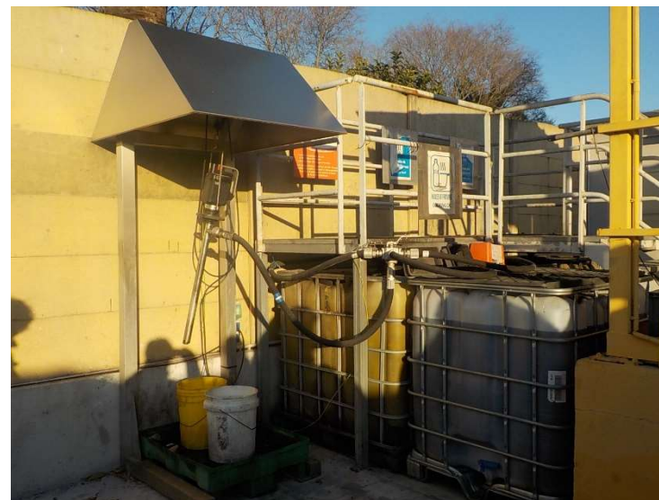
Cuve de dépôt des eaux de cales, liquides de refroidissement, eaux hydrocarburées et huiles alimentaires.
