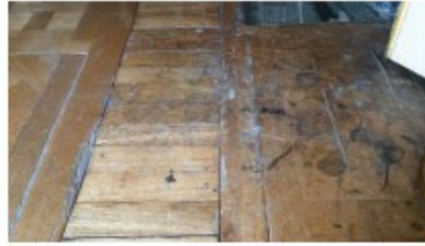
Encrassement, enfoncements, lames cassées (appartements Napoléon III)
