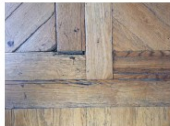
Défauts d'assemblages
