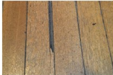
Arrachements au droit des languettes
