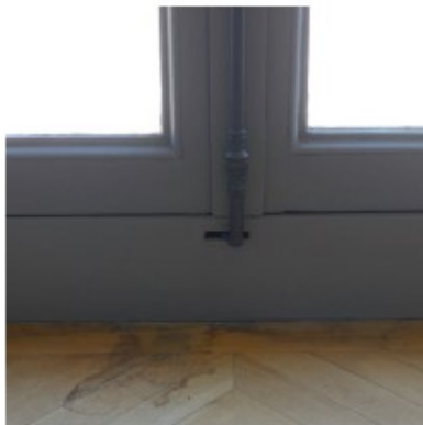
Défaut d'étanchéité des menuiseries
