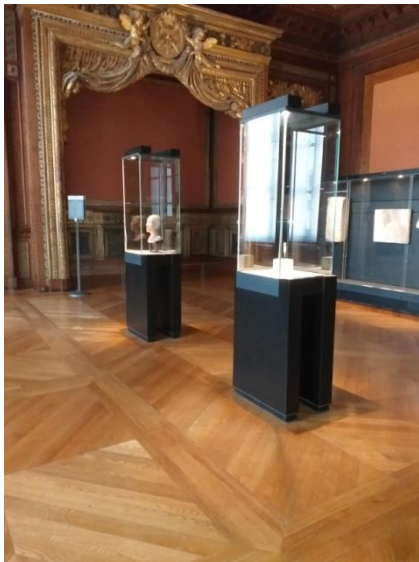
Le parquet point de Hongrie de ces deux salles est encadré par une très large bordure en panneaux à compartiments d'épaisseur 30mm avec des motifs différents selon les salles
