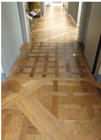
Passage de porte et embrasure de fenêtre en motif de vannerie type Chantilly
