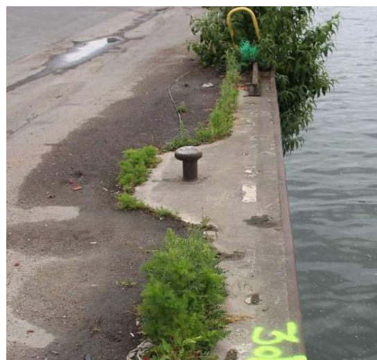
Bollard sur la poutre de couronnement
