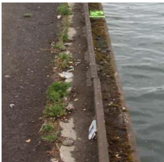
Chasse-roue sur la poutre de couronnement
