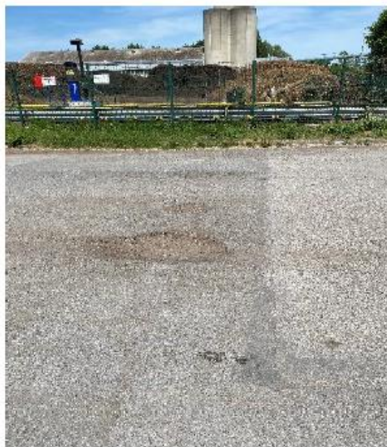
Photographies illustratives de reprise de voirie à effectuer sur le terre-plein
