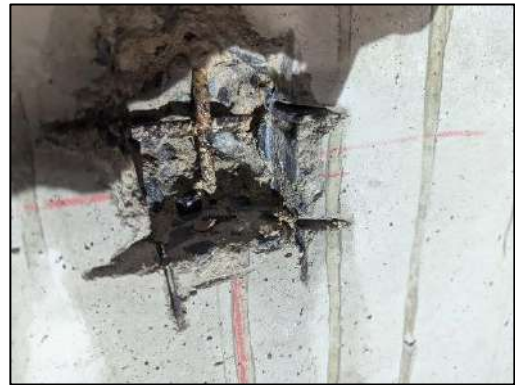
Vue des armatures présentes dans le voile BA
