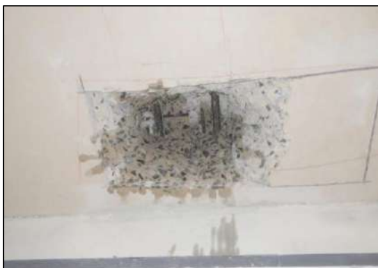
Vue générale du sondage en appui de la dalle
