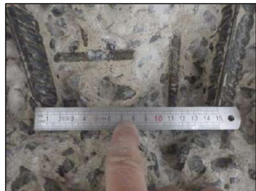
Prise de mesure de l'entraxe entre les aciers porteurs HA20
