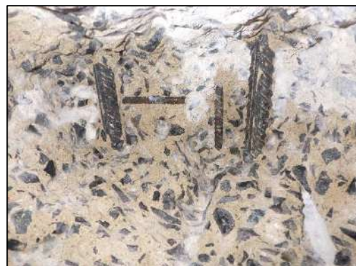
Vue des armatures présentes dans la dalle
