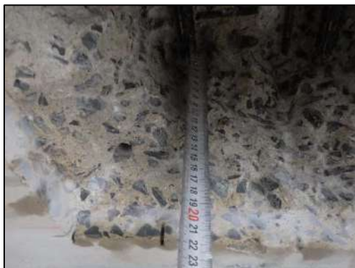
Mesure de l'enrobage (20,5 cm) des aciers porteurs HA20
