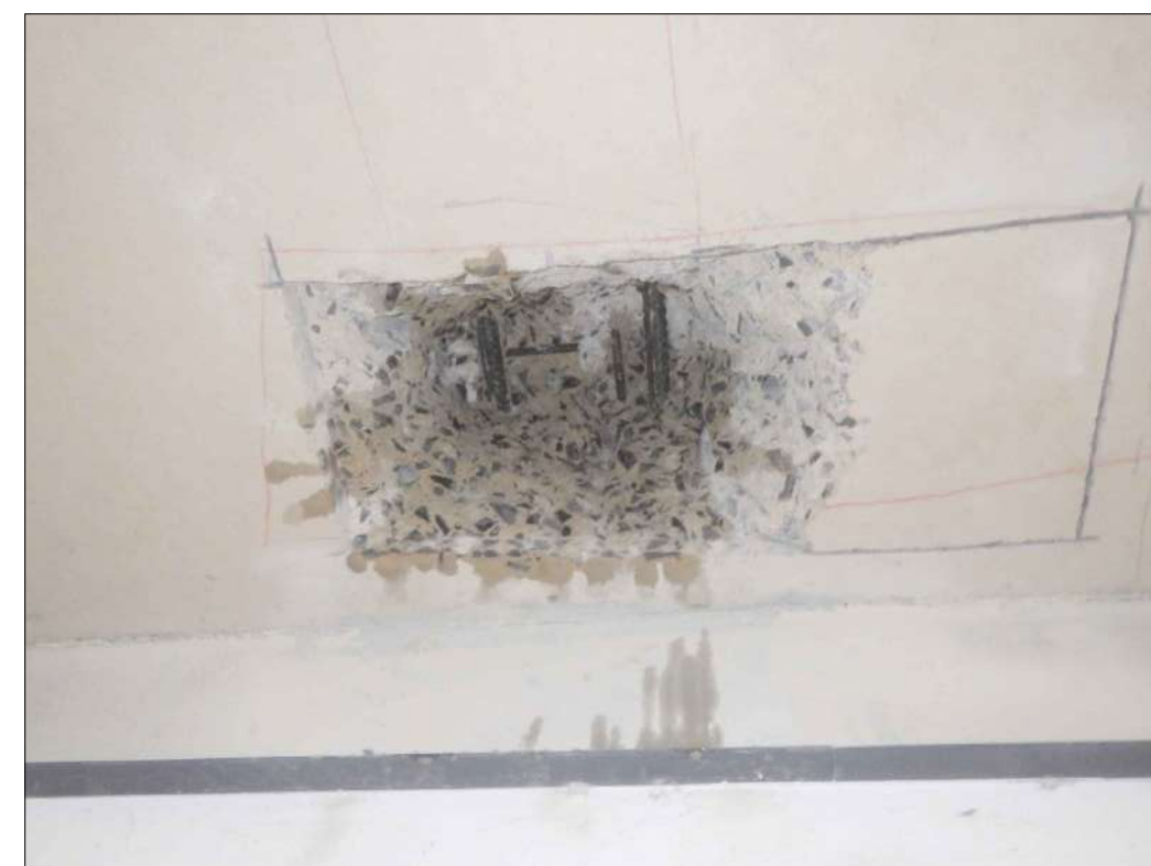
Sondage en sous-face de la dalle béton armé
