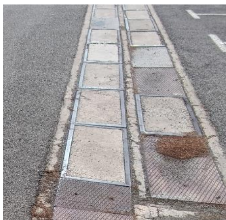
Figure 4 : Exemple de double caniveaux à passer en simple caniveaux
