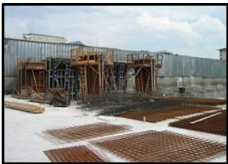
Zone de stockage des aciers et des banches
