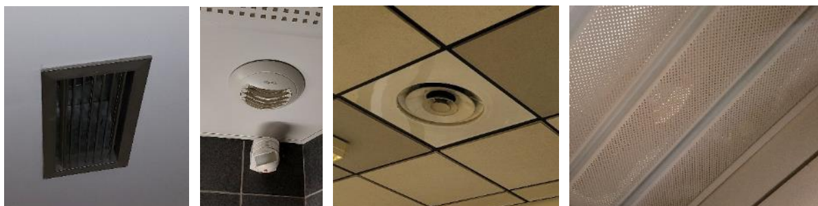
Différents types de bouches d'extraction rencontrées, visibles ou au-dessus du plafond métallique
