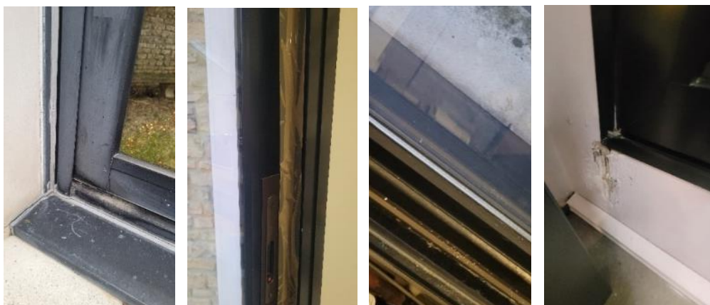
Laquage décoloré, étanchéité à l'air imparfaite, double vitrage minimaliste, infiltrations (de gauche à droite)
