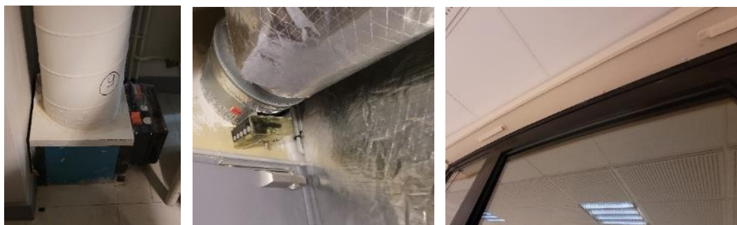
Réseau de gaine avec clapet coupe-feu / Entrée d'air (à droite)
