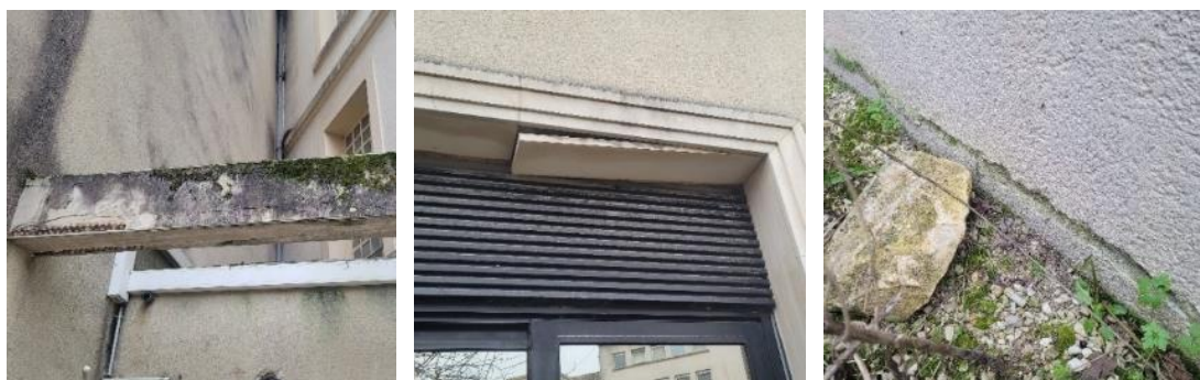
Façade arrière : Enduits sur poutres dégradés / Parement à refixer en linteau / Enduit dégradé en pied
