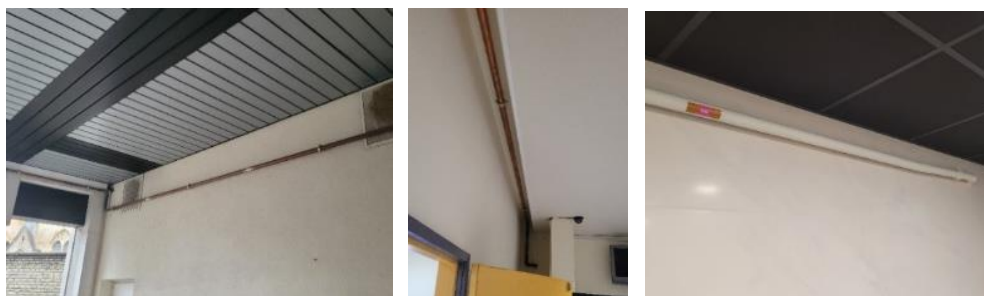
Cheminement du réseau gaz au RDC
