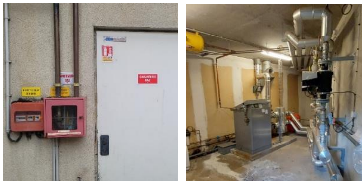
Chaudière gaz en chaufferie
