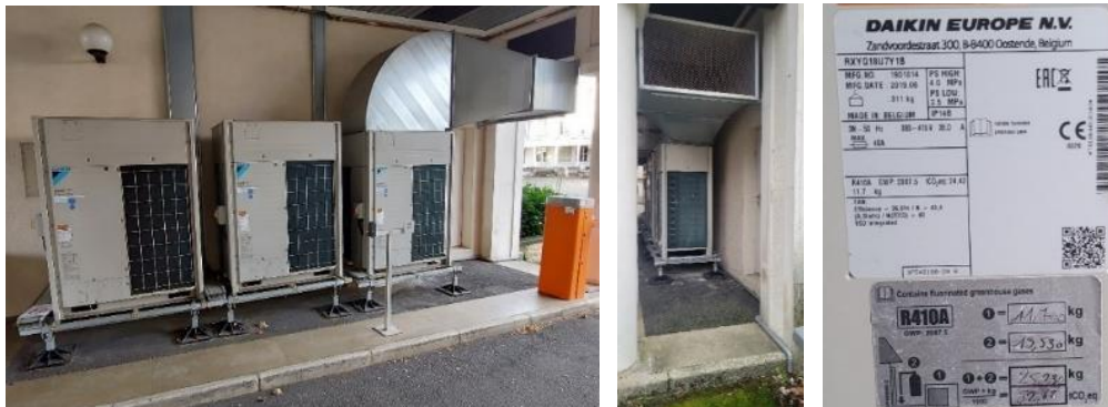
3 unités extérieures VRV DAIKIN (VRV IV+ INVERTER)
