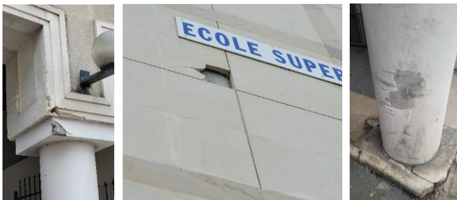
Quelques dégradations localisées suite à chocs mécaniques
