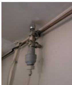
Raccordement d'une fontaine à eau
