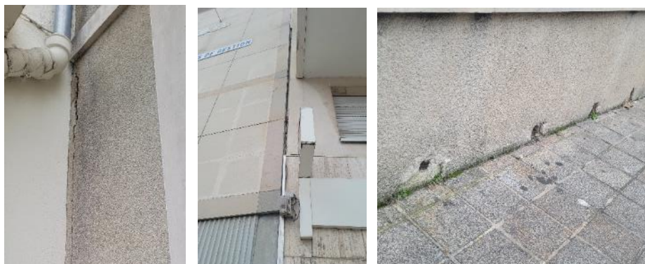
Façade sur rue : Fissuration et traitement de JD à reprendre en liaison avec immeubles tiers / Enduits dégradés en pied avec éléments métalliques corrodés
