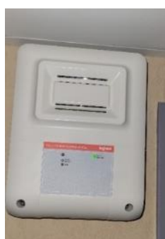
Diffuseur sonore, diffuseur sonore et lumineux, porte sur ventouse (de gauche à droite)
