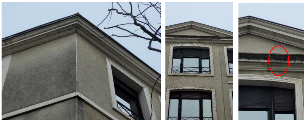
Encrassement des enduits et points singuliers (corniches, ceintures, encadrement de baies), joint de corniche à reprendre
