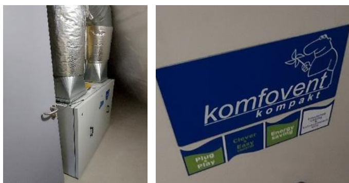
Centrale double-flux en local technique R+4
