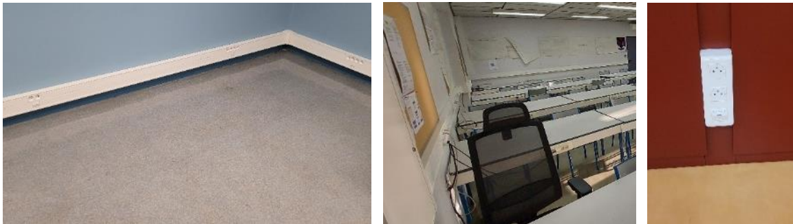
Distribution en goulottes techniques basses et haute / en cloison
