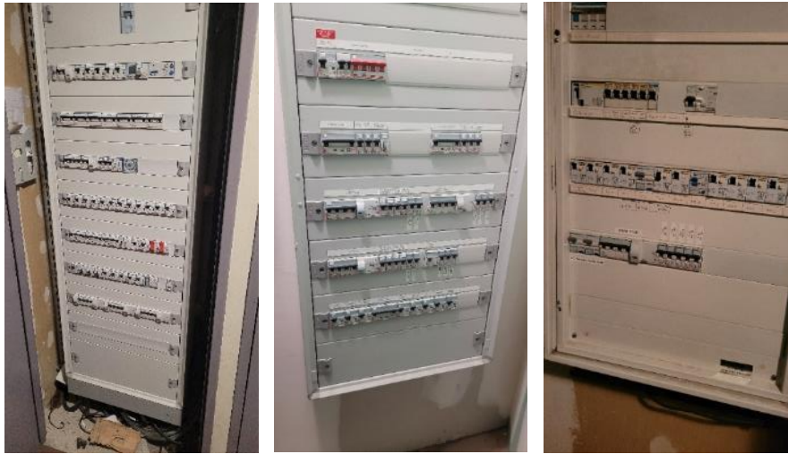
TGBT (à gauche) / différentes générations de tableaux divisionnaires
