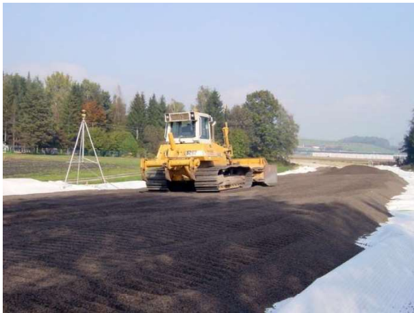
Figure 5 : mise en place au buteur ou par soufflage
