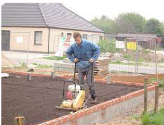
Figure : à gauche : Compactage à la plaque vibrante légère ; à droite : compactage au rouleau vibrant léger
