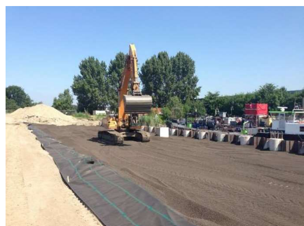
Etalement – mise en œuvre au godet de pelle
