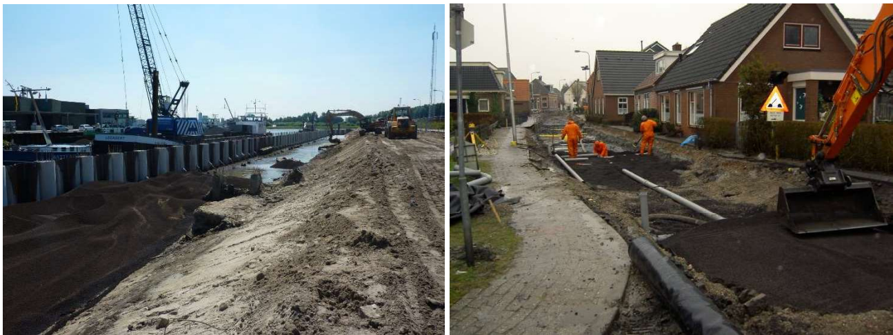
Figure 6 : à gauche : remblayage en arrière de mur de quai (Zeebrugge – Belgique) – à droite : remblai de voirie (Ossenzijl – Pays-Bas)
