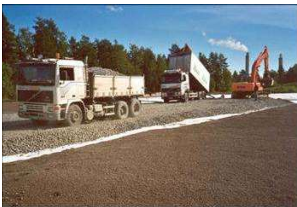
Figure : à gauche : Accès sur Argex avec une piste spécialement créée pour un trafic de chantier ; à droite : passage d'un véhicule léger sur ARGEX AG0/4-500 concassé (humidité 26%)
