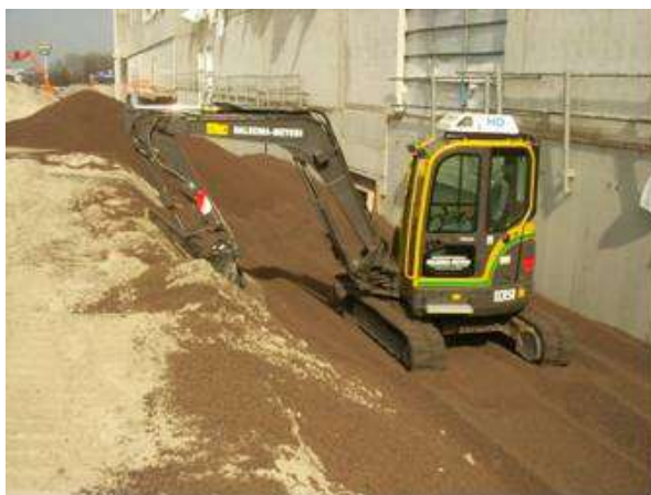
Etalement – mise en œuvre au godet de pelle
