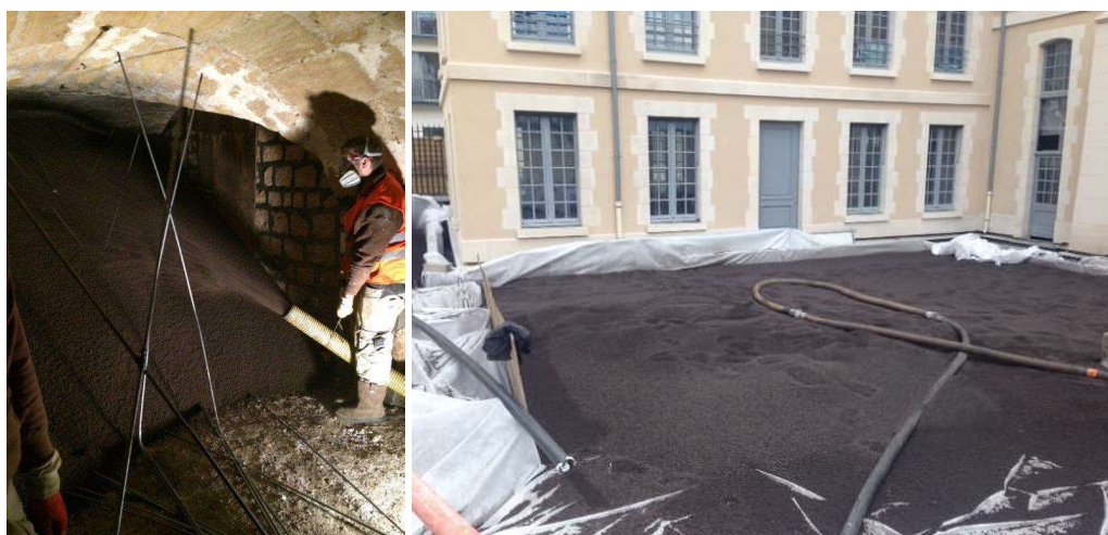
Figure 7 : à gauche : remblayage de cavité souterraine anthropique sous la RD203 (France) ; à droite : plateforme support de dallage à l'Hôpital de Laennec (France)
