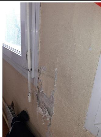
Prélèvement - P026 : BÂTIMENT 0006 / NIVEAU 2 / CHAMBRE 234 - Toile de verre- (Absence d'amiante)
