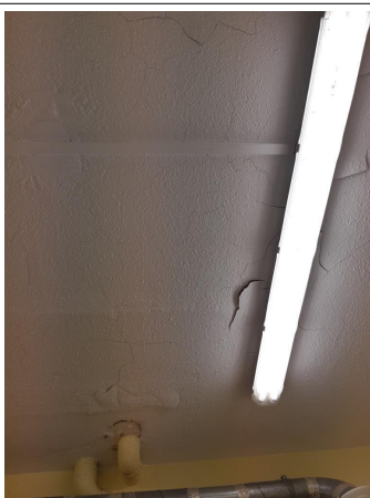
Prélèvement - P009 : BÂTIMENT 0006 / NIVEAU 3 / WCS COMMUNS 2 - Enduit- (Absence d'amiante)
