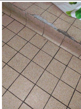
Prélèvement - P050 : BÂTIMENT 0006 / NIVEAU 1 / CHAMBRE 134 / SANITAIRES - Colle- (Absence d'amiante)
