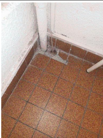
Prélèvement - P065 : BÂTIMENT 0006 / NIVEAU 0 / MAGASIN 10 - Colle- (Absence d'amiante)
