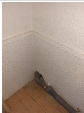
Prélèvement - P004 : BÂTIMENT 0006 / NIVEAU 3 / CHAMBRE 305 / SANITAIRES - Enduit- (Absence d'amiante)
