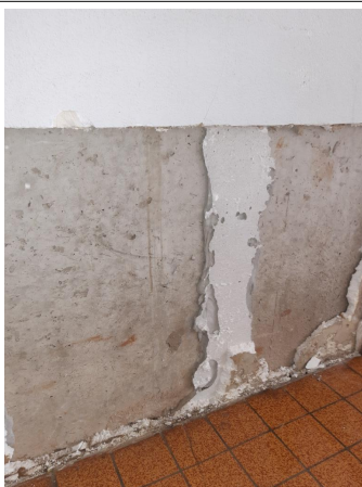
Prélèvement - P092 : BÂTIMENT 0006 / NIVEAU 3 / ESCALIER 2 - Plot de colle- (Absence d'amiante)
