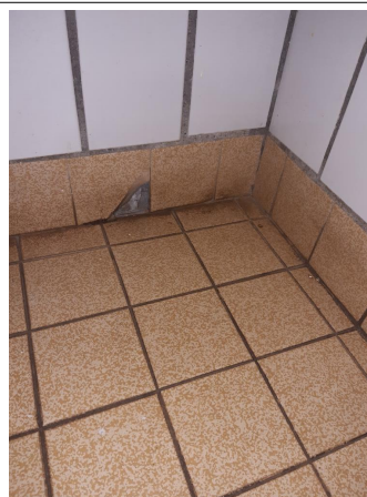
Prélèvement - P068 : BÂTIMENT 0006 / NIVEAU 0 / WCS COMMUNS 3 - Colle- (Absence d'amiante)
