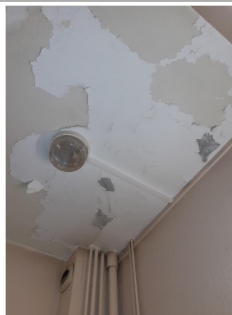
Prélèvement - P044 : BÂTIMENT 0006 / NIVEAU 1 / CHAMBRE 129 / SALLE D'EAU - Enduit- (Absence d'amiante)
