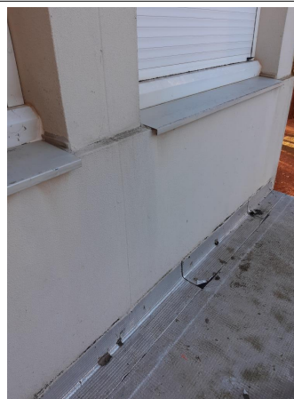
Prélèvement - P082 : BÂTIMENT 0006 / NIVEAU EXTERIEUR / FACADE SUD - Enduit- (Présence d'amiante)
