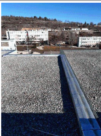
Prélèvement - P085 : BÂTIMENT 0006 / NIVEAU 4 / TOITURE TERRASSE - Relevé d'étanchéité- (Absence d'amiante)
