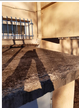
Prélèvement - P084 : BÂTIMENT 0006 / NIVEAU EXTERIEUR / FACADE NORD - Revêtement d'étanchéité- (Présence d'amiante)
