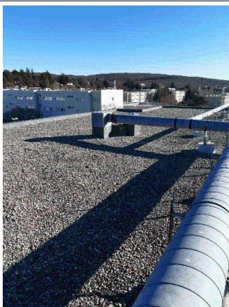
Prélèvement - P088 : BÂTIMENT 0006 / NIVEAU 4 / TOITURE TERRASSE - Revêtement bitumineux- (Absence d'amiante)
