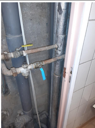
Prélèvement - P031 : BÂTIMENT 0006 / NIVEAU 2 / DOUCHES COMMUNES 1 / GAINTE TECHNIQUE - Calorifugeage- (Absence d'amiante)
