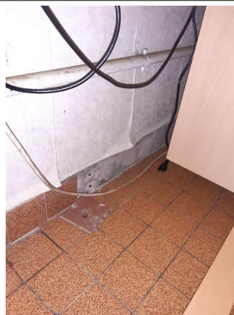
Prélèvement - P006 : BÂTIMENT 0006 / NIVEAU 3 / CHAMBRE 306 - Colle- (Présence d'amiante)
