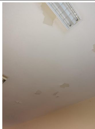
Prélèvement - P032 : BÂTIMENT 0006 / NIVEAU 2 / CHAMBRE 205 - Enduit- (Absence d'amiante)
