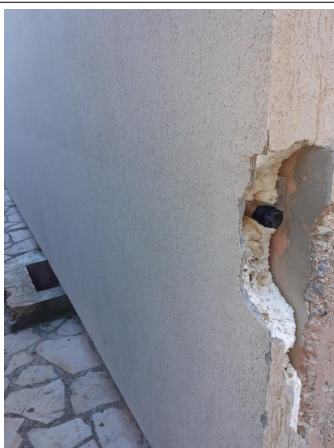
Prélèvement - P073 : BÂTIMENT 0006 / NIVEAU EXTERIEUR / PIGNON OUEST - Enduit- (Absence d'amiante)
