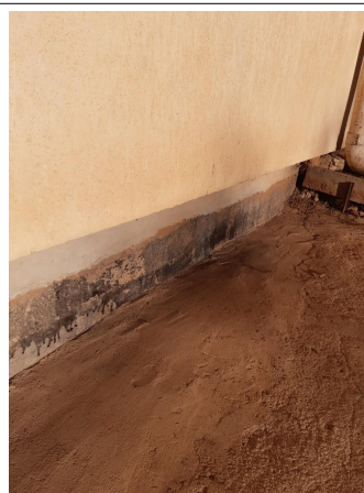
Prélèvement - P078 : BÂTIMENT 0006 / NIVEAU EXTERIEUR / FACADE NORD - Enduit- (Absence d'amiante)
