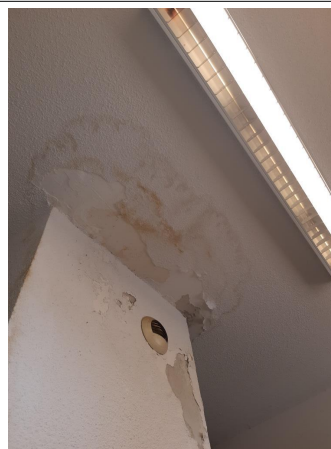
Prélèvement - P063 : BÂTIMENT 0006 / NIVEAU 0 / LOCAL 25 - Enduit- (Absence d'amiante)
