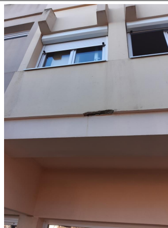
Prélèvement - P070 : BÂTIMENT 0006 / NIVEAU EXTERIEUR / FACADE SUD - Enduit- (Présence d'amiante)
