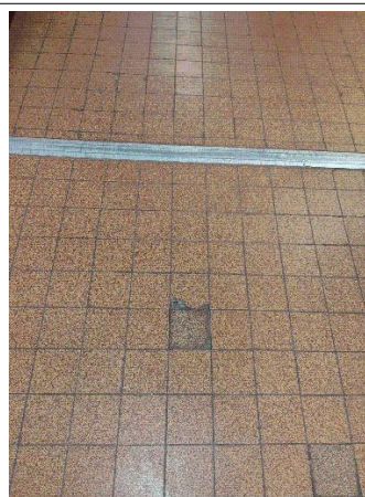
Prélèvement - P053 : BÂTIMENT 0006 / NIVEAU 0 / HALL D'ENTREE 1 - Colle- (Absence d'amiante)
