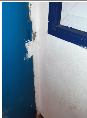
Prélèvement - P055 : BÂTIMENT 0006 / NIVEAU 0 / PALIER ESCALIER 1 - Bande calicot- (Absence d'amiante)
