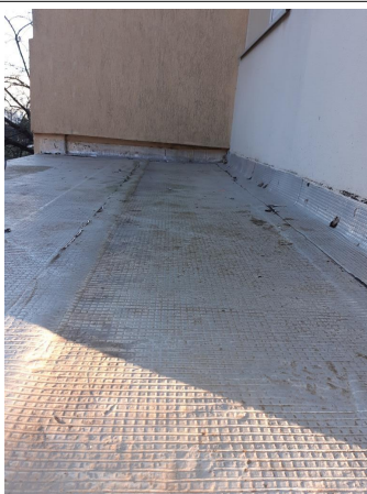
Prélèvement - P081 : BÂTIMENT 0006 / NIVEAU EXTERIEUR / FACADE SUD - Revêtement d'étanchéité- (Absence d'amiante)
