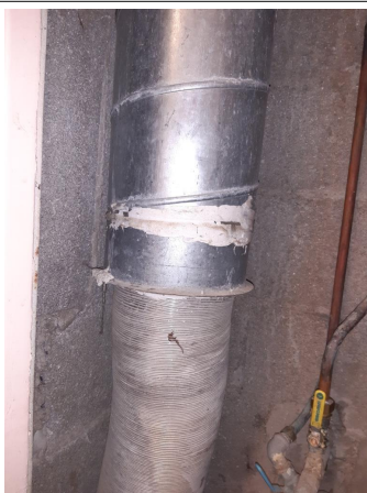
Prélèvement - P039 : BÂTIMENT 0006 / NIVEAU 2 / DOUCHES COMMUNES 2 / GAINTE TECHNIQUE - Mastic- (Absence d'amiante)
