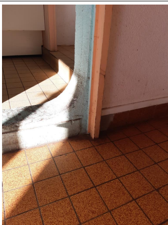
Prélèvement - P017 : BÂTIMENT 0006 / NIVEAU 3 / CHAMBRE 318 - Colle- (Présence d'amiante)
