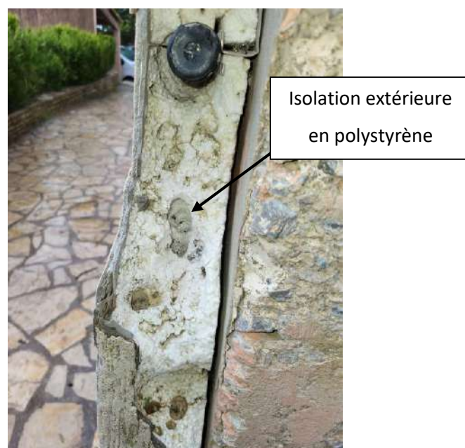
Photo du sondage SH03 (à gauche) et photo de l'isolation extérieure (à droite)
