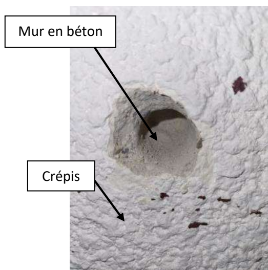
Photo du sondage SH02 (à gauche) et coupe de structure SH02 (à droite)
