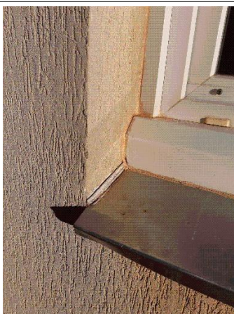
Prélèvement - P079 : BÂTIMENT 0006 / NIVEAU EXTERIEUR / PIGNON EST - Mastic- (Présence d'amiante)
