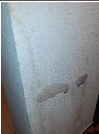
Prélèvement - P062 : BÂTIMENT 0006 / NIVEAU 0 / LOCAL 25 - Enduit- (Absence d'amiante)
