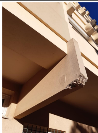
Prélèvement - P076 : BÂTIMENT 0006 / NIVEAU EXTERIEUR / FACADE NORD - Enduit- (Absence d'amiante)
