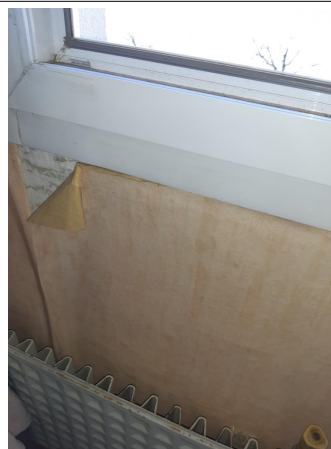
Prélèvement - P038 : BÂTIMENT 0006 / NIVEAU 2 / CHAMBRE 206 - Revêtement- (Absence d'amiante)
