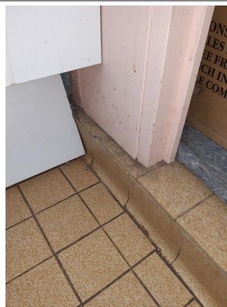
Prélèvement - P034 : BÂTIMENT 0006 / NIVEAU 2 / CHAMBRE 230 / SANITAIRES - Colle- (Absence d'amiante)
