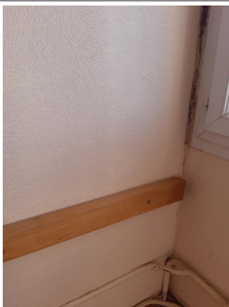
Prélèvement - P015 : BÂTIMENT 0006 / NIVEAU 3 / CHAMBRE 318 - Bande calicot- (Absence d'amiante)
