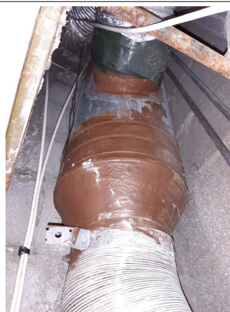
Prélèvement - P030 : BÂTIMENT 0006 / NIVEAU 2 / DOUCHES COMMUNES 1 / GAINÉ TECHNIQUE - Mastic- (Absence d'amiante)
