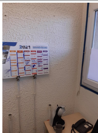
Prélèvement - P061 : BÂTIMENT 0006 / NIVEAU 0 / BUREAU 4 - Enduit- (Absence d'amiante)
