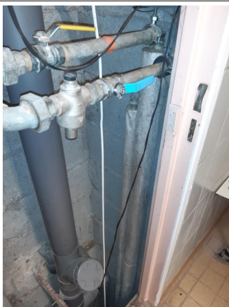
Prélèvement - P013 : BÂTIMENT 0006 / NIVEAU 3 / DOUCHES COMMUNES 3 / GAINE TECHNIQUE - Calorifugeage- (Absence d'amiante)
