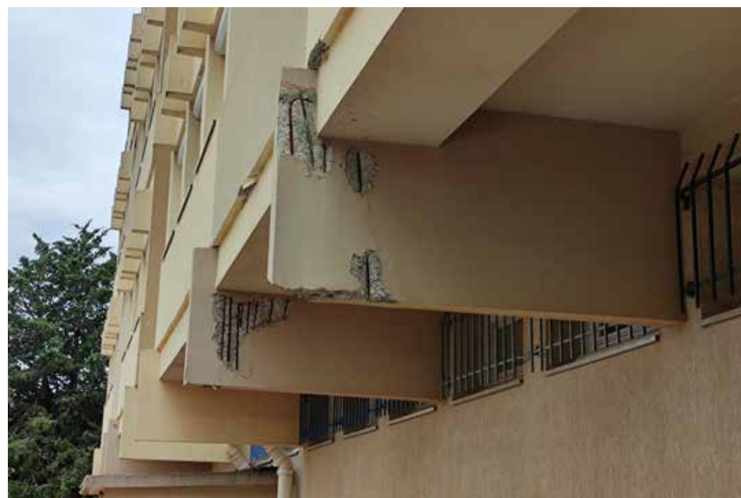
Epaufures au niveau des nez de dalles et des poutres en saillie Fers apparents sur les nez de dalles et sur le côté des poutres en saillie
