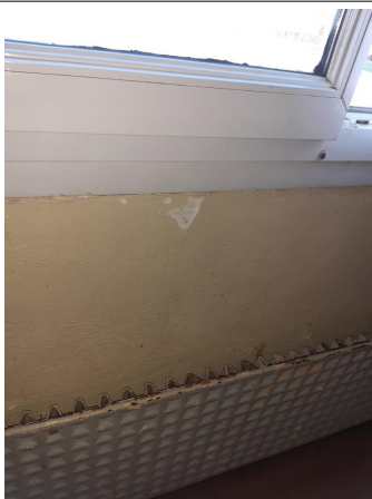
Prélèvement - P033 : BÂTIMENT 0006 / NIVEAU 2 / CHAMBRE 205 - Enduit- (Absence d'amiante)
