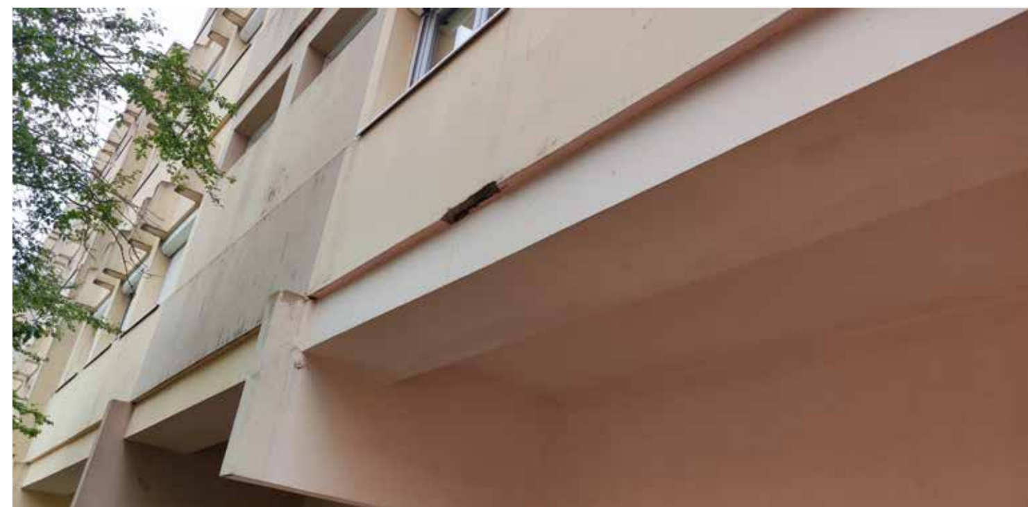
Epaufrures au niveau des nez de dalles Fers apparents sur les nez de dalles
