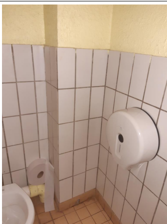
Prélèvement - P067 : BÂTIMENT 0006 / NIVEAU 0 / WCS COMMUNS 3 - Colle- (Absence d'amiante)
