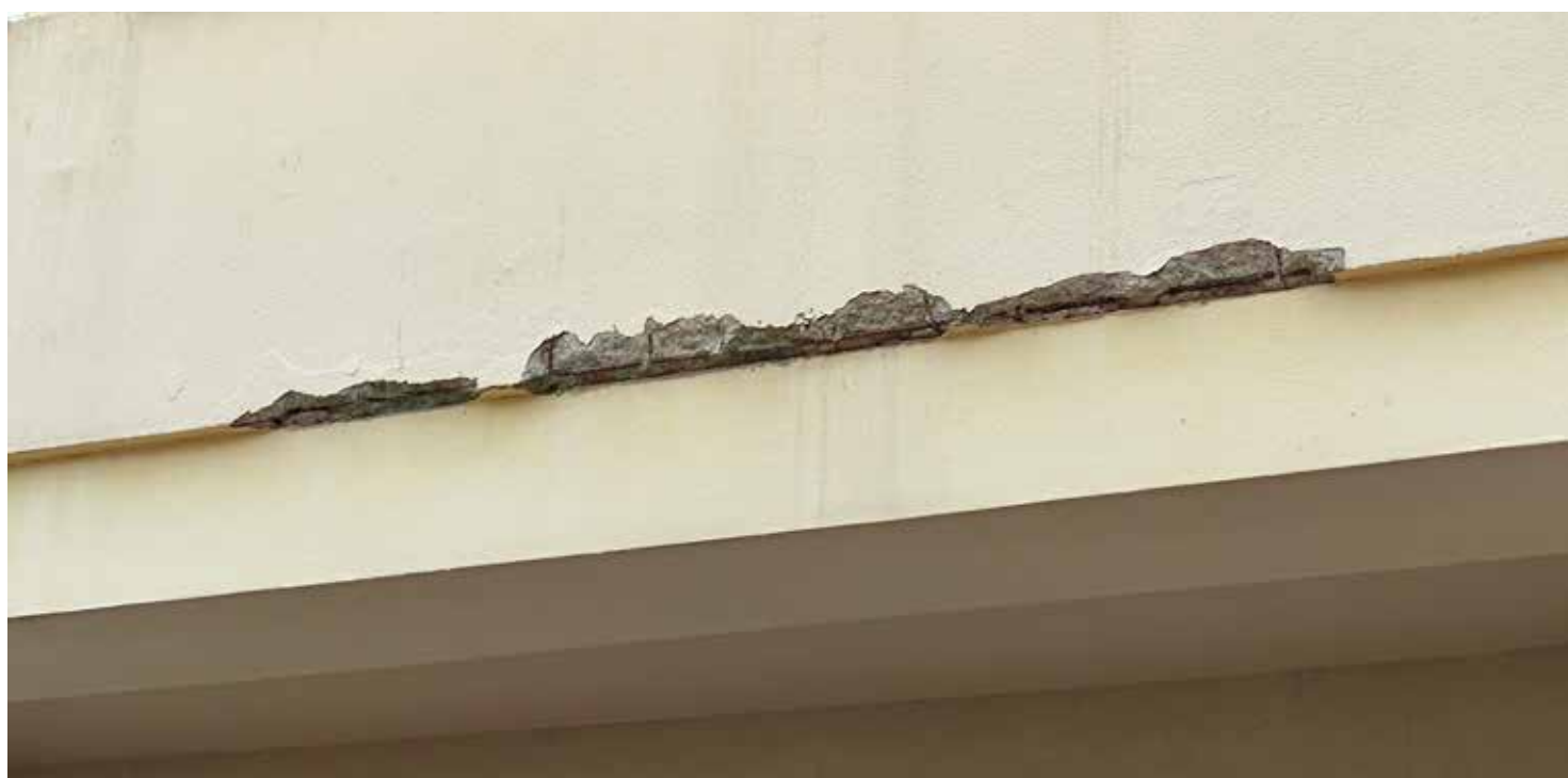
Epaufrures au niveau des nez de dalles Fers apparents sur les nez de dalles
