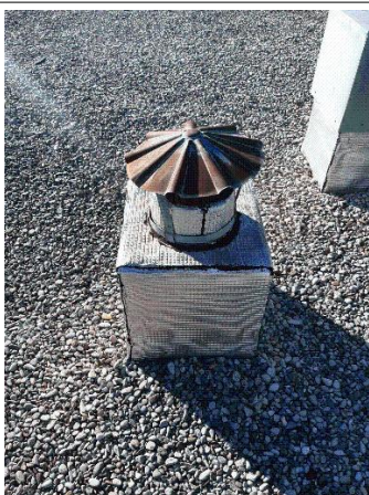
Déclaré - : BÂTIMENT 0006 / NIVEAU 4 / TOITURE TERRASSE - Conduit- (Présence d'amiante)
