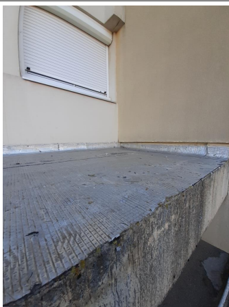
Prélèvement - P083 : BÂTIMENT 0006 / NIVEAU EXTERIEUR / FACADE SUD - Revêtement d'étanchéité- (Absence d'amiante)
