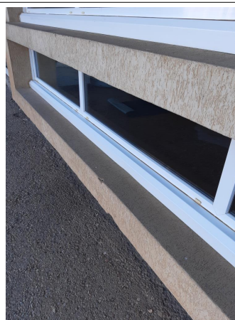
Prélèvement - P072 : BÂTIMENT 0006 / NIVEAU EXTERIEUR / FACADE SUD - Enduit- (Absence d'amiante)
