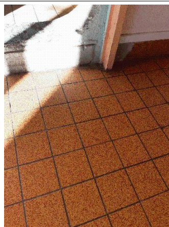
Prélèvement - P018 : BÂTIMENT 0006 / NIVEAU 3 / CHAMBRE 318 - Colle- (Absence d'amiante)
