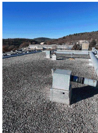
Prélèvement - P095 : BÂTIMENT 0006 / NIVEAU 4 / TOITURE TERRASSE - Revêtement d'étanchéité- (Absence d'amiante)
