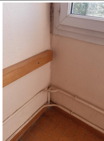
Prélèvement - P014 : BÂTIMENT 0006 / NIVEAU 3 / CHAMBRE 318 - Toile de verre- (Absence d'amiante)
