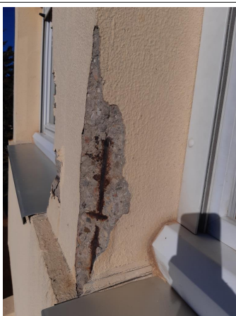
Prélèvement - P027 : BÂTIMENT 0006 / NIVEAU EXTERIEUR / FACADE NORD - Enduit- (Présence d'amiante)
