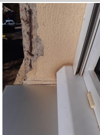
Prélèvement - P028 : BÂTIMENT 0006 / NIVEAU EXTERIEUR / FACADE NORD - Mastic- (Présence d'amiante)
