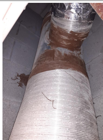
Prélèvement - P012 : BÂTIMENT 0006 / NIVEAU 3 / DOUCHES COMMUNES 3 / GAINTE TECHNIQUE - Mastic- (Absence d'amiante)
