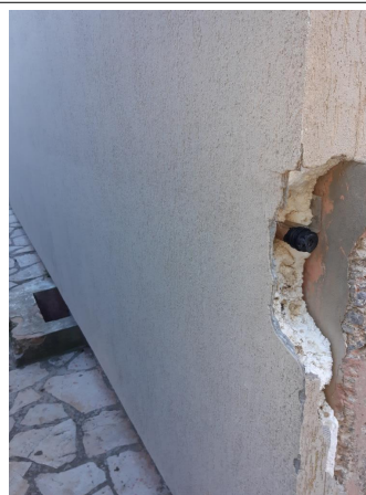
Prélèvement - P074 : BÂTIMENT 0006 / NIVEAU EXTERIEUR / PIGNON OUEST - Isolant- (Présence d'amiante)
