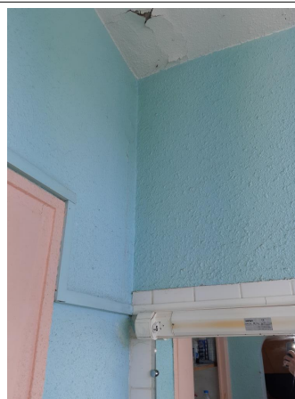
Prélèvement - P048 : BÂTIMENT 0006 / NIVEAU 1 / CHAMBRE 134 / SANITAIRES - Enduit- (Absence d'amiante)
