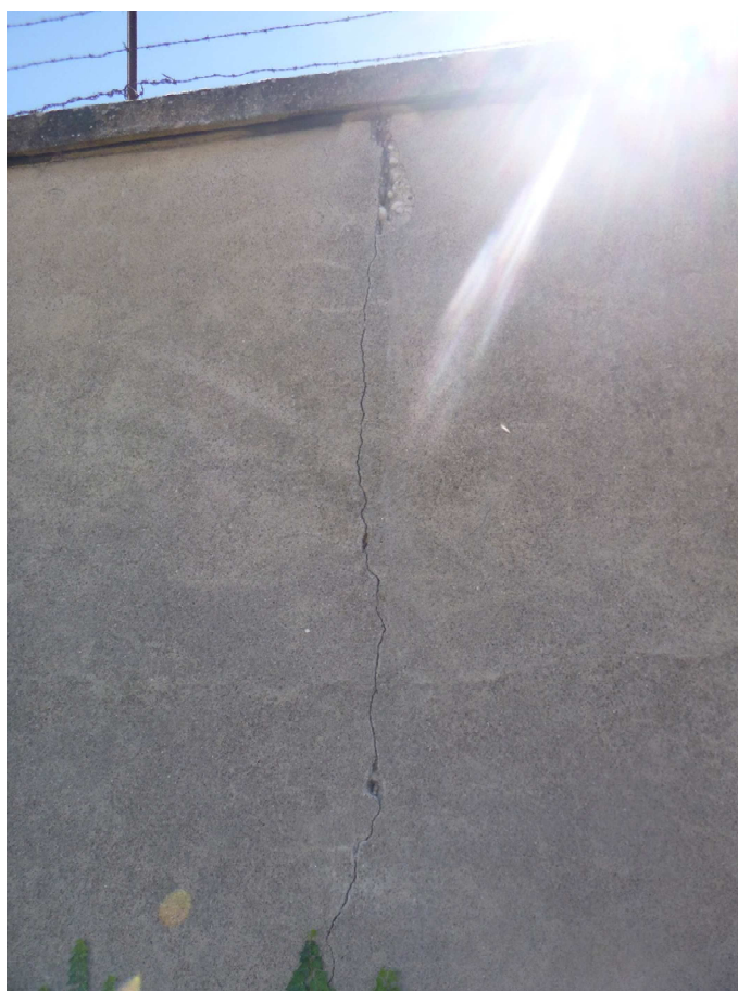
Photographie 19 : Nid de cailloux avec fissure verticale au droit d'un joint de couverture (765m)
