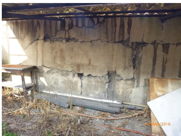
Photo 11 : Fractures vers extrémité Challemel Lacour – Côté SNCF
