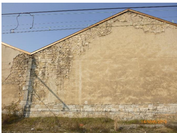
Photo 15 : Décollement d'enduit – Côté SNCF
