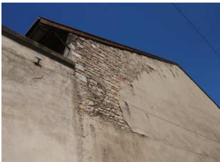
Figure 13 : Enduit se décollant – Source : Visite de site 05/2022
