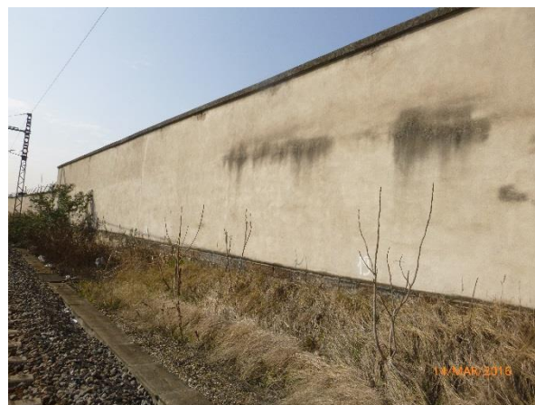
Photo 6 : Traces d'humidité
