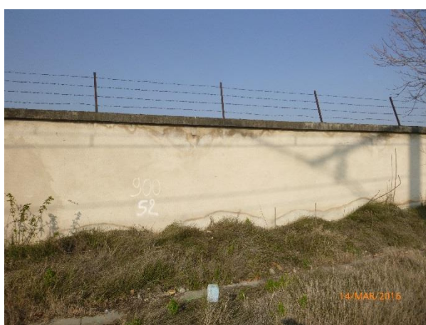
Photo 3 : Traces d'humidité sous casquette et remontées capillaires en pied de mur
