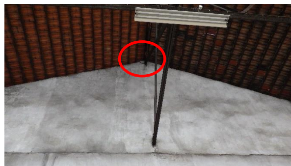
Photo 18 : Décollement profond – risque de chute imminent
