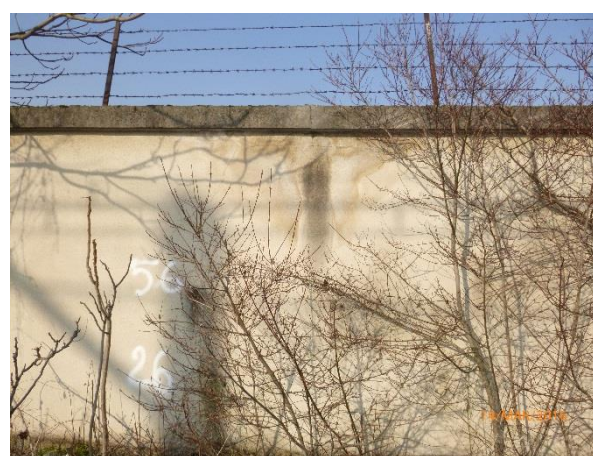
Photo 4 : Coulures et traces d'humidité sous casquette
