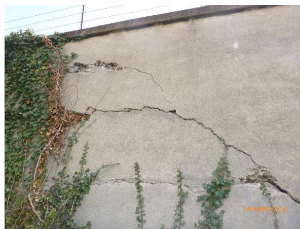
Photo 12 : Fractures vers extrémité Challemel Lacour – Côté caserne
