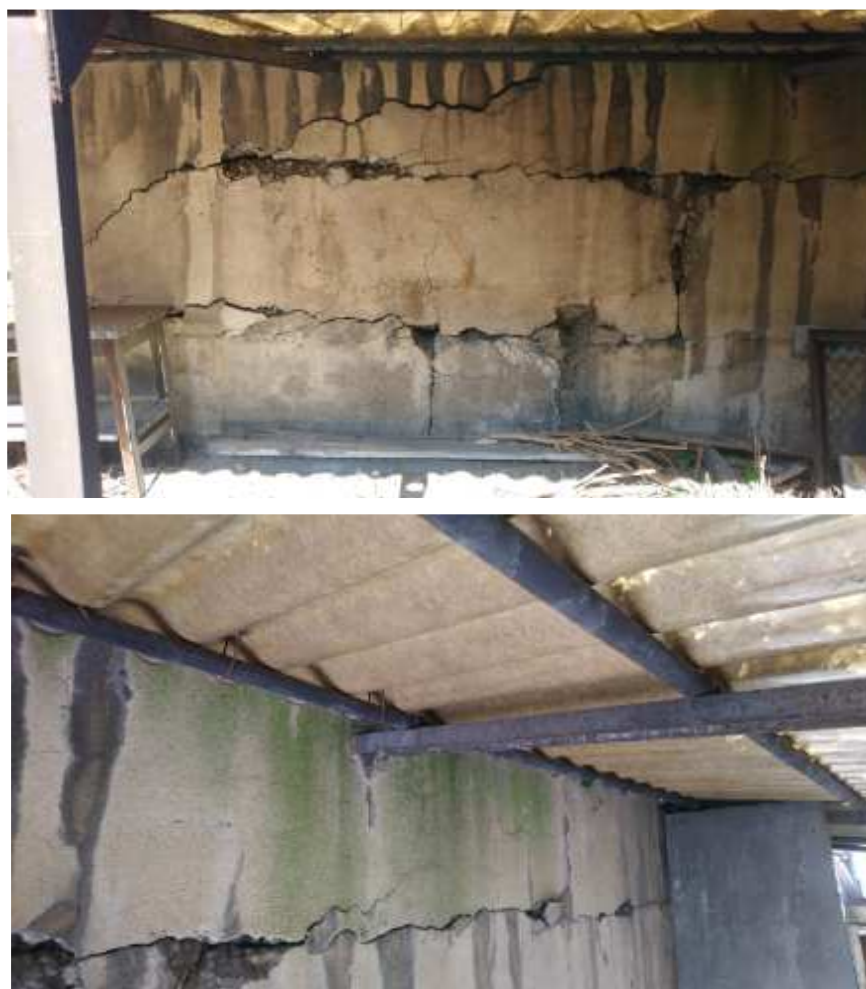
Figure 11 : Fractures dans la portion E du mur – Source : Visite de site 05/2022
