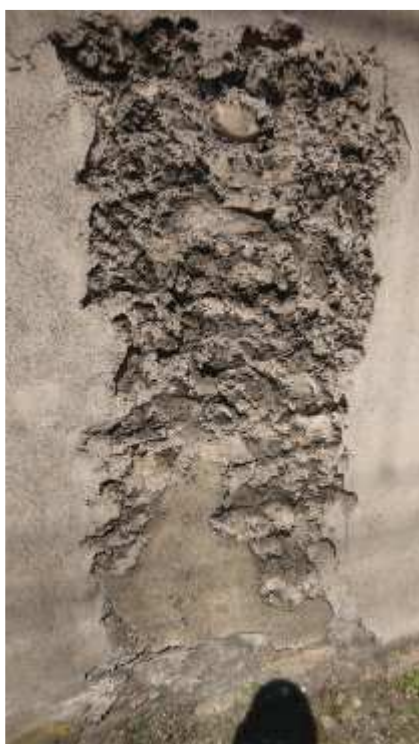
Figure 13 : Enduit se décollant – Source : Visite de site 05/2022
