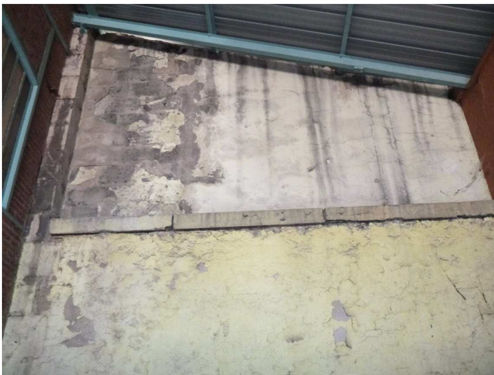
Photographie 11 : Bât 13 , humidité et décollement généralisé de l'enduit
