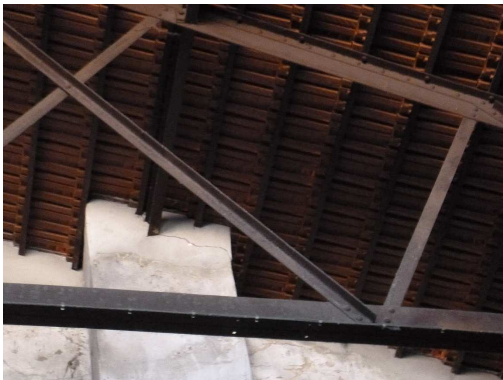
Photographie 18 : Travée 14, fissure d'éclatement en tête du poteau béton
