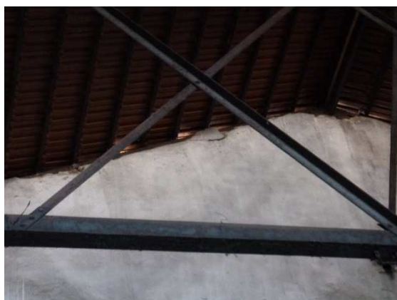
Décollements profonds avec risques de chute
