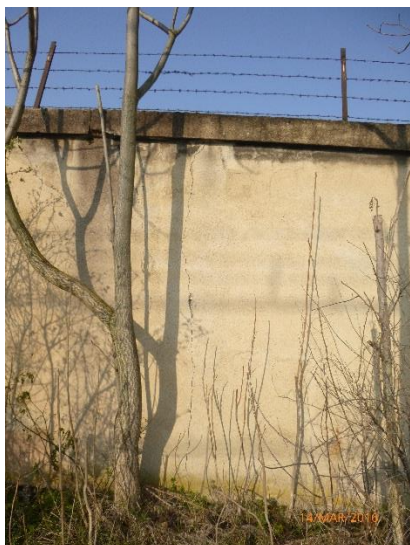
Photo 1 : Mousse en pied de mur et coulures sous casquette
