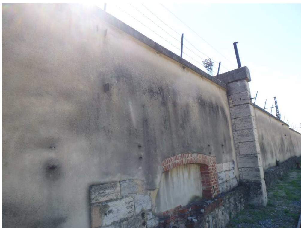
Photographie 5 :Tâche d'humidité et décollement de l'enduit -sonne creux- (390m)
