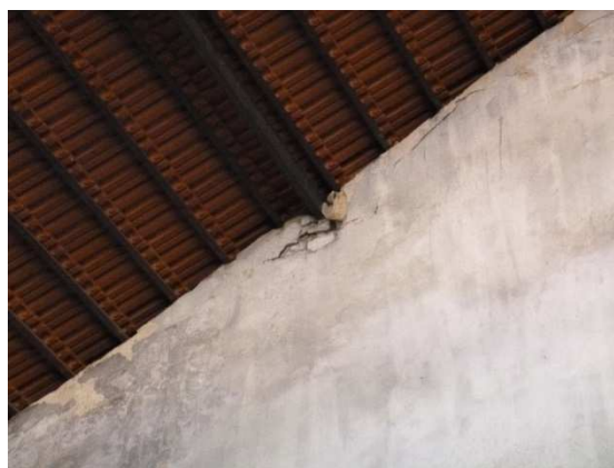
Décollements profonds avec risques de chute
