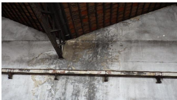
Photo 17 : Décollement d'enduit – Côté caserne
