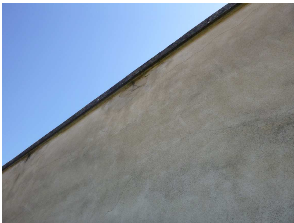
Photographie 7 : Humidité au niveau des joints de couvertines + fissures et décollement d'enduit (355m)
