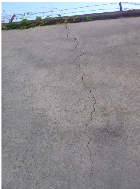
Photographie 8 : Fissure verticale d'ouverture proche du cm en extrémité de mur (796m)
