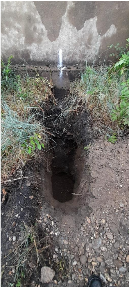
Figure 6 - Photo au droit de la reconnaissance de fondation RF1 (source : GÉOTEC)
