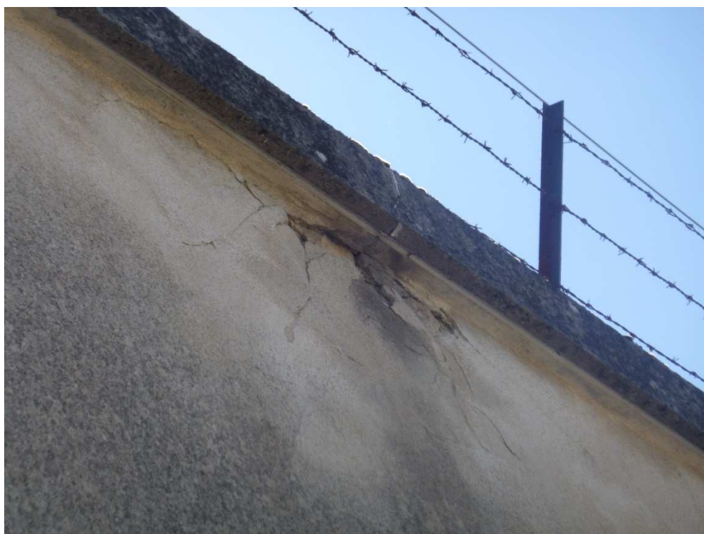
Photographie 6 :Humidité au niveau des joints de couvertines + décollement d'enduit (505m)
