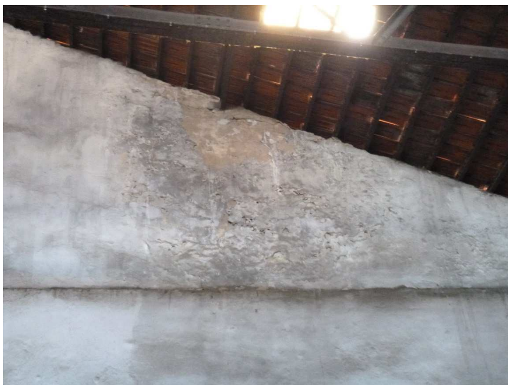
Photographie 15 : Travée 10 ; trace d'humidité et décollement d'enduit
