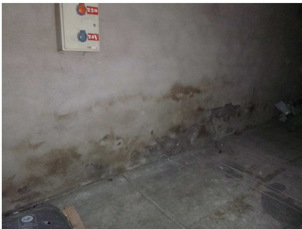
Photographie 13 : Bât15 trav4 ; humidité en pied sur 50cm hauteur
