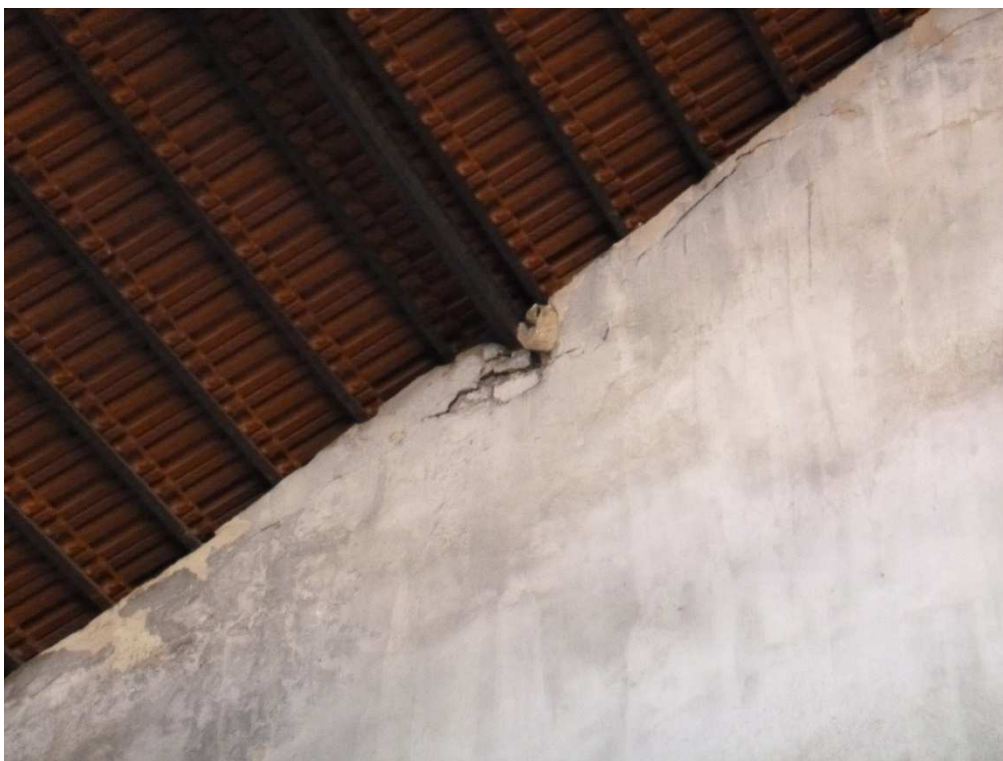
Photographie 17 : Travée 13 ; décollement avec risque de chute d'éclat en tête de mur
