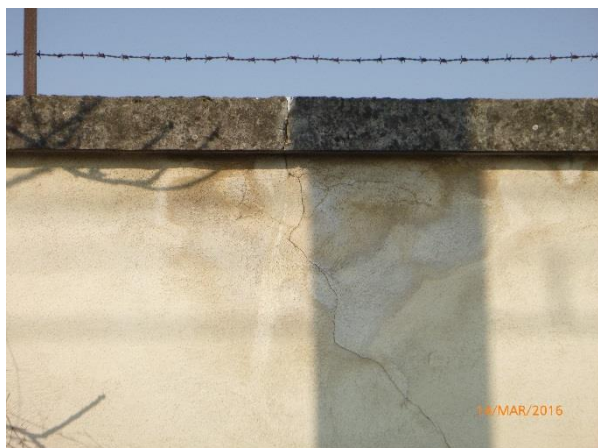
Photo 5 : Traces d'humidité et faïençage sous joint de casquette
