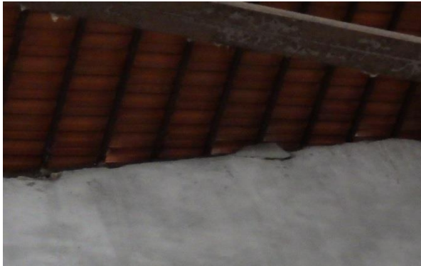
Décollements profonds avec risques de chute
