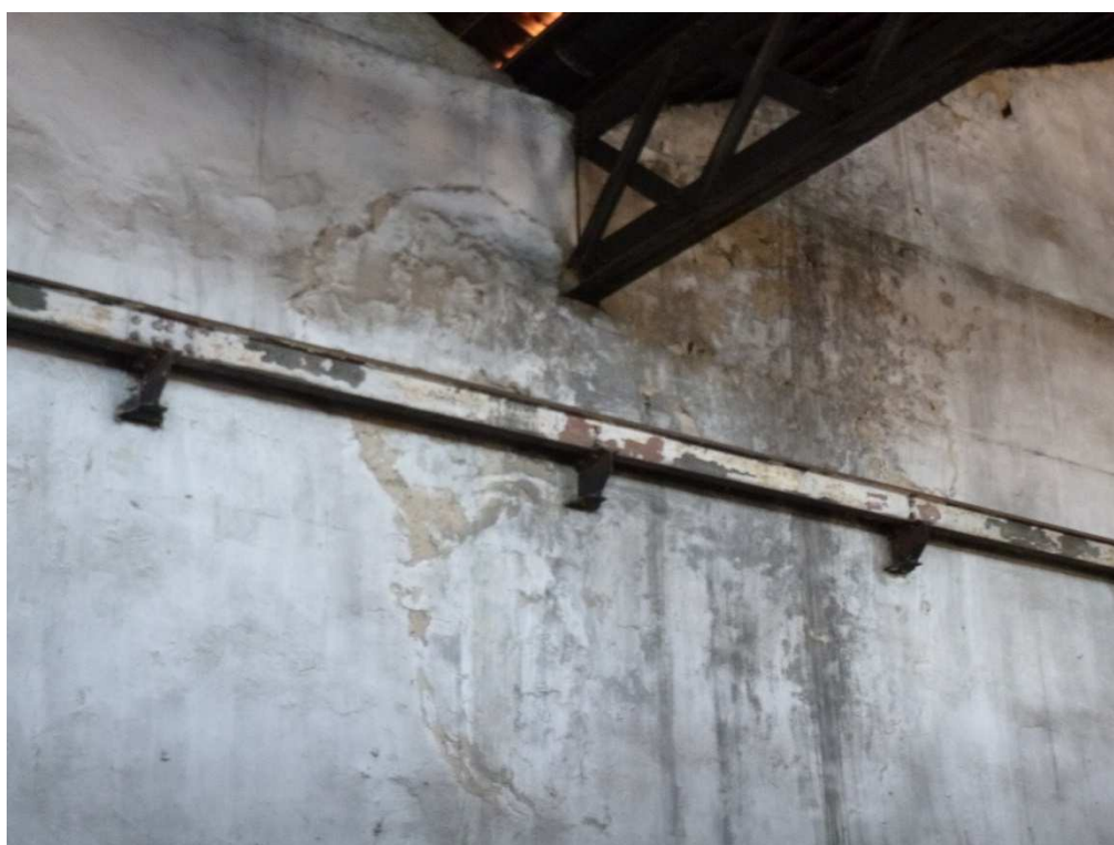
Photographie 14 : Trace d'humidité généralisé à la noue des travées
