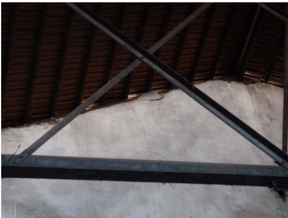
Photographie 16 : Travée 11 ; décollement avec risque de chute de gros éclat
