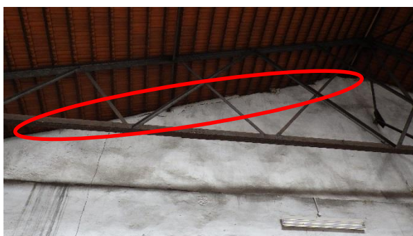
Photo 19 : Décollements profonds – risque de chute imminent
