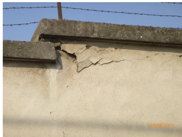
Photo 14 : Faïençage et décollement d'enduit
