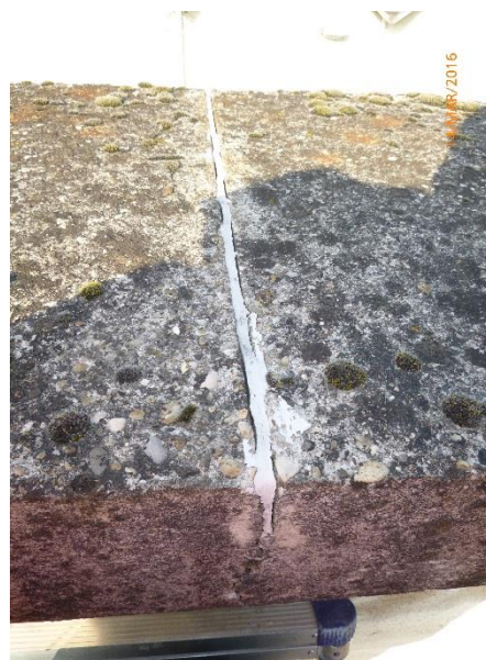
Photo 8 : Joint altéré
