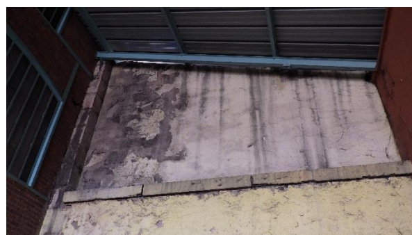
Photo 16 : Décollement d'enduit – Côté caserne
