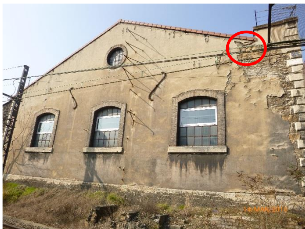
Photo 13 : Décollements d'enduit et pierre en saillie – travée 12
