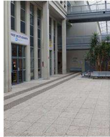
SOL EXISTANT DANS LA RUE INTÉRIEURE DALLES BÉTON DÉACTIVÉS 50X50CM
