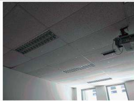
Prélèvement - P008 : R+1 / AILE C / CIRCULATION - Faux plafond- (Absence d'amiante)
