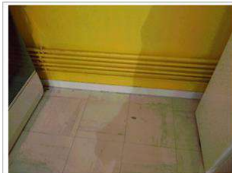
Prélèvement - P016 : RDC / AILE C / LOGEMENT 2 - Dalle de sol - EP- (Présence d'amiante)
