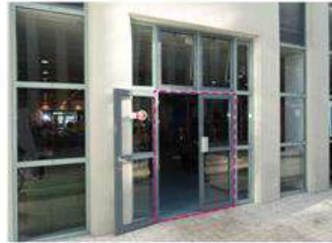
Remplacement à l'identique des ouvrants des ensembles vitrés donnant sur la rue intérieure.
