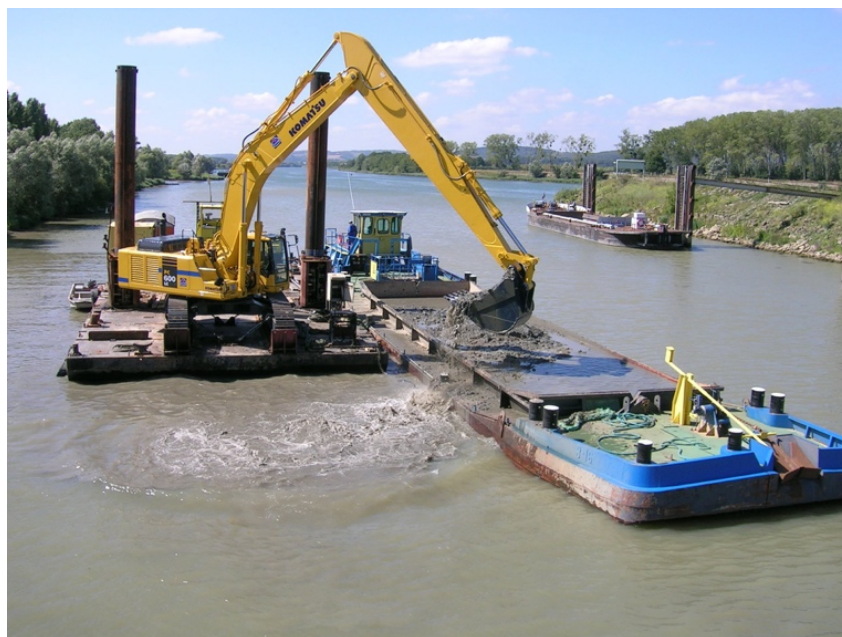
Figure 8 : Exemple de dragage mécanique avec barge autotractée
