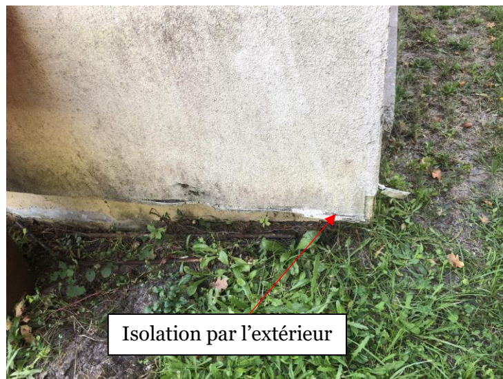
Figure 28 : Vue du pignon Nord, avec l'isolation par l'extérieur dégradée
