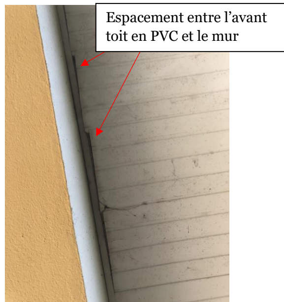
Figure 15 : Vue de l'espacement entre l'avant toit en PVC et le mur
