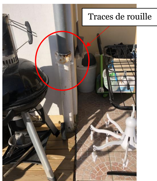
Figure 22 : Rouille sur une descente EP
