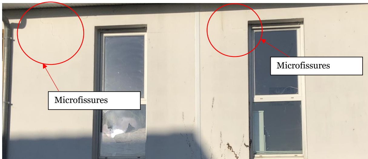
Figure 24 : Vue des microfissures sur la façade arrière
