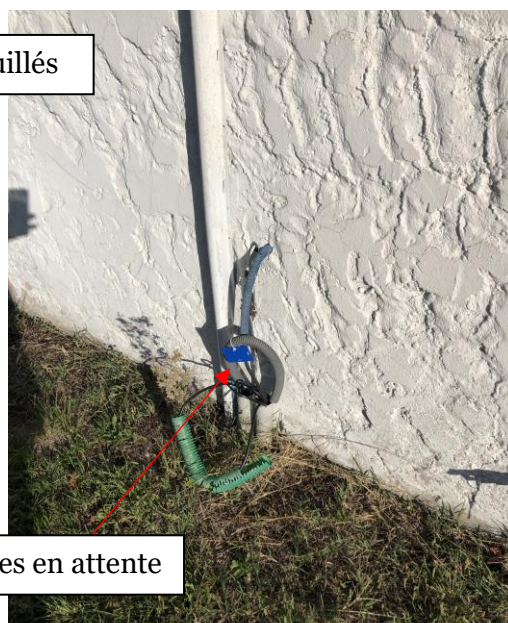
Figure 32 : Photo des gaines en attente sur la façade Sud
