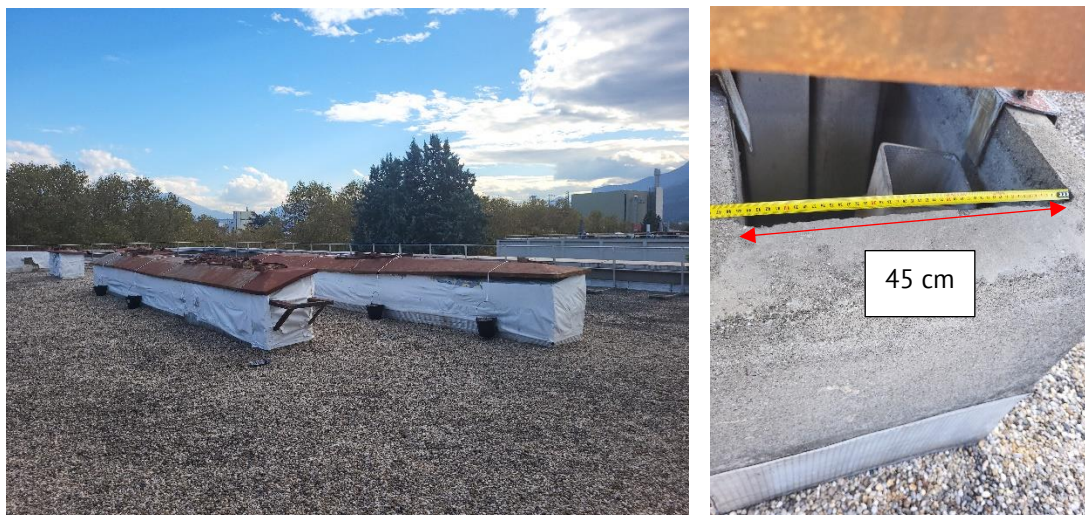
Photos des trémies en toiture utilisées pour passage des gaines de ventilation
