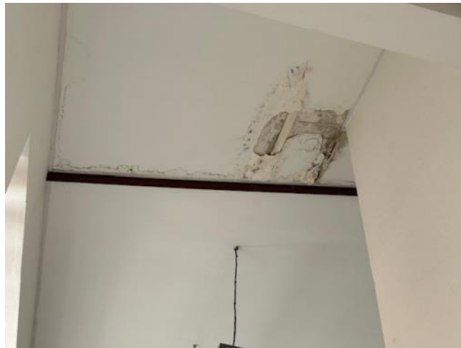
Bât A—Infiltrations en toiture
