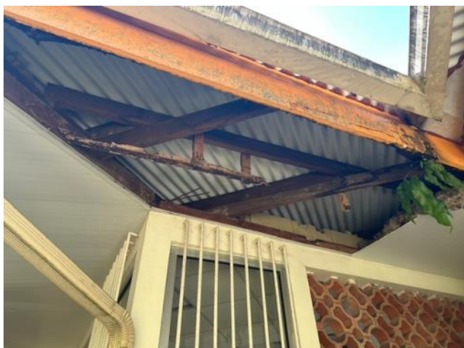
Bât A—Charpente en débord dégradée
