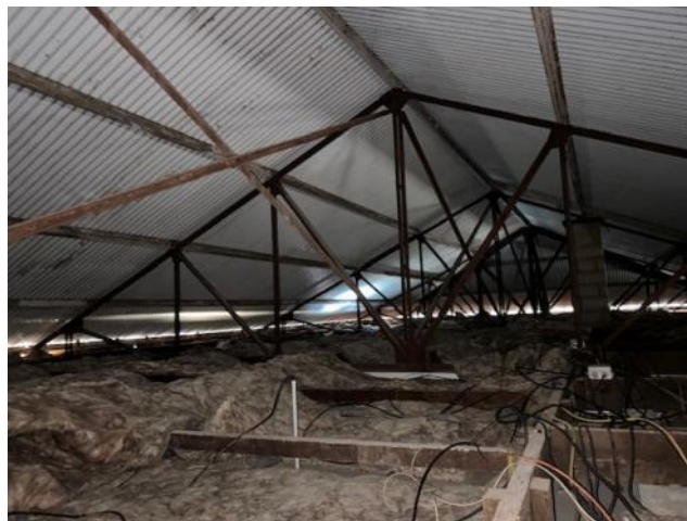
Bât C—Charpente métallique
