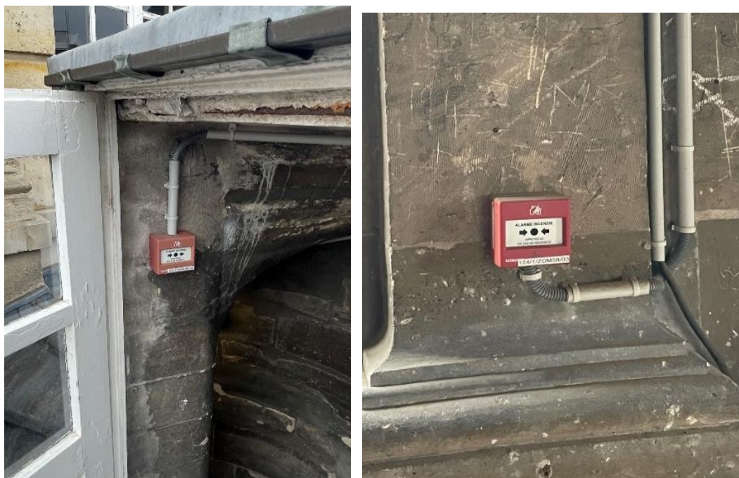
Déclencheur manuel
