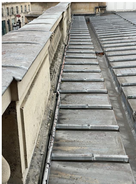
Câbles à déposer/reposer-remplacer
