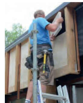
MISE EN OEUVRE DE PAREMENT PIERRE SUR MUR OSSATURE BOIS
