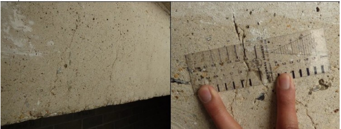
exemple de fissures
