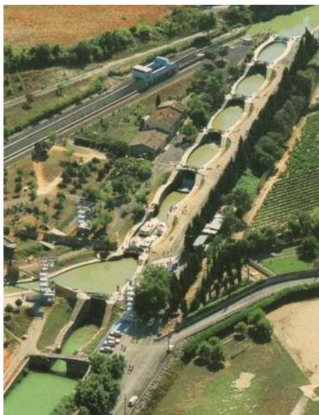
Figure 4 : écluses en chaîne et pente d'eau de Fonserannes
