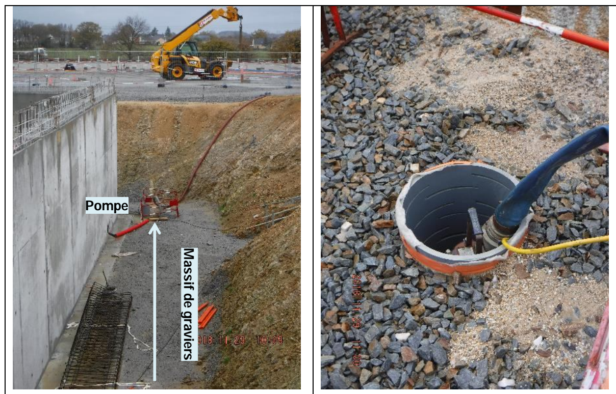
Figure 25 : Illustration d'un dispositif d'épuisement de nappe en fond de fouille (clichés Calligée)
