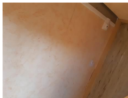
Matériaux : ZPSO-047 Prélèvement : P047 Description : Peinture enduit Mur Localisation : 1er étage - Chambre 021 Résultat : Absence d'amiante Quantité :
