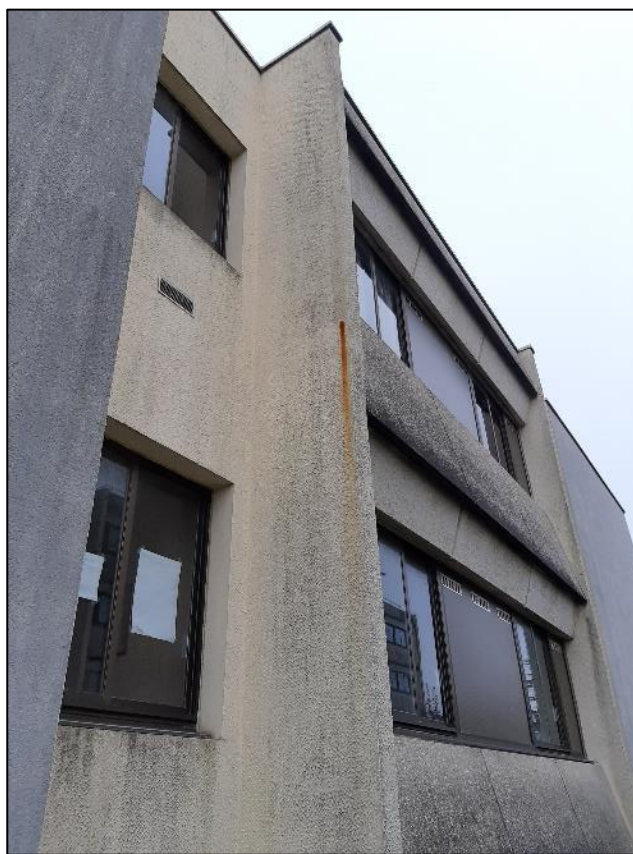
Traces de rouille sur le refend Nord de la façade Ouest probablement au droit d'un acier gonflant/corrodé
