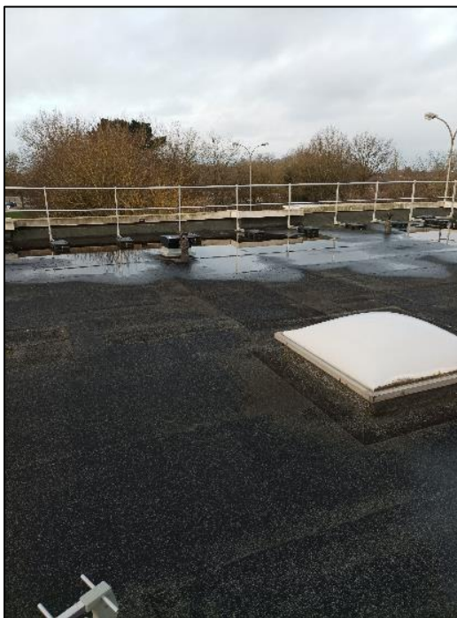
Etanchéité bitumineuse sur toiture terrasse
