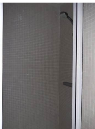
Matériaux : ZPSO-056 Prélèvement : P056 Description : Colle de faïence Localisation : 1er étage - Chambre 013 Résultat : Absence d'amiante Quantité :
