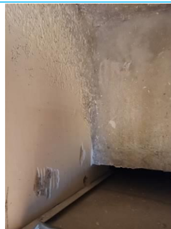
Matériaux : ZPSO-024 Prélèvement : P024 Description : Enduit à base de plâtre projeté Localisation : Rez de chaussée - Circulation 037 Résultat : Absence d'amiante Quantité :
