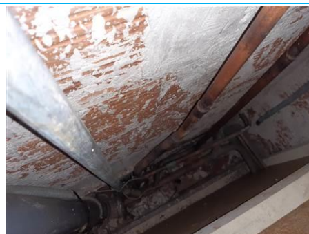
Matériaux : ZPSO-049 Prélèvement : P049 Description : Enduit à base de plâtre lissé ou taloché Localisation : 1er étage - Chambre 021 Résultat : Absence d'amiante Quantité :
