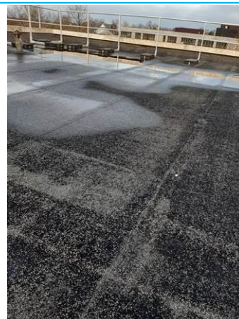
Matériaux : ZPSO-028 Prélèvement : P028 Description : Partie plane : revêtement bitumineux (bandes, lés...) Localisation : Toiture Résultat : Absence d'amiante Quantité :
