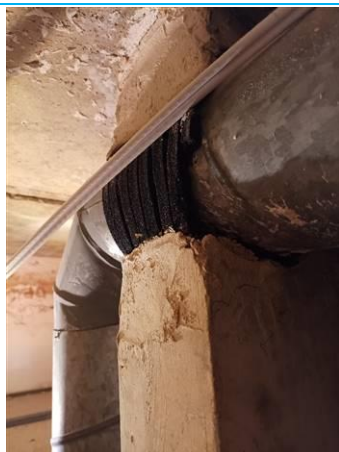
Matériaux : ZPSO-019 Prélèvement : P019 Description : Joint entre éléments Localisation : Rez de chaussée - Chambre 017 Résultat : Absence d'amiante Quantité :
