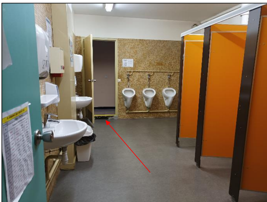
Sanitaires : seuil de 10 cm et surélévation du plancher côté sanitaires de 5 cm par rapport au couloir
