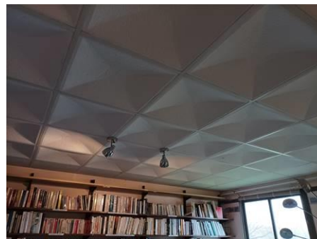
Matériaux : ZPSO-008 Prélèvement : P008 Description : Panneaux et plaques Localisation : Rez de chaussée - Salle TELE 023 Résultat : Absence d'amiante Quantité :
