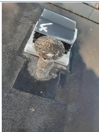
Matériaux : ZPSO-031 Prélèvement : P031 Description : Conduit de ventilation Localisation : Toiture Résultat : Présence d'amiante Quantité :
