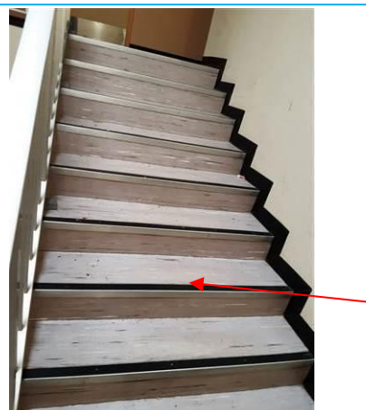
Matériaux : ZPSO-057 Prélèvement : P057 Description : Nez de marche Localisation : Rez de chaussée - Escalier 001; Résultat : Présence d'amiante Quantité :
