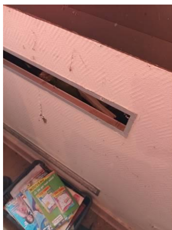
Matériaux : ZPSO-003 Prélèvement : P003 Description : Peinture Mur Localisation : Rez de chaussée - Salle TELE 023 Résultat : Absence d'amiante Quantité :
