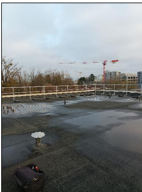
Etanchéité bitumineuse sur toiture terrasse
