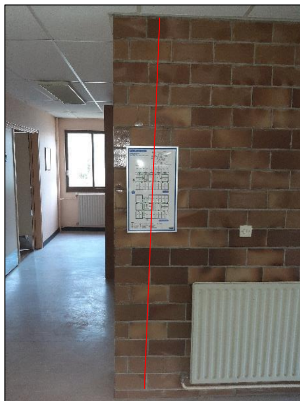
Fissure verticale sur l'habillage au niveau de l'entrée Nord
