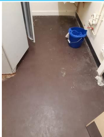
Matériaux : ZPSO-042 Prélèvement : P042 Description : Lés plastique + colle + ragréage Localisation : Rez de chaussée - Lingerie 011 Résultat : Absence d'amiante Quantité :
