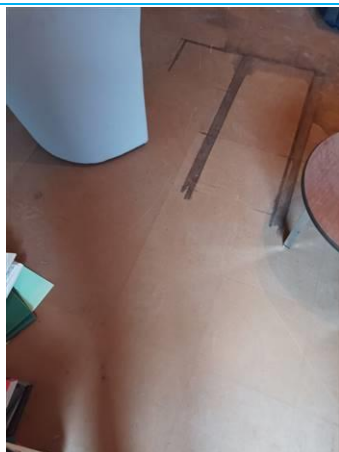
Matériaux : ZPSO-001 Prélèvement : P001 Description : Dalle de sol + colle + ragréage Localisation : Rez de chaussée - Salle TELE 023 Résultat : Absence d'amiante Quantité :
