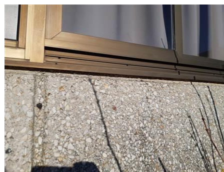
Matériaux : ZPSO-061 Prélèvement : P061 Description : Joint d'étanchéité entre menuiserie et structure Localisation : Parties extérieures Résultat : Absence d'amiante Quantité :
