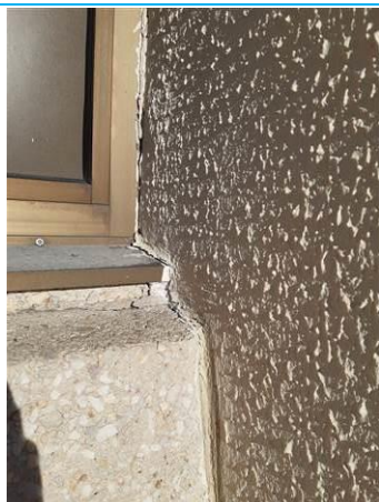
Matériaux : ZPSO-058 Prélèvement : P058 Description : Joint d'étanchéité Localisation : Parties extérieures Résultat : Absence d'amiante Quantité :
