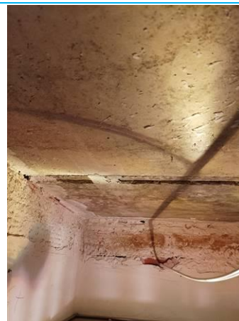
Matériaux : ZPSO-020 Prélèvement : P020 Description : Ragraage Localisation : Rez de chaussée - Chambre 017 Résultat : Absence d'amiante Quantité :
