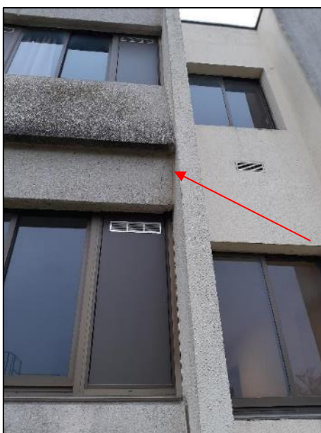
Fissure ponctuelle sur un panneau de façade Est
