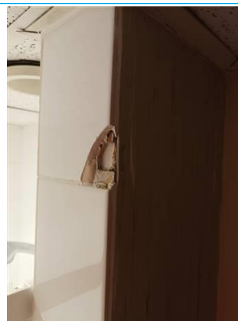
Matériaux : ZPSO-022 Prélèvement : P022 Description : Colle de faïence Localisation : Rez de chaussée - Chambre 017 Résultat : Absence d'amiante Quantité :
