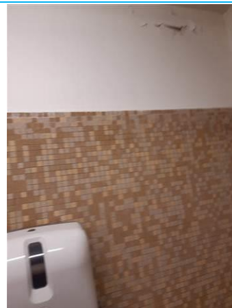
Matériaux : ZPSO-039 Prélèvement : P039 Description : Peinture enduit Mur Localisation : Rez de chaussée - Sanitaire 010 Résultat : Absence d'amiante Quantité :
