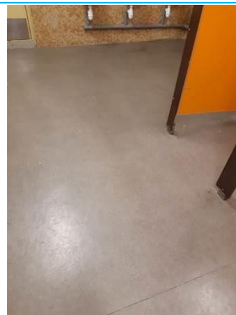
Matériaux : ZPSO-037 Prélèvement : P037 Description : Lés plastique + colle + ragréage Localisation : Rez de chaussée - Sanitaire 010 Résultat : Absence d'amiante Quantité :
