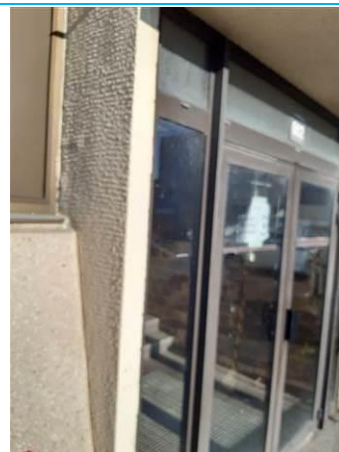
Matériaux : ZPSO-059 Prélèvement : P059 Description : Enduit extérieur (projeté, lissé ou taloché) Localisation : Parties extérieures Résultat : Absence d'amiante Quantité :
