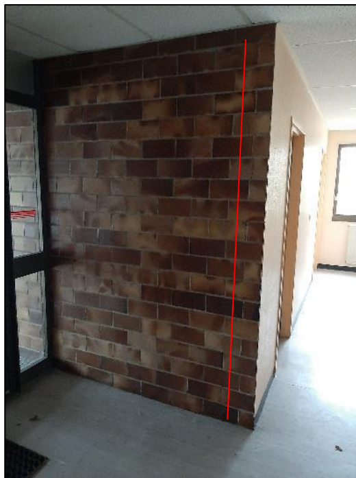
Fissure verticale sur l'habillage au niveau de l'entrée Sud
