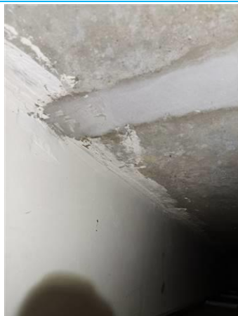
Matériaux : ZPSO-009 Prélèvement : P009 Description : Ragréage Localisation : Rez de chaussée - Salle TELE 023 Résultat : Absence d'amiante Quantité :
