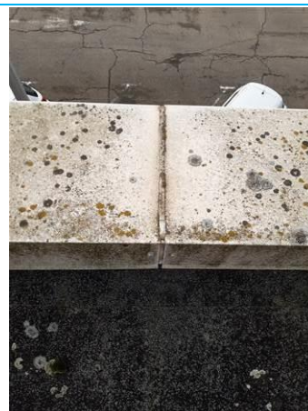
Matériaux : ZPSO-033 Prélèvement : P033 Description : acrotère Localisation : Toiture Résultat : Absence d'amiante Quantité :
