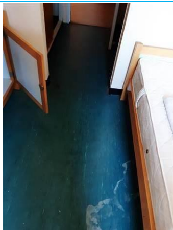
Matériaux : ZPSO-052 Prélèvement : P052 Description : Lés plastique + colle + ragréage Localisation : 1er étage - Chambre 013 Résultat : Absence d'amiante Quantité :
