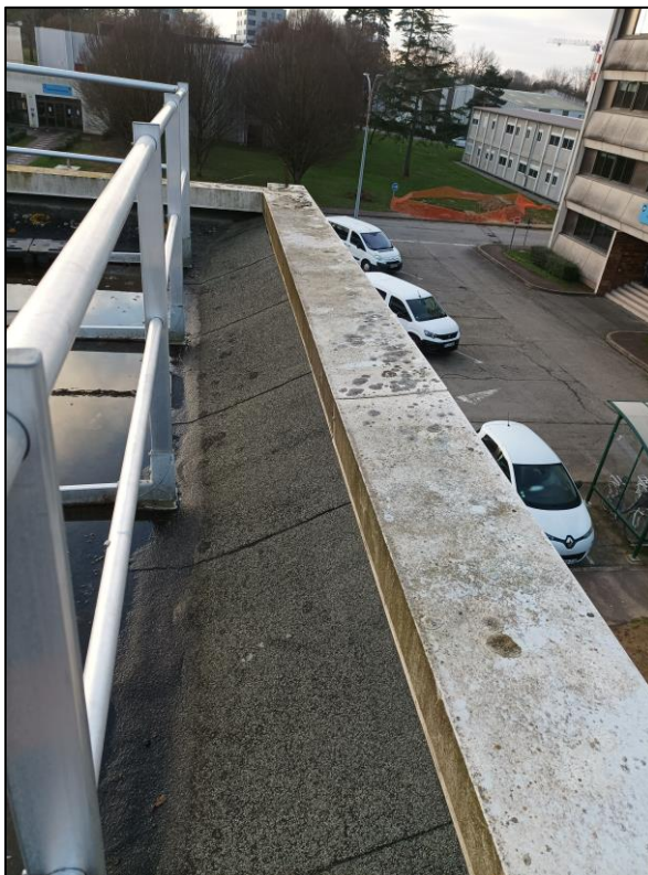
Etanchéité sur support en pente / Etat de vieillissement plus avancé
