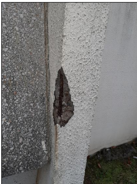
Eclat avec acier apparent sur le refend Nord de la façade Est
