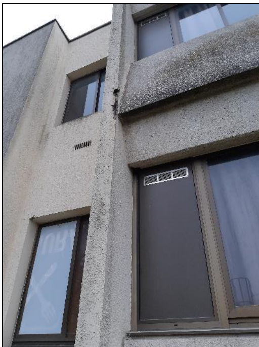
Eclat avec acier apparent sur le refend Sud de la façade Est
